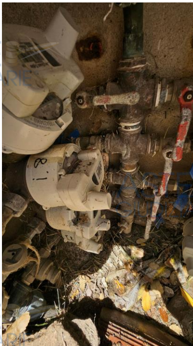
Vista allaccio contatore rete idrica
