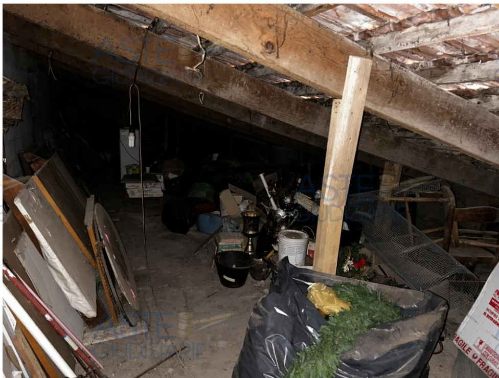
Vista del locale soffitta
