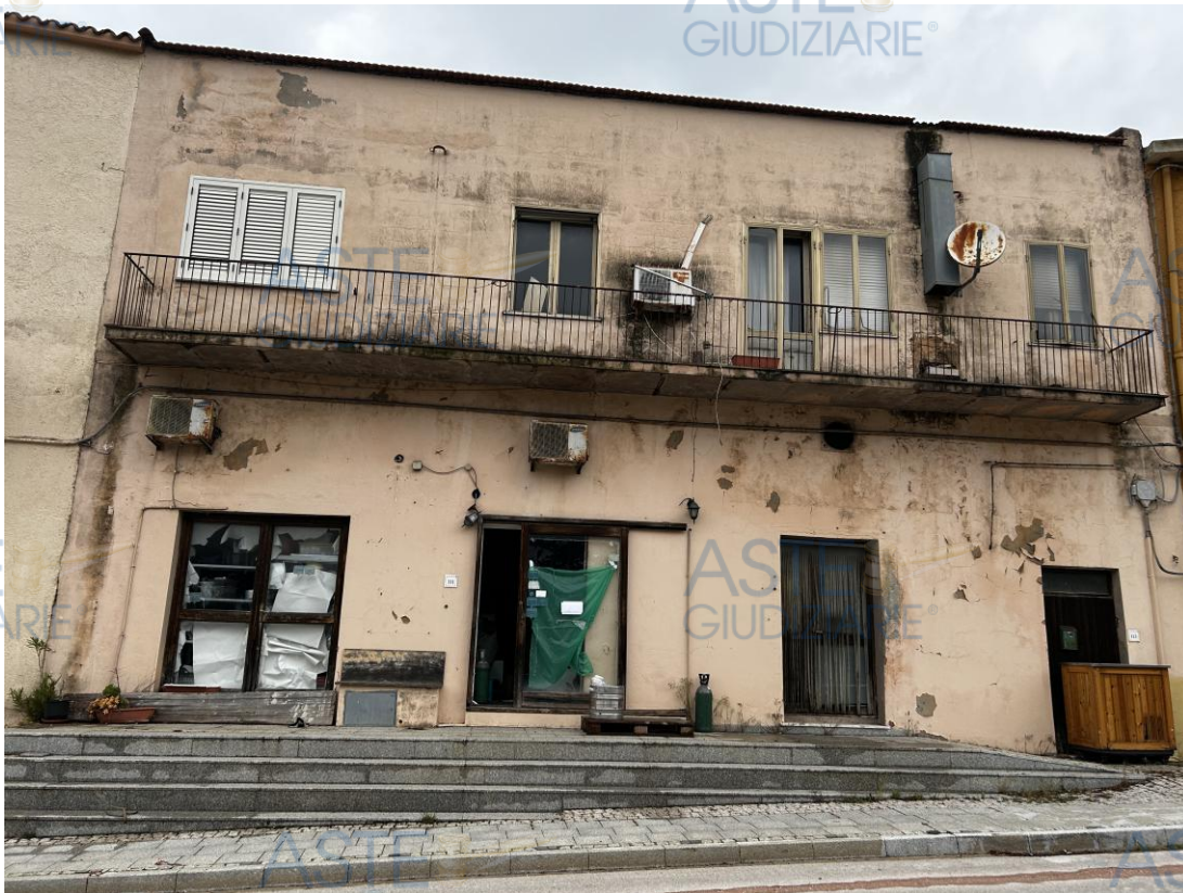
Foto della facciata esterna dell'immobile
