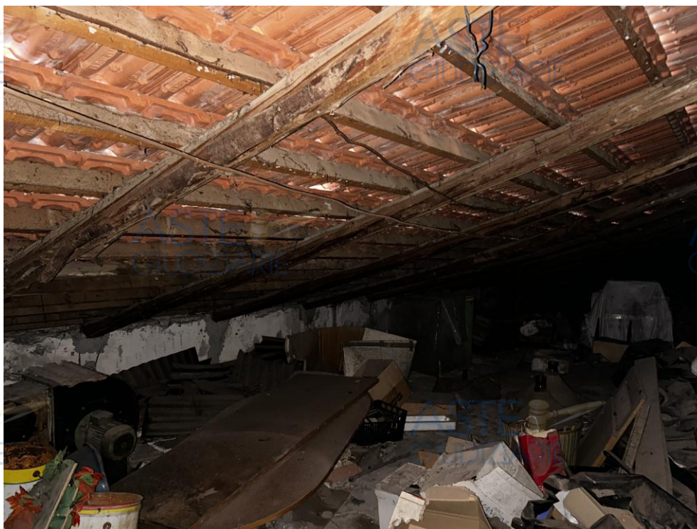
Vista del locale soffitta
