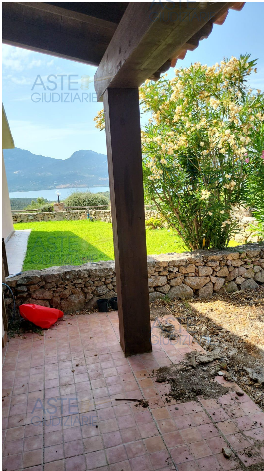
Foto 3 – muro di confine con la particella 2561
