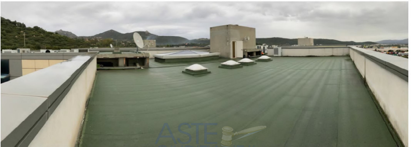
Vista del lastrico solare
