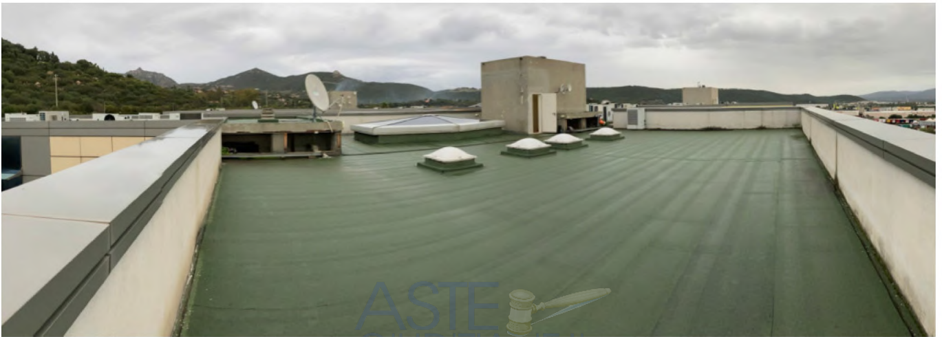
Vista del lastrico solare
