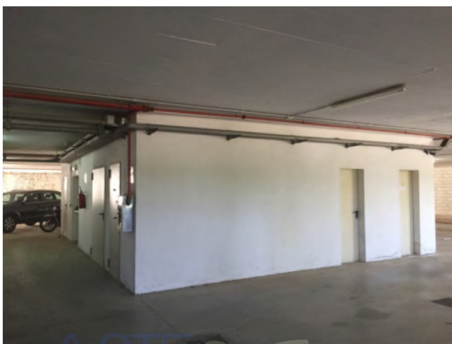
vista dei locali di deposito
