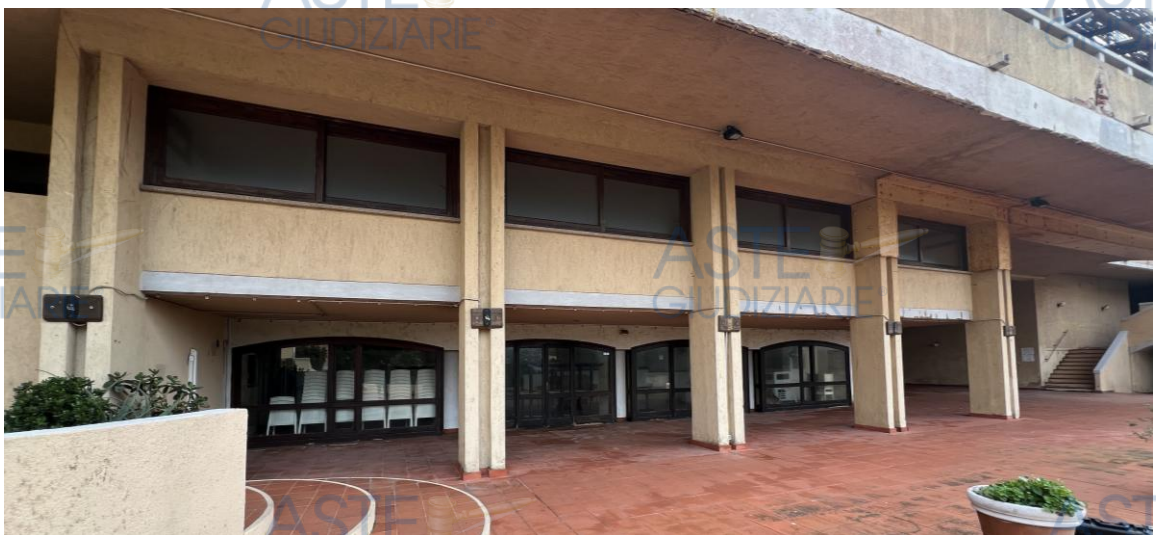
Figura 4 – vista frontale del bene
