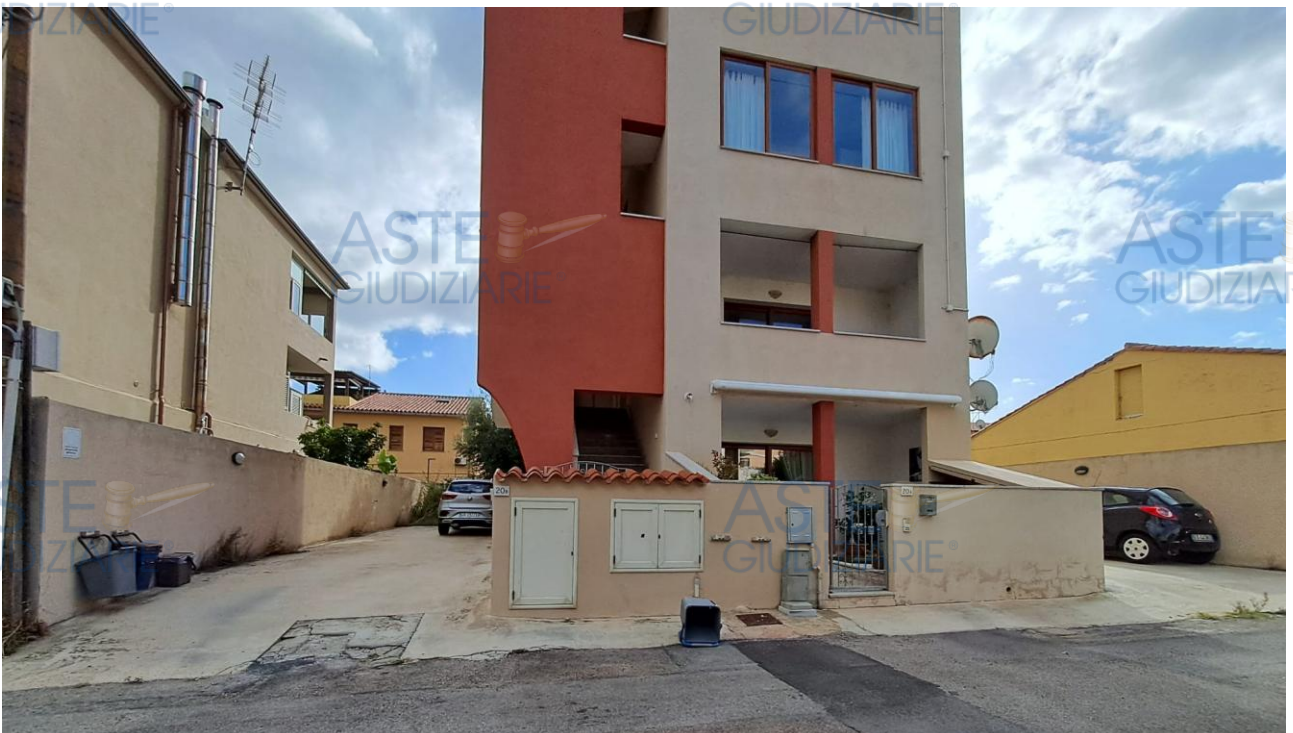
Figura 2: L'immobile in oggetto si trova al primo piano dell'edificio. Sulla sinistra della foto il posto auto di pertinenza
