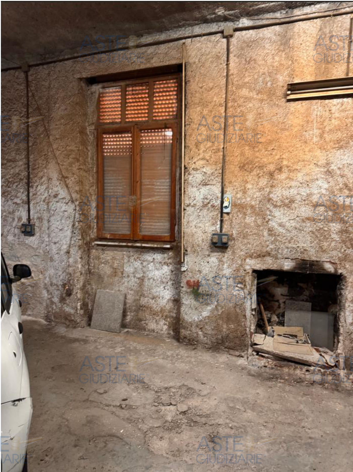
Foto 15: finestra nel garage lato nord
