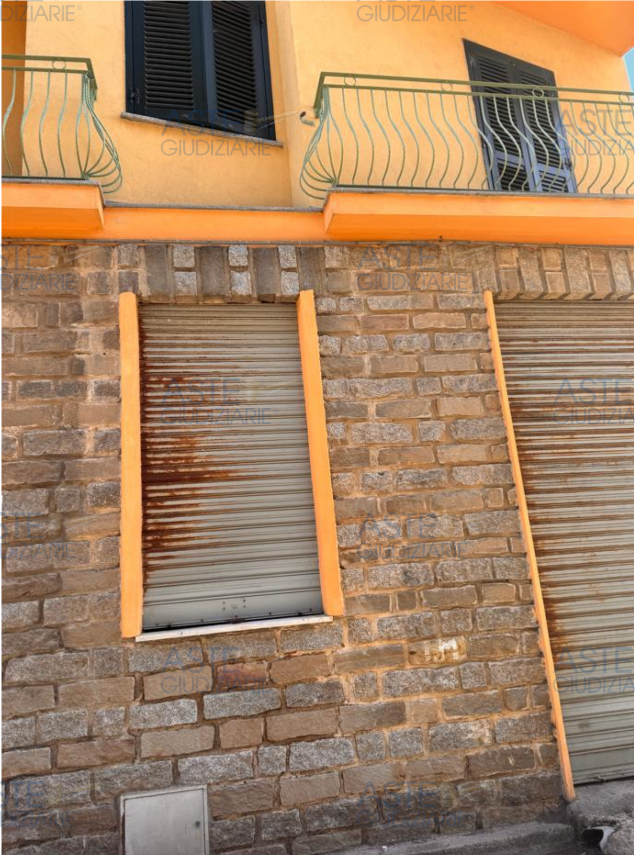
Foto 17: Vista esterna del garage a Piano Terra e dell'appartamento al Piano Primo
