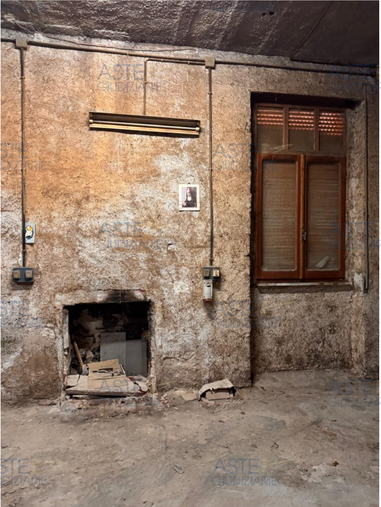
Foto 16: Finestra del garage lato ovest
