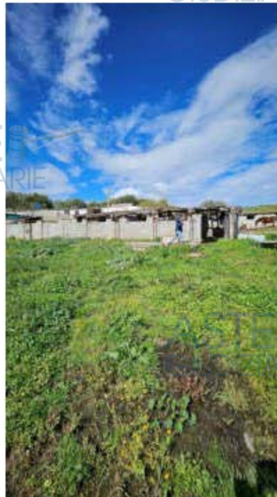
Vista mappale 564 e struttura precaria
