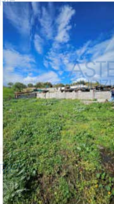
Vista mappale 564 e struttura precaria
