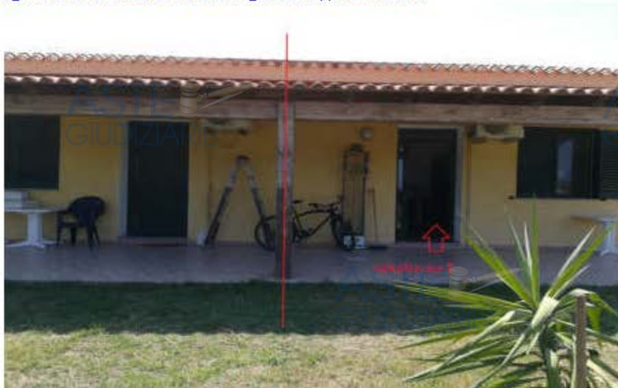
1) Vista prospetto Ovest
