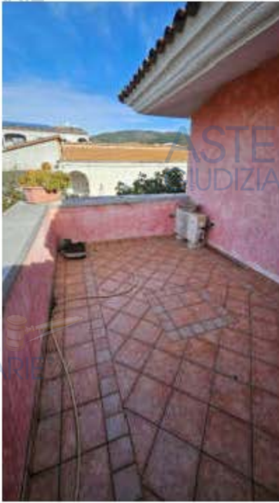
Terrazza accesso da Ambiente soppalco
