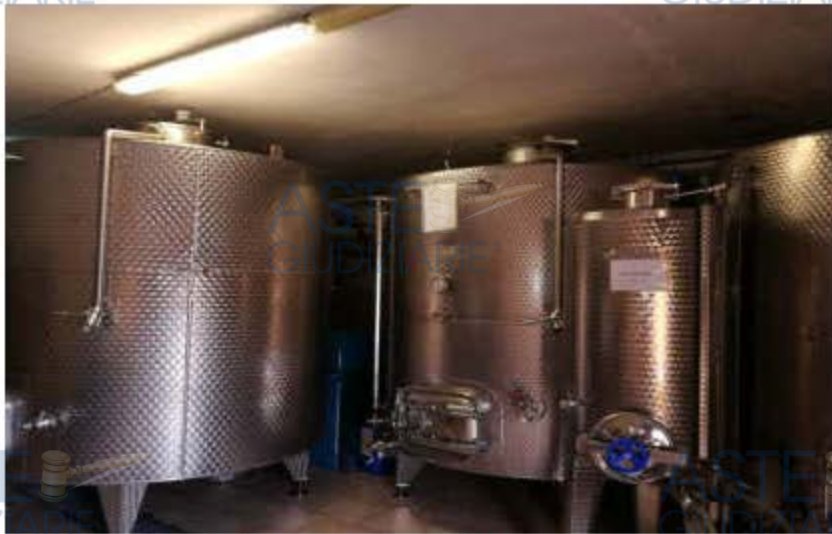
Vista 3 ambiente magazzino
