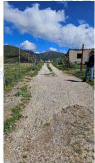
Vista accesso terreno mappale 373
