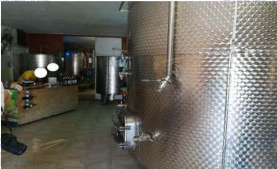
Vista 1 ambiente magazzino
