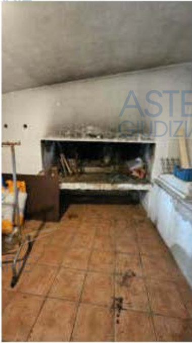
Sgombero (ingresso da tettoia)
