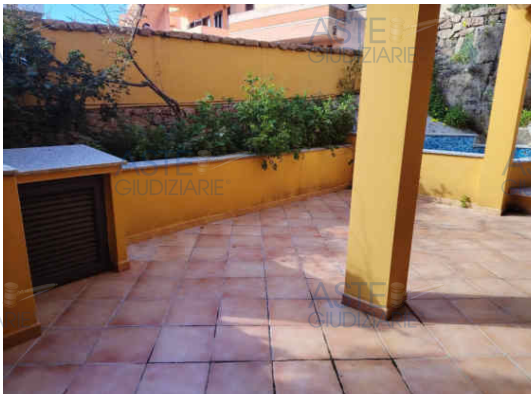
Foto n° 13 – Patio esterno fronte ingresso
