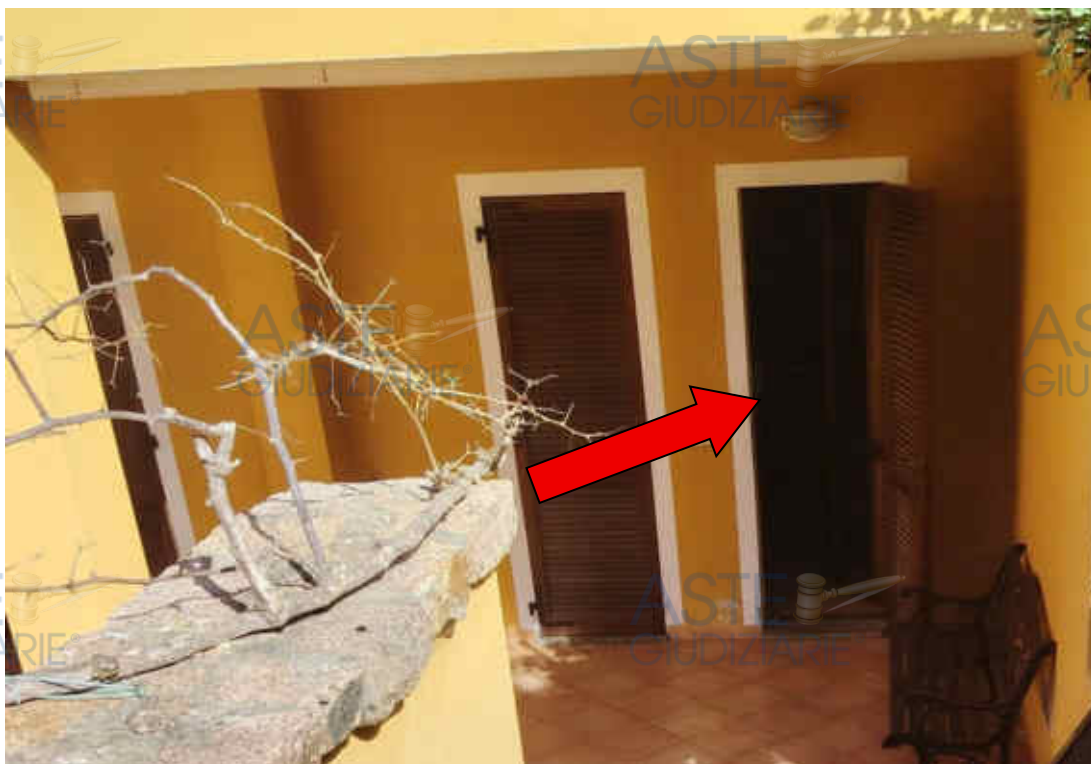
Foto n° 5 – Accesso all'immobile cortile esterno – portoncino ingresso lato dx foto
