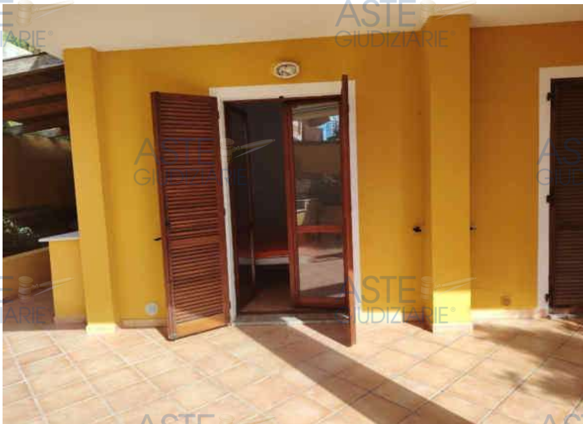
Foto n° 7 – Accesso porta finestra camera da letto
