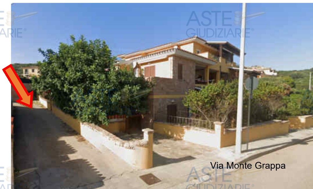
Foto n° 1 – Accesso all'immobile dalla strada
