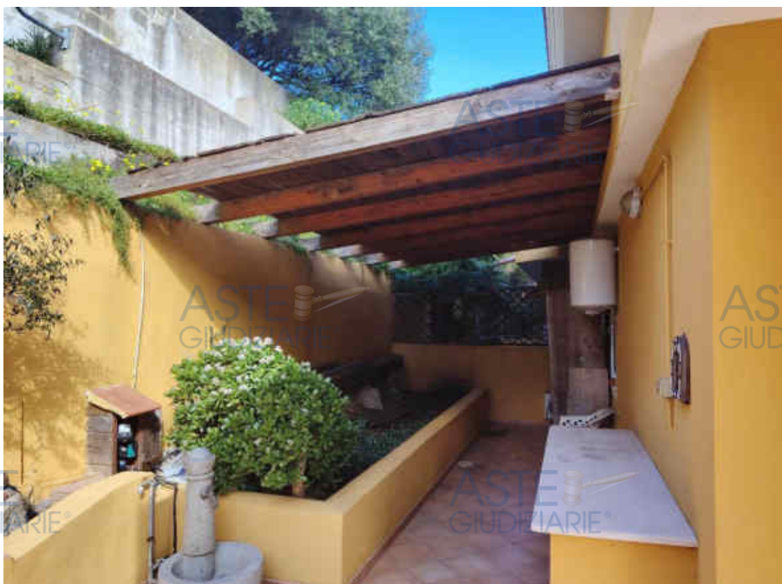
Foto 8 – Veranda coperta lato sx ingresso
