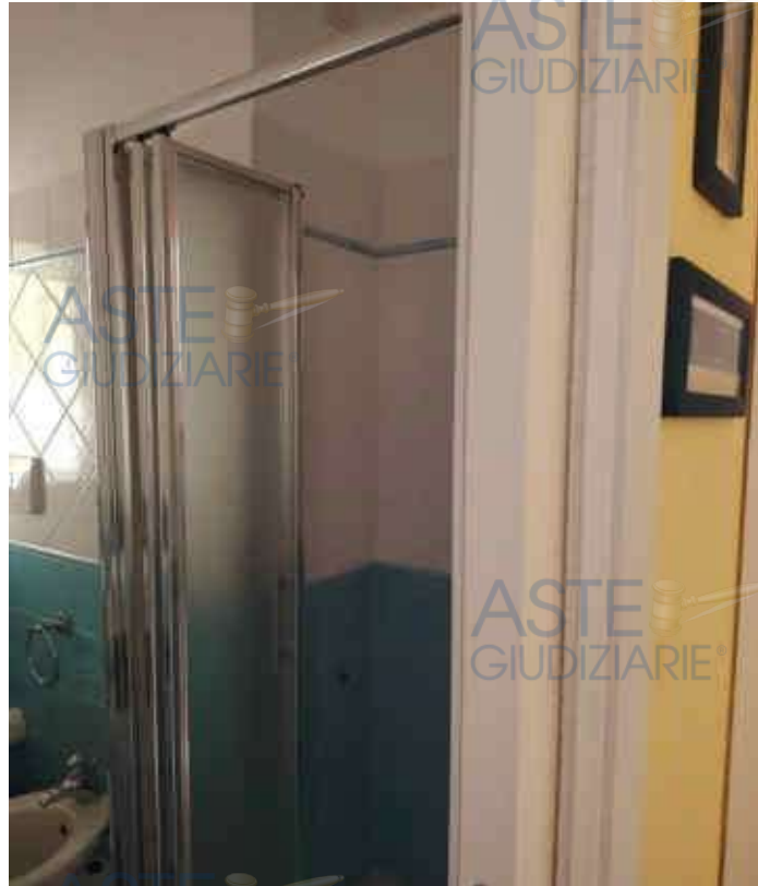
Foto 25 – Bagno – dettaglio doccia
