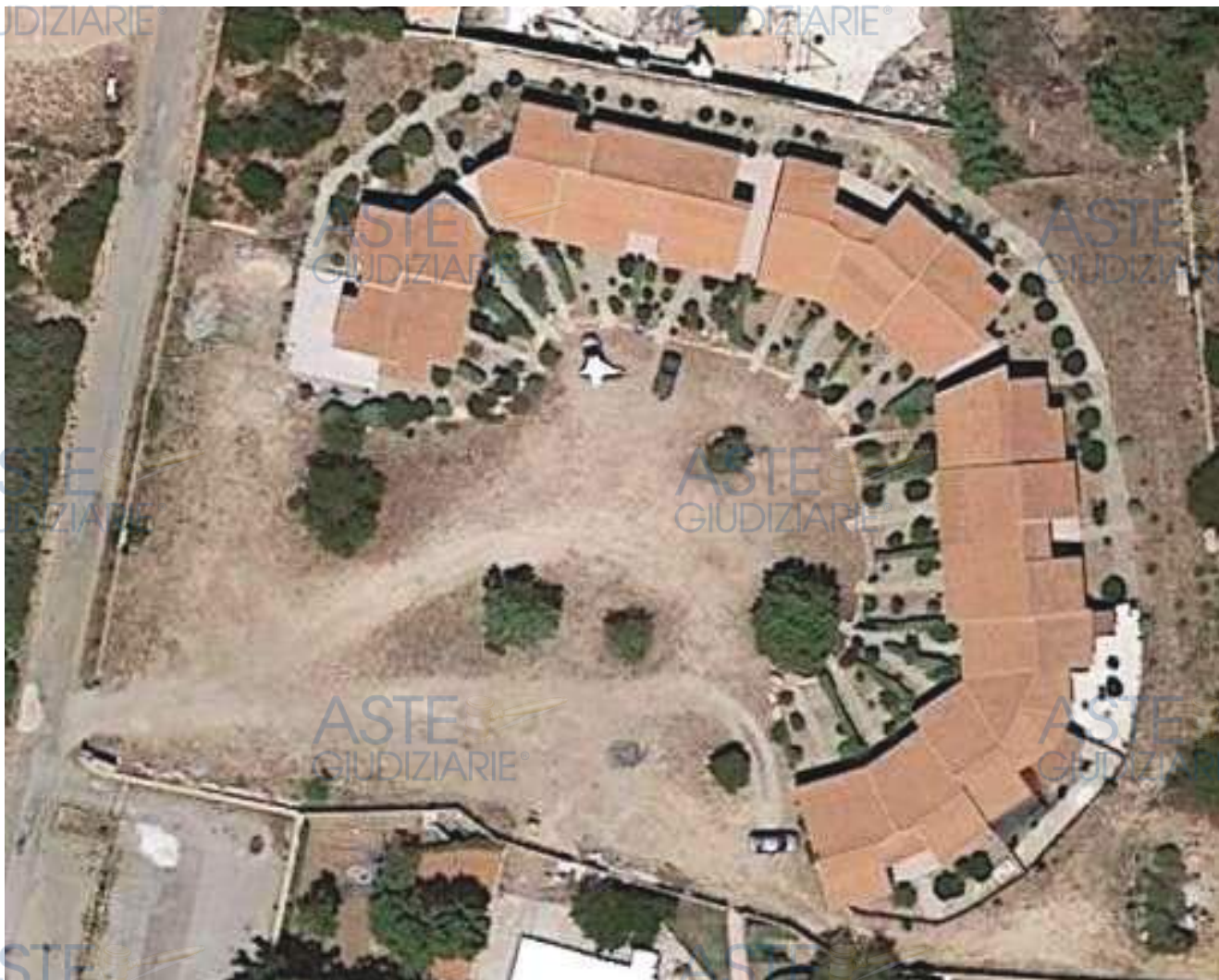
Figura 11 – Vista degli appartamenti facenti parte del Lotto S2 Sporting Center
