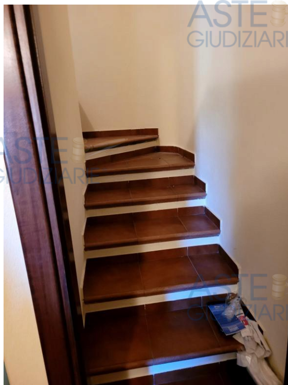
Scala di accesso al sottotetto
