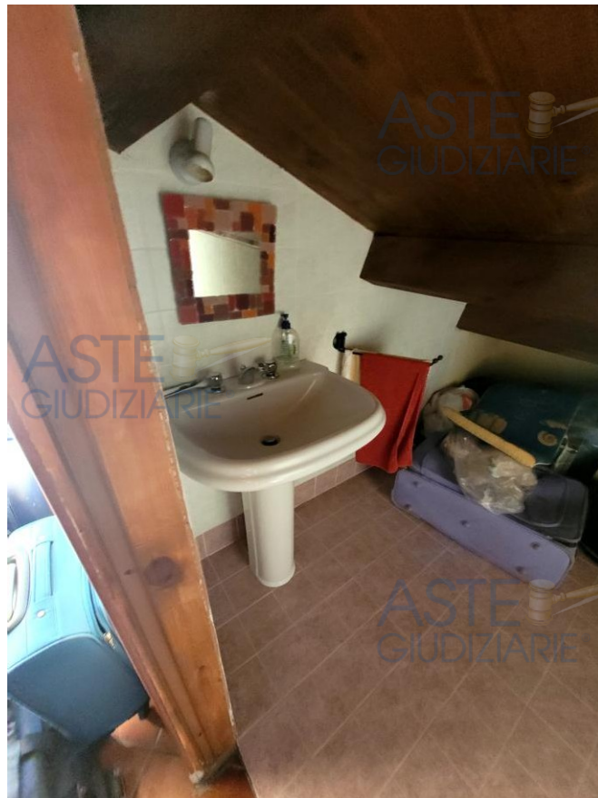
Bagno del sottotetto
