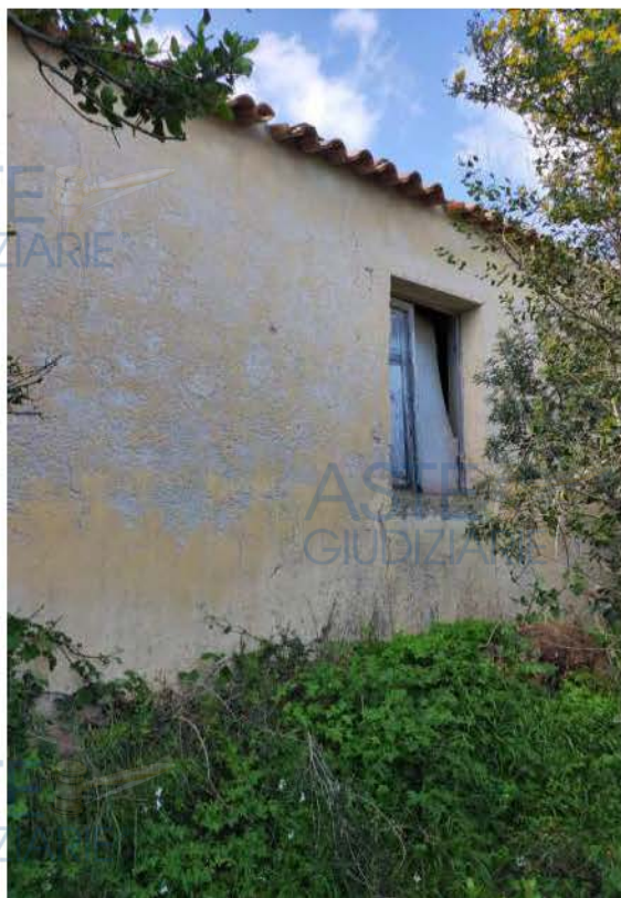
Scorci del prospetto a nord.
