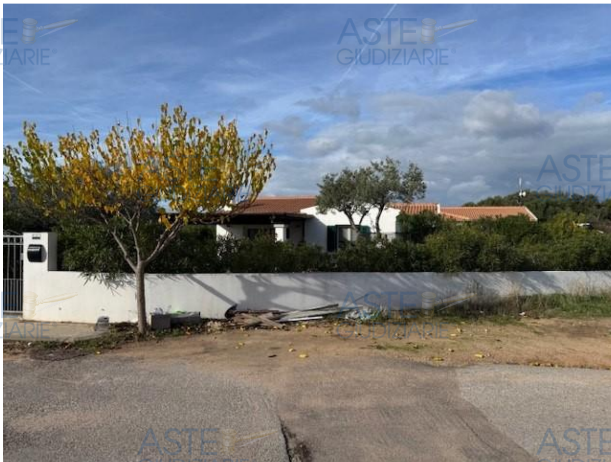
VISTA DALLA VIA..... VISTA VERSO IL PROSPETTO PRINCIPALE
