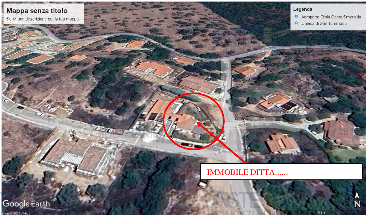
VISTA AEREA - INQUADRAMENTO IMMOBILI OGGETTO DI PIGNORAMENTO
