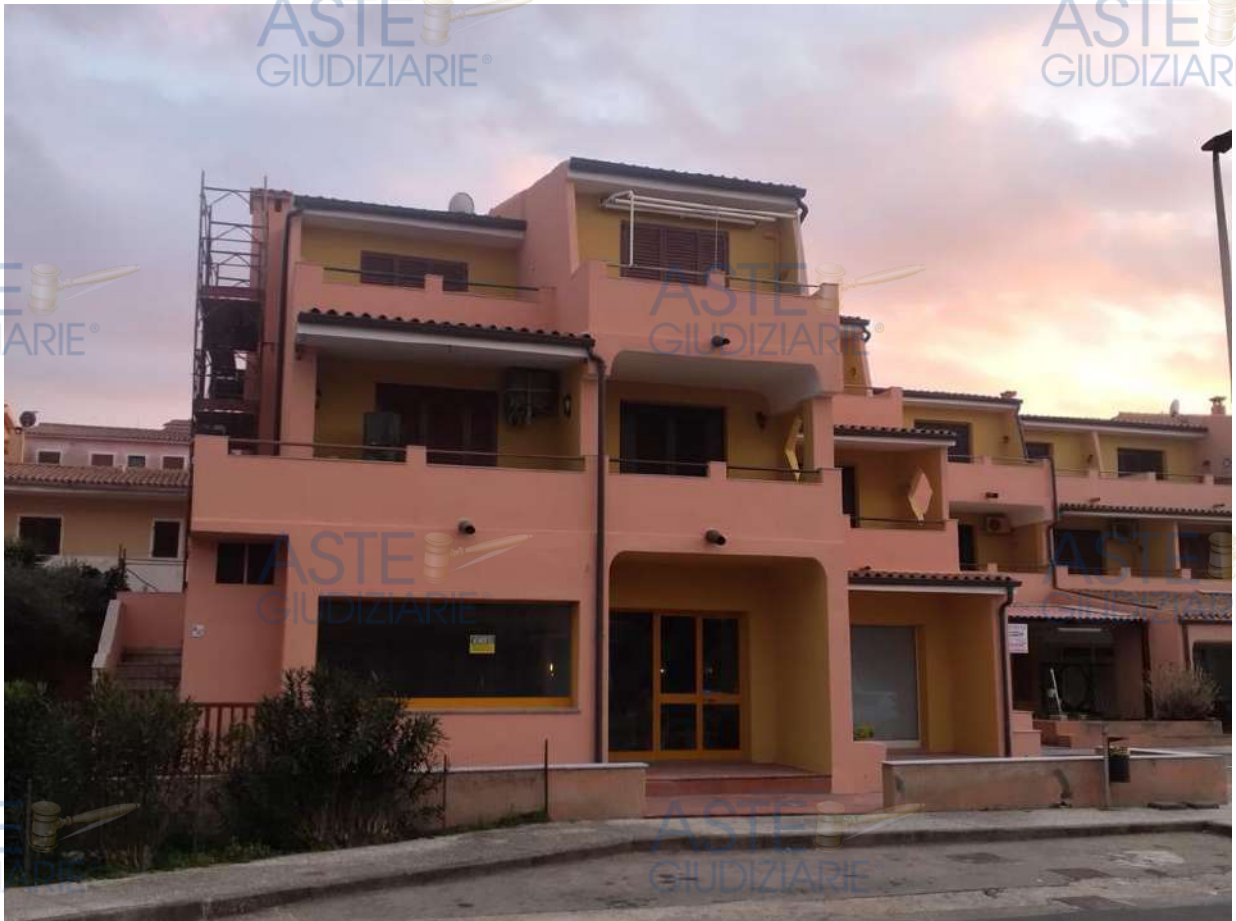
Foto 1 - Prospetto principale su via A. Moro dove sono evidenti gli interventi di tinteggiatura facciate.
