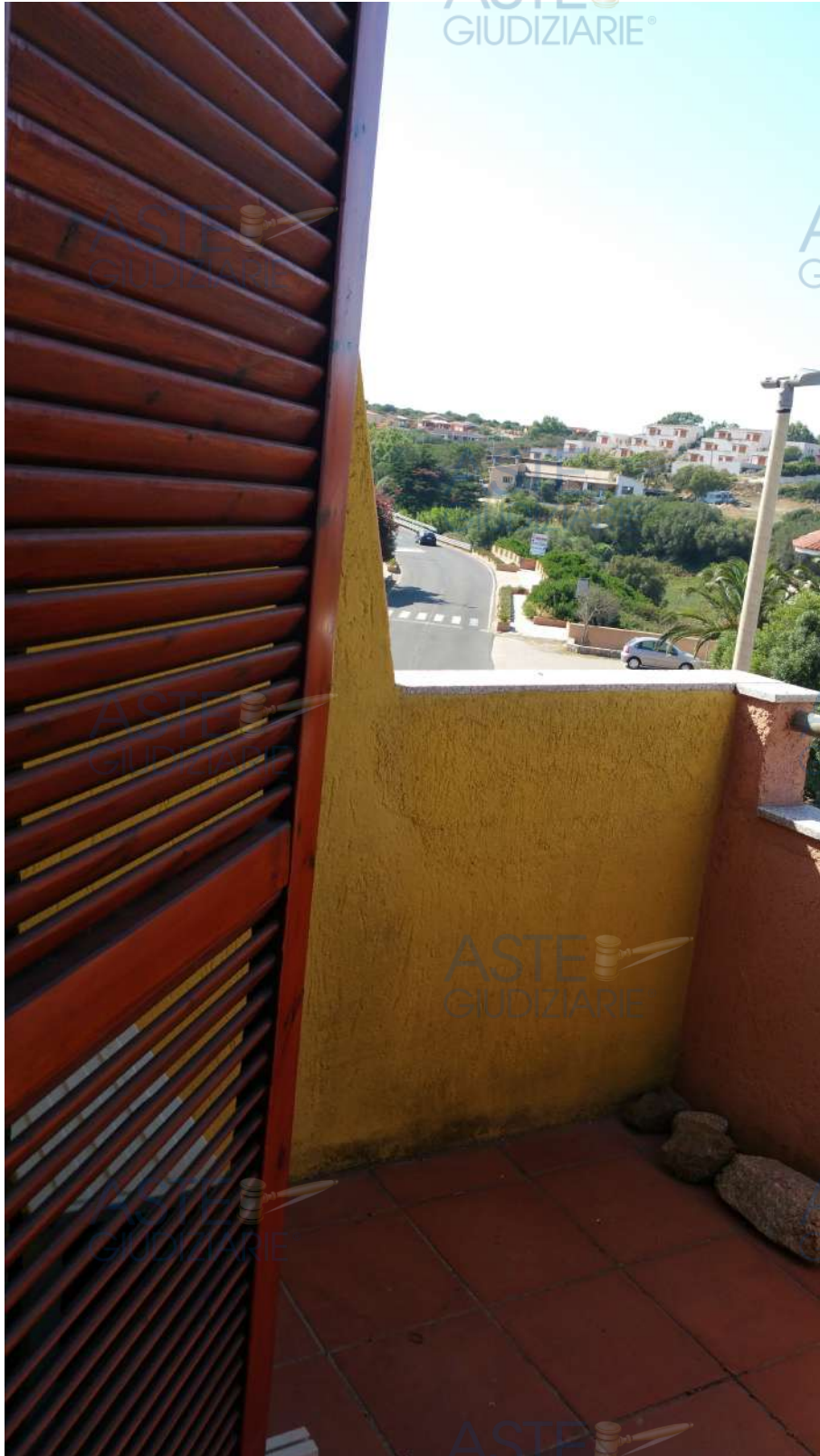
Foto 10 - Balcone camera da letto
