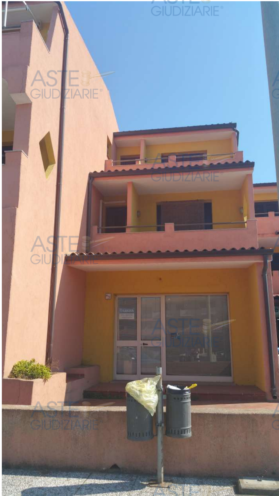
Foto 1 - Prospetto principale su via A. Moro
