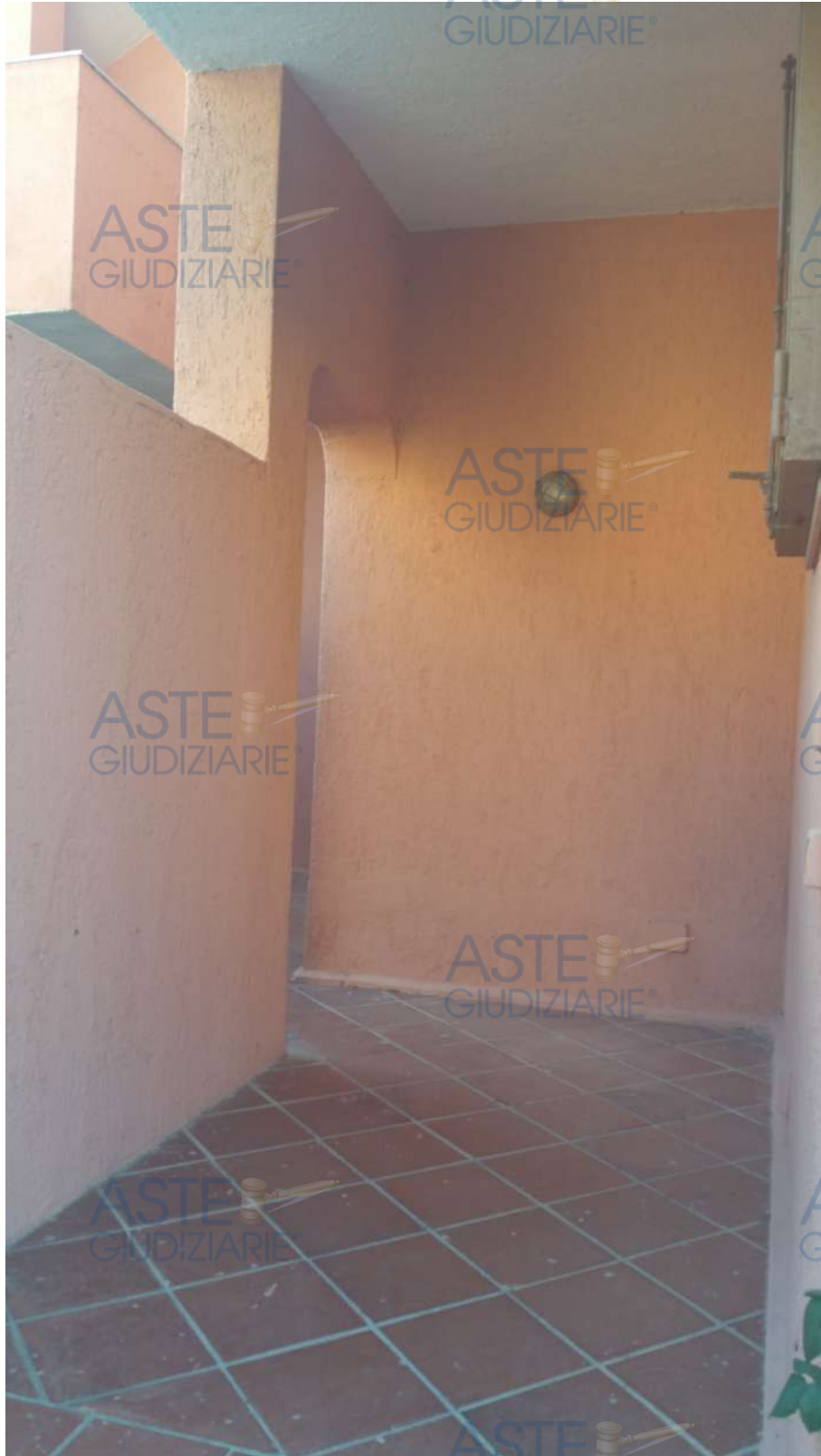
Foto 2 - Ingresso comune agli appartamenti
