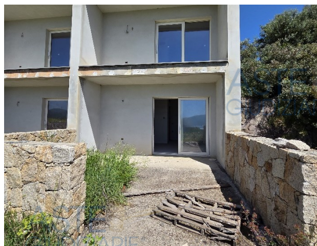
Figura 25 - Unità residenziali, ingresso piano seminterrato
