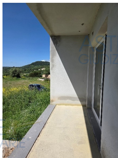
Figura 30 - Balcone tipo, piano terra
