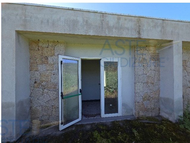
Figura 24 - Unità residenziali, ingresso piano terra
