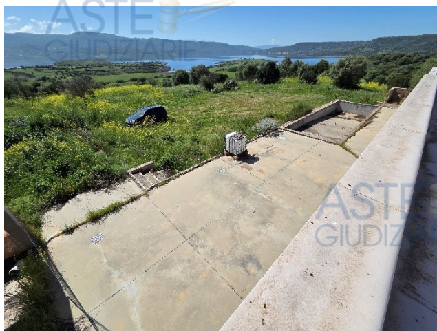
Figura 11 - Vista dal tetto dell'unità bar -ristorante
