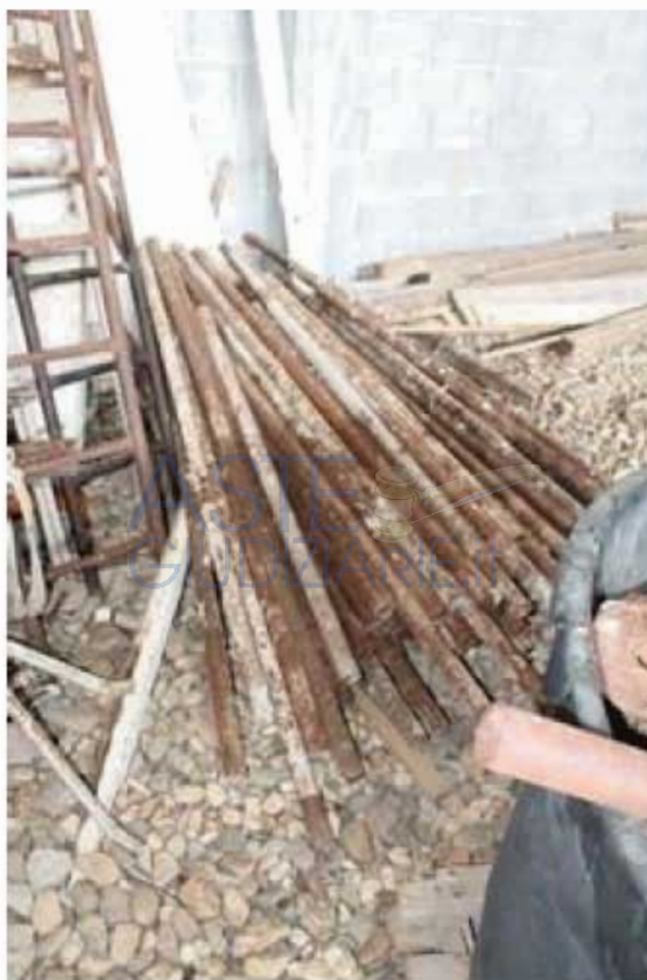
Foto 71 – Catasta di elementi tubolari per ponteggio.
