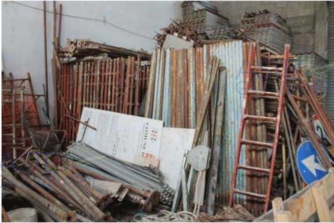
Foto 56 – Altri cavalletti di ponteggio ad H, anche questi di difficile conteggio, 62 visibili in foto e non conformi a d.lgs. 81-08.
