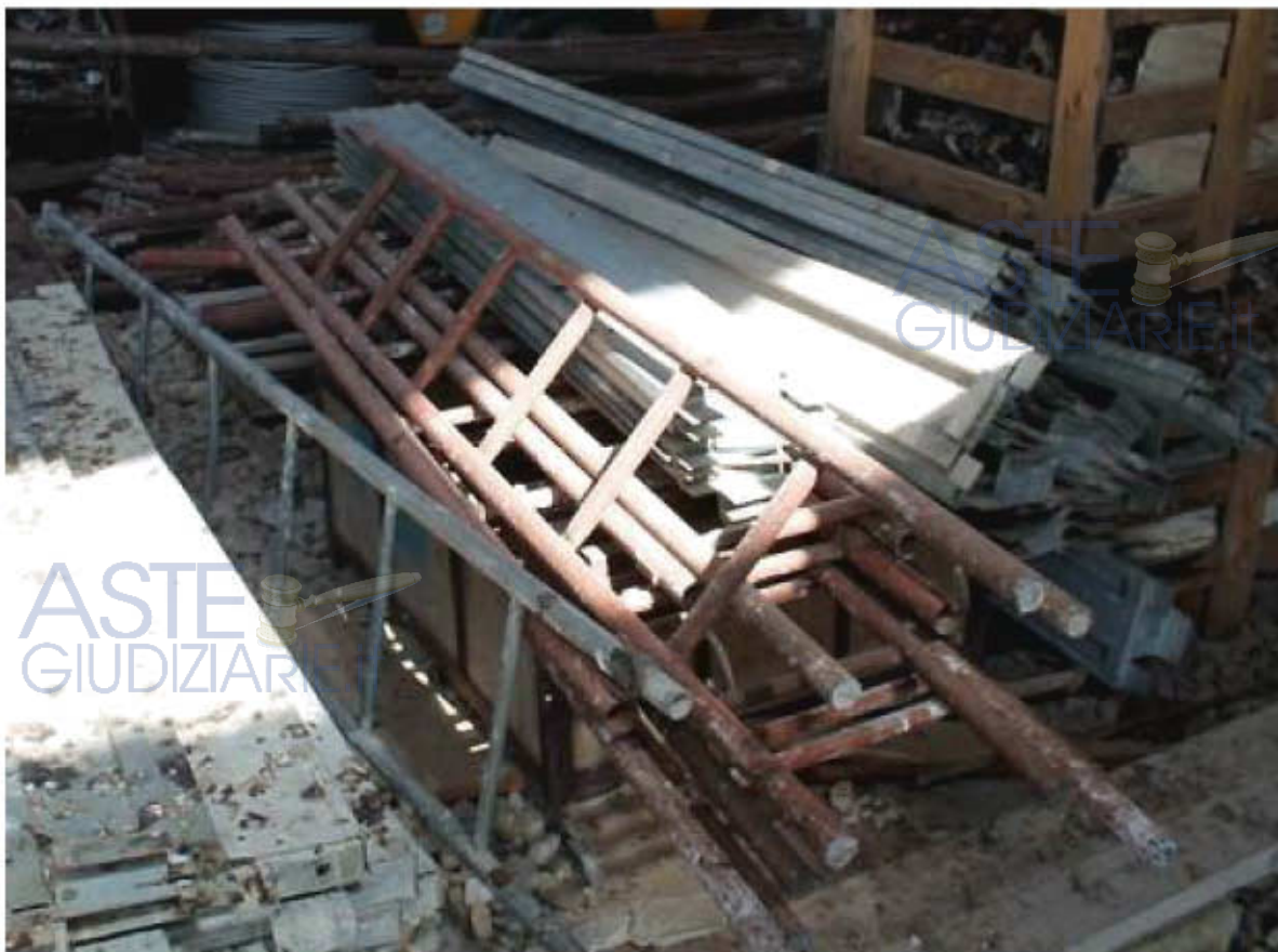
Foto 74 – Scalette da ponteggio e pannelli fermapiede.
