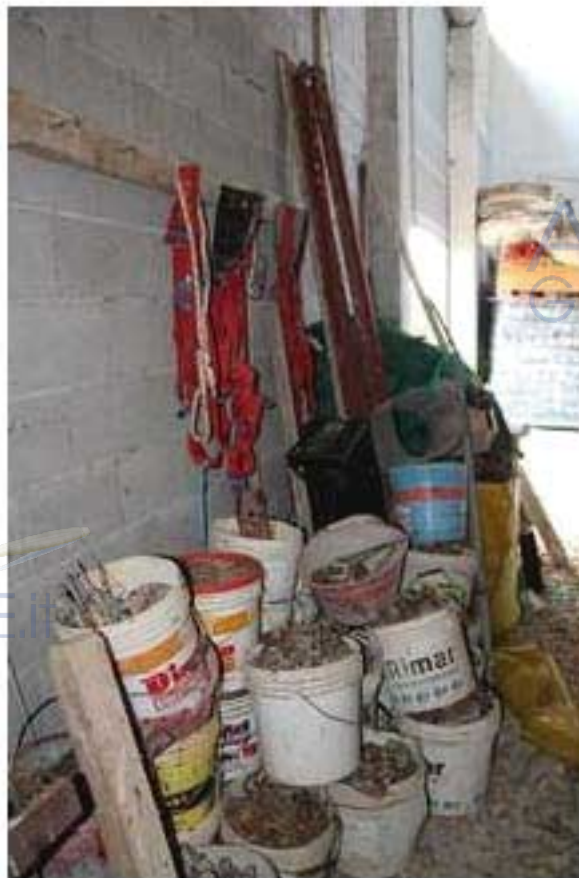
Foto 76 – Accessori per ponteggio ed imbragature per il montaggio.
