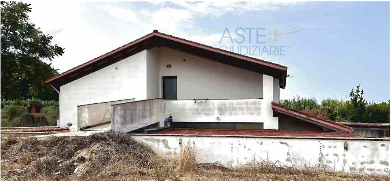
Prospetto nord-est e rampa accesso dal terrapieno
