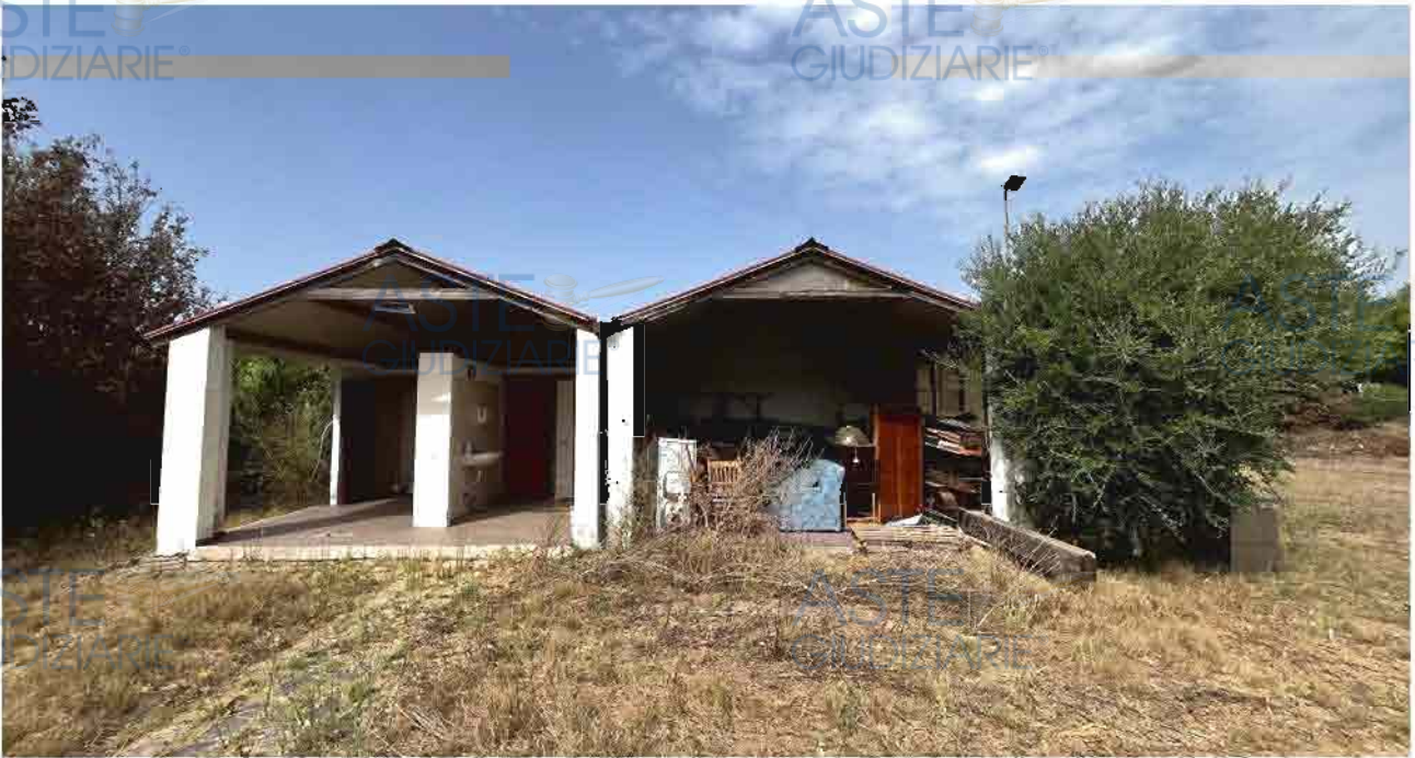
Prospetto principale tettoia e bagni
