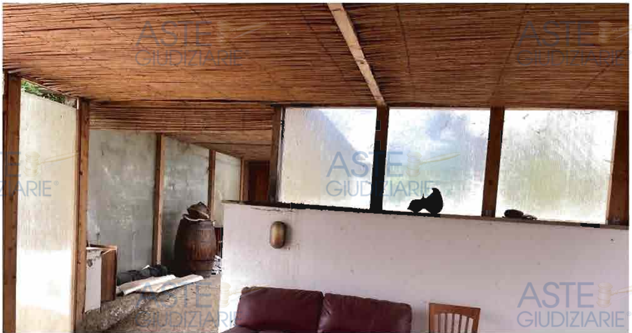
Copertura con canniccio dalla veranda al barbecue
