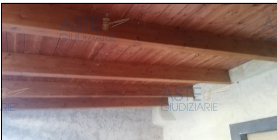
Foto 14 – Particolare copertura veranda
