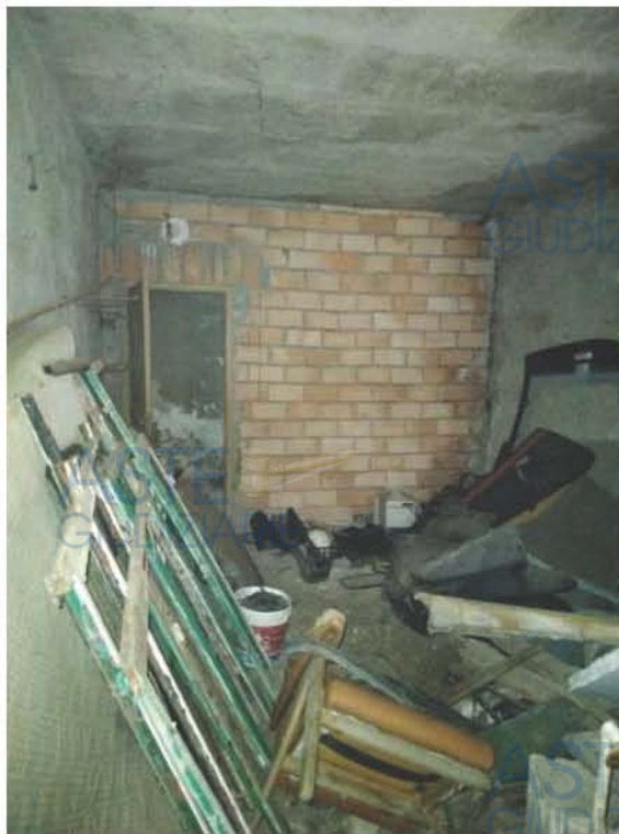
INGRESSO PIANO TERRA
