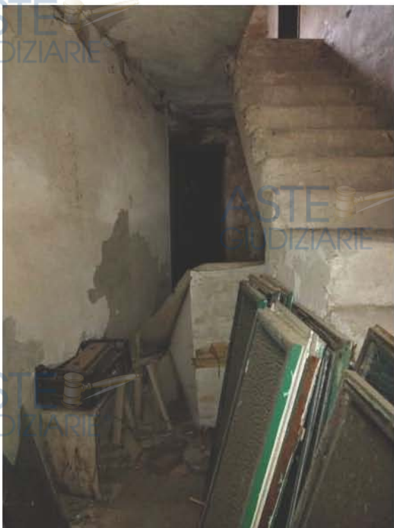
VANO SCALA PIANO TERRA
