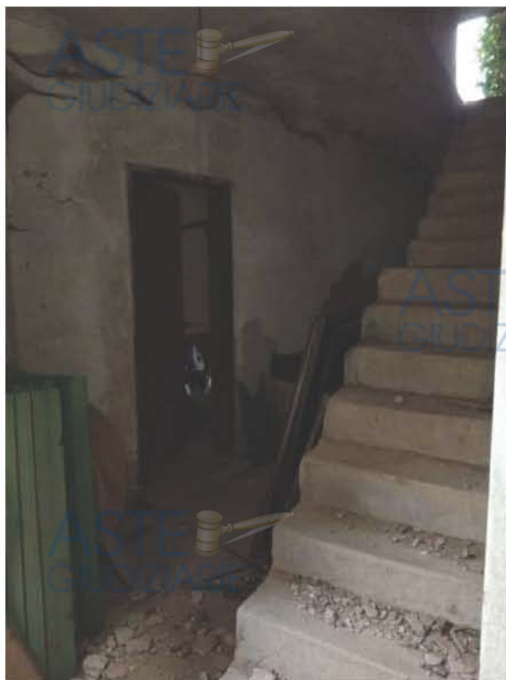
VANO SCALA PIANO TERRA
