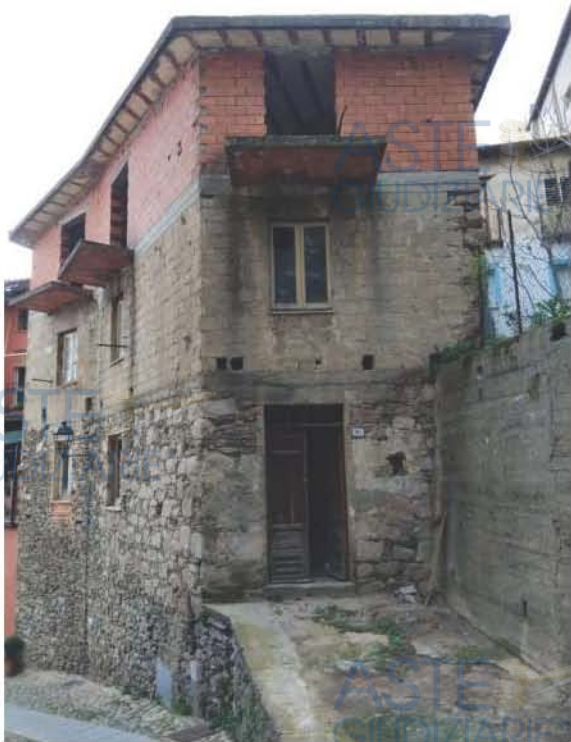
RIPRESA DA VIA MARCONI - ingresso
