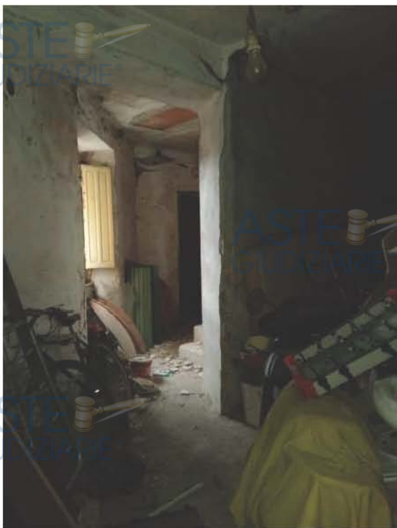
INGRESSO, RIPRESA SUL VANO SCALA
