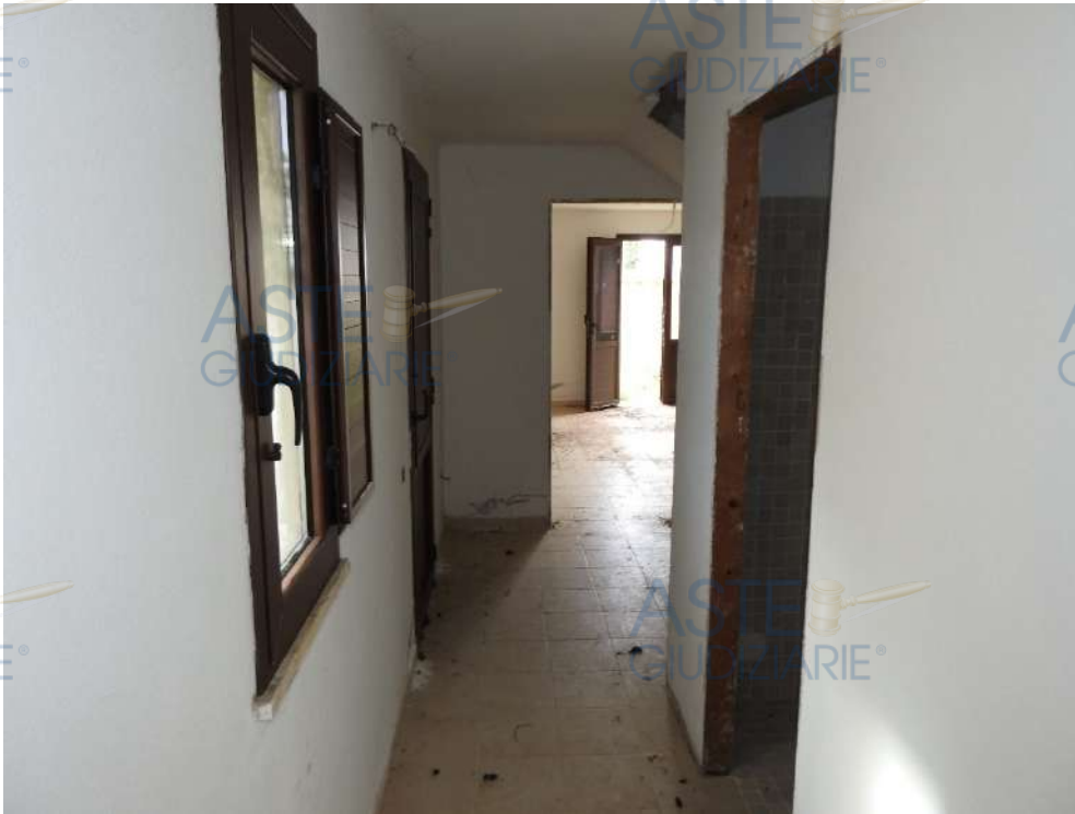
Figura 28 - Piano seminterrato, disimpegno
