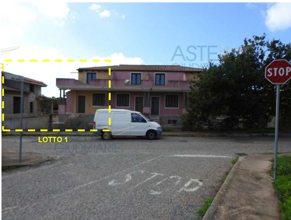
Figura 19 - Visuale complessiva del fabbricato da via dei Mirti
