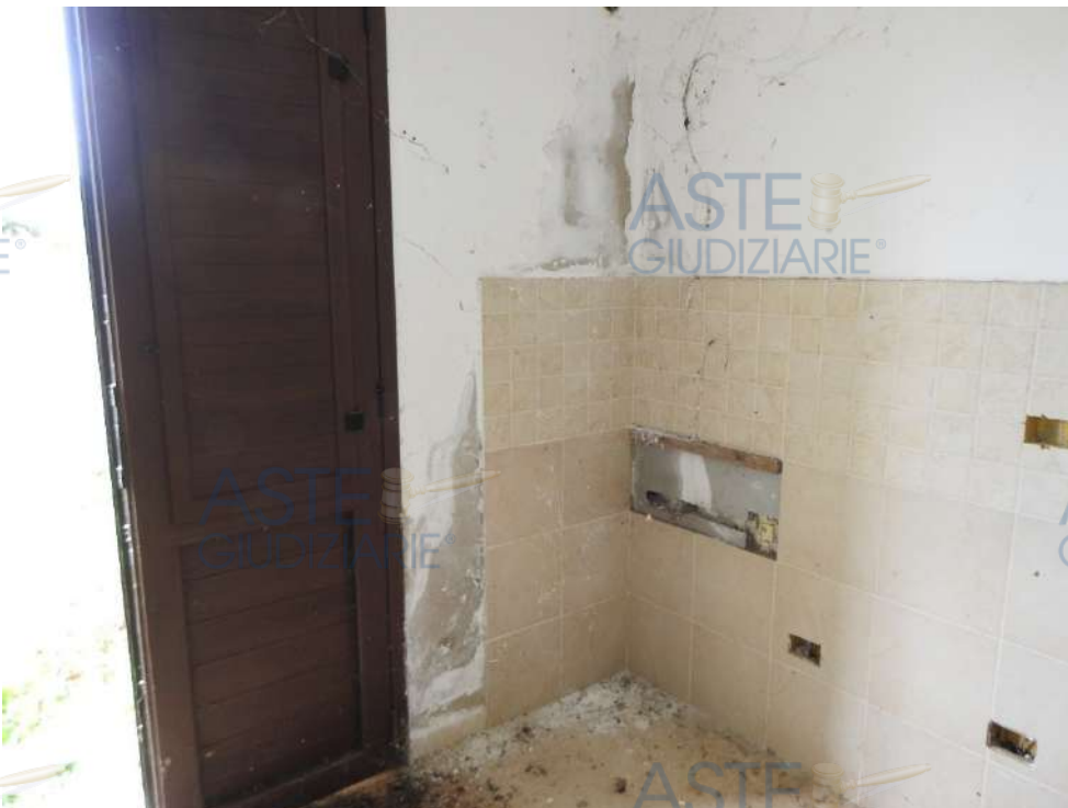
Figura 53 - Patologie edilizie, umidità per capillarità al piano seminterrato e impianti non ultimati
