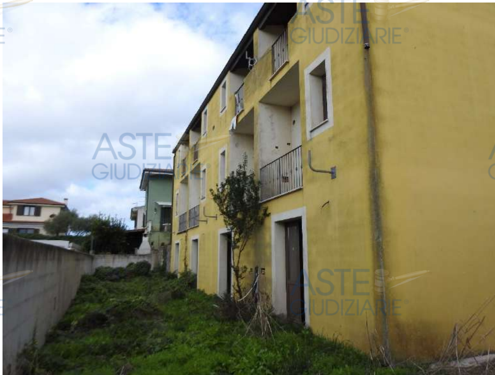
Figura 22 - Visuale complessiva del fabbricato dalle aree di pertinenza. Prospetto retro
