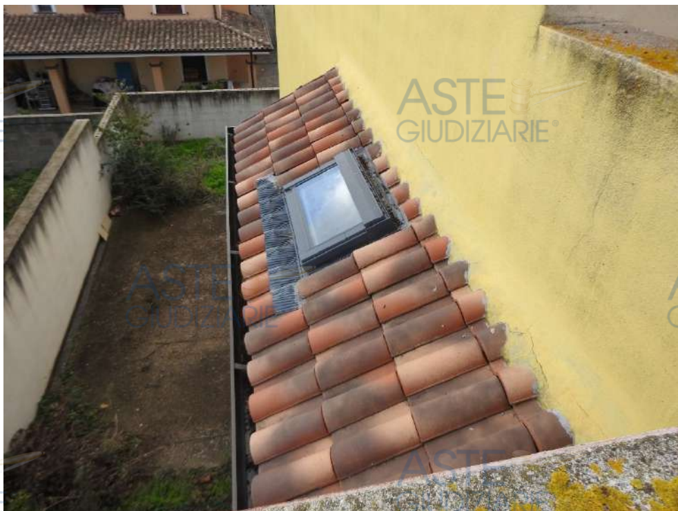
Figura 51 - Visuale del lucernario e della porzione laterale del cortile di proprietà esclusiva del Lotto
