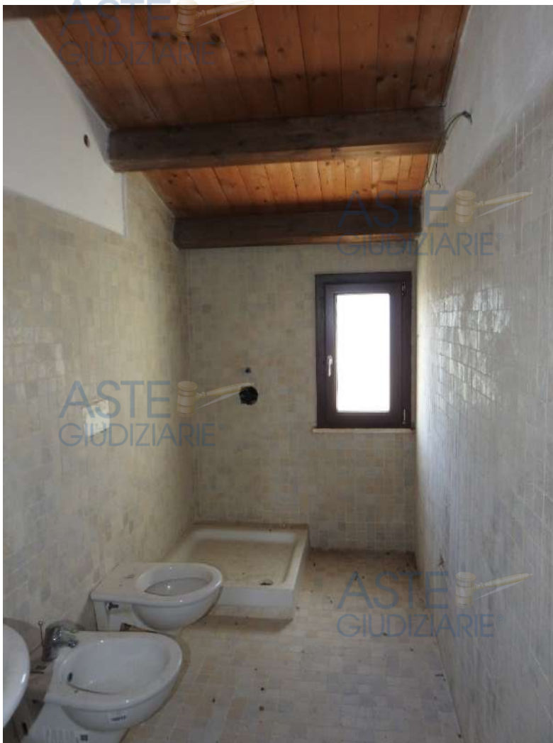
Figura 47 - Piano primo, bagno
