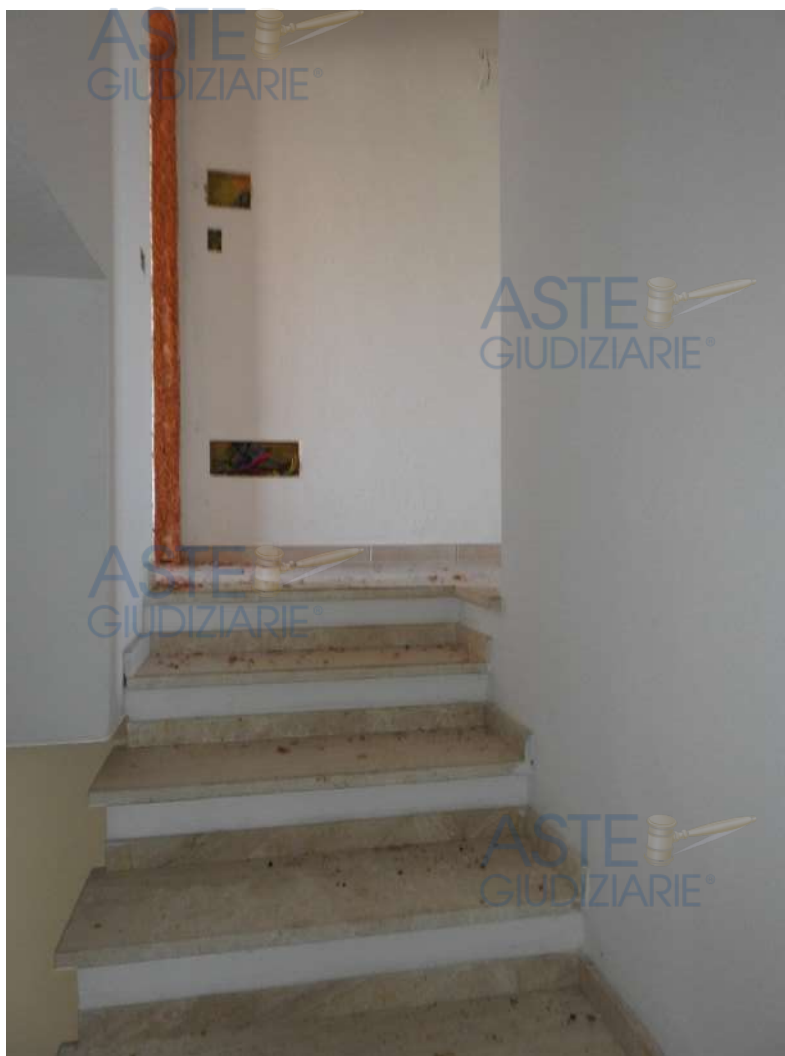
Figura 53 - Scatola di derivazione impianto elettrico, collegamenti mancanti
