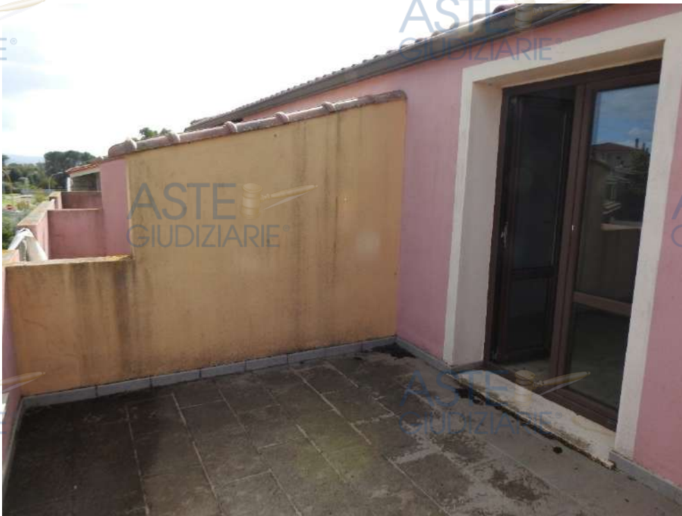
Figura 46 - Piano primo, terrazza camera matrimoniale
