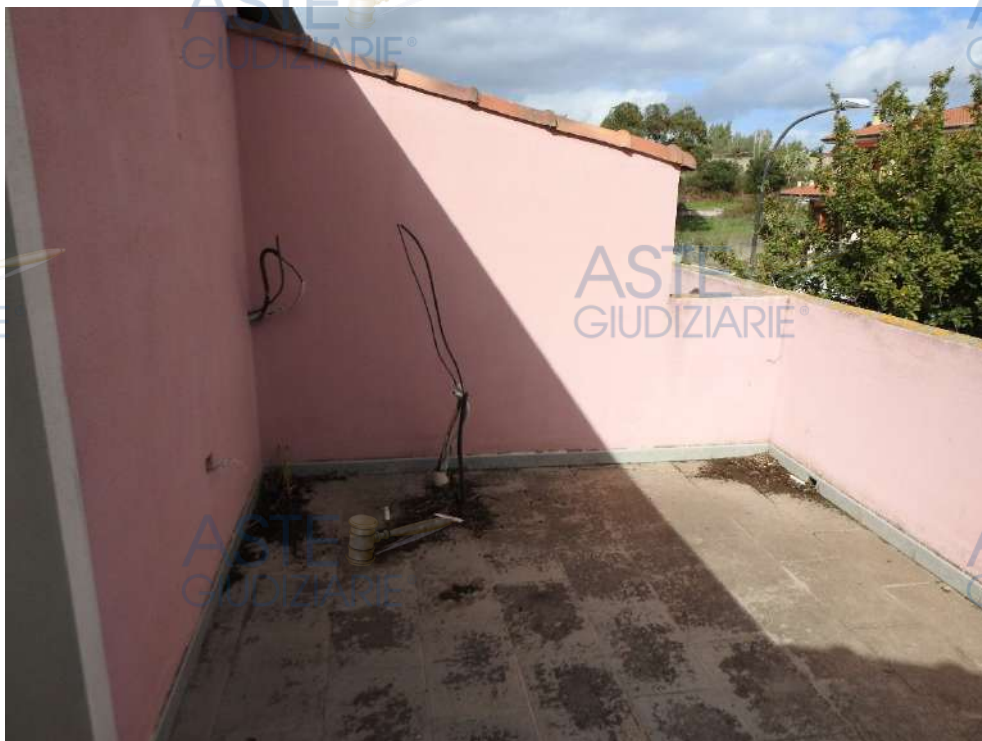
Figura 45 - Piano primo, terrazza camera matrimoniale
