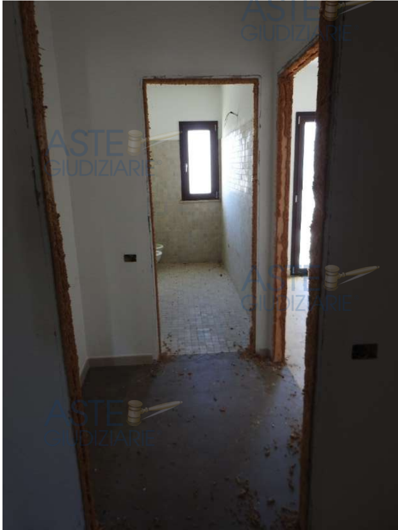
Figura 35 - Piano Terra, disimpegno bagno/cucina
