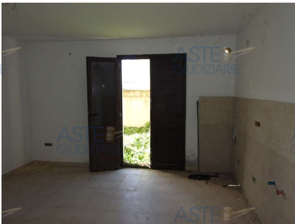
Figura 25 - Piano seminterrato, sgombero
