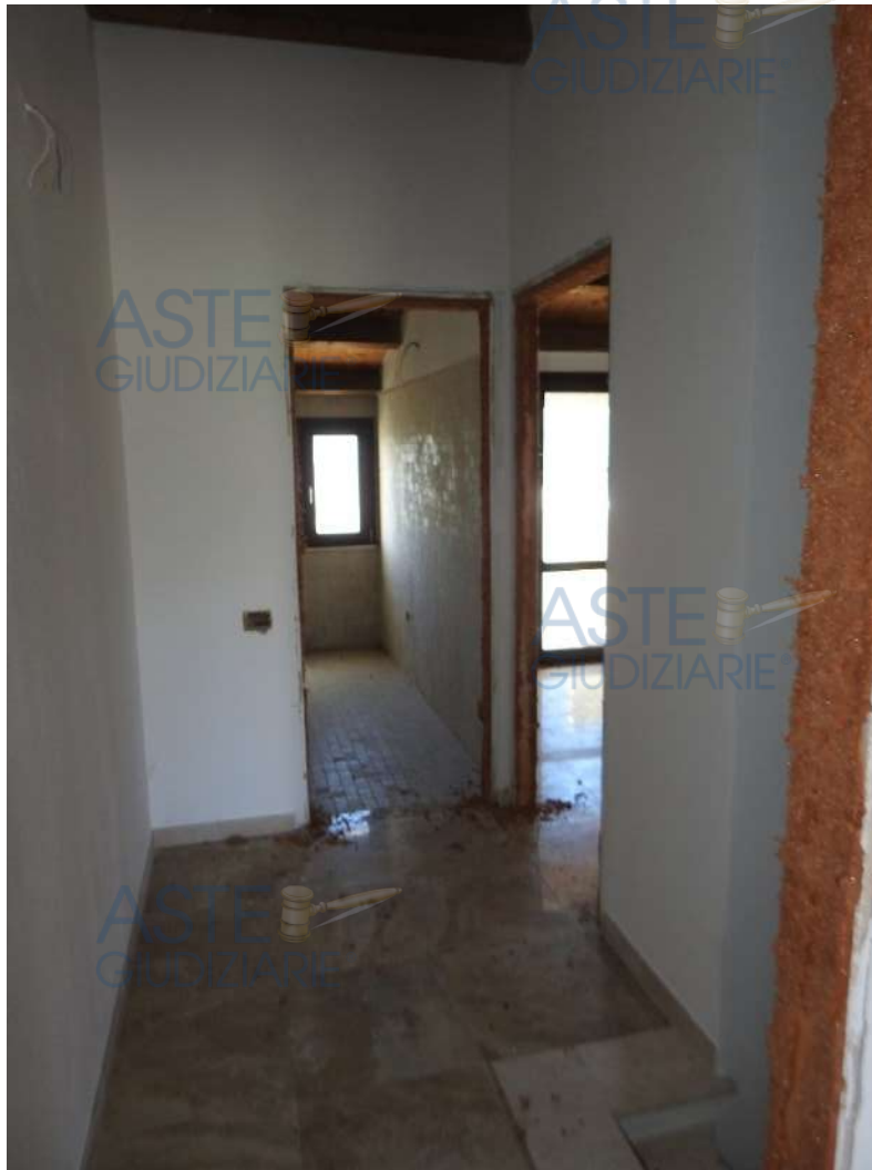
Figura 42 - Piano primo, disimpegno
