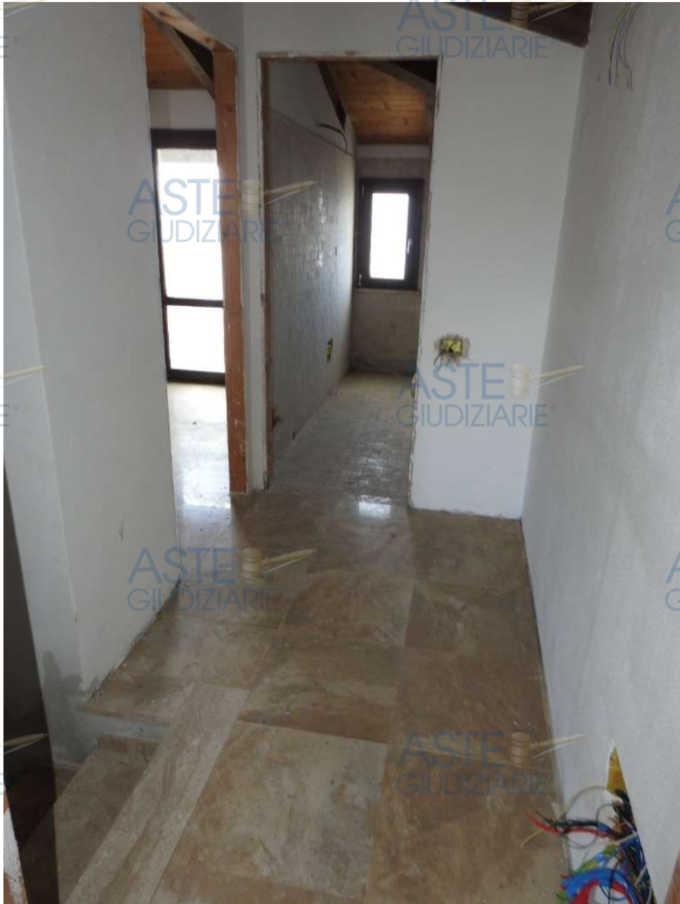
Figura 42 - Piano primo, disimpegno
