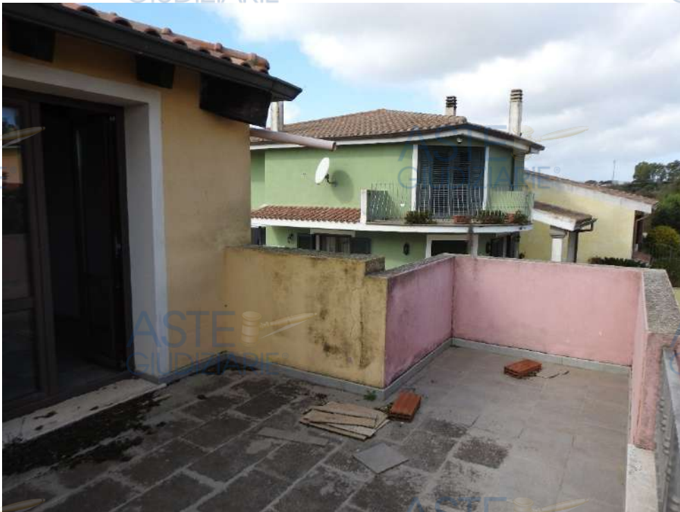
Figura 46 - Piano primo, terrazza camera matrimoniale
