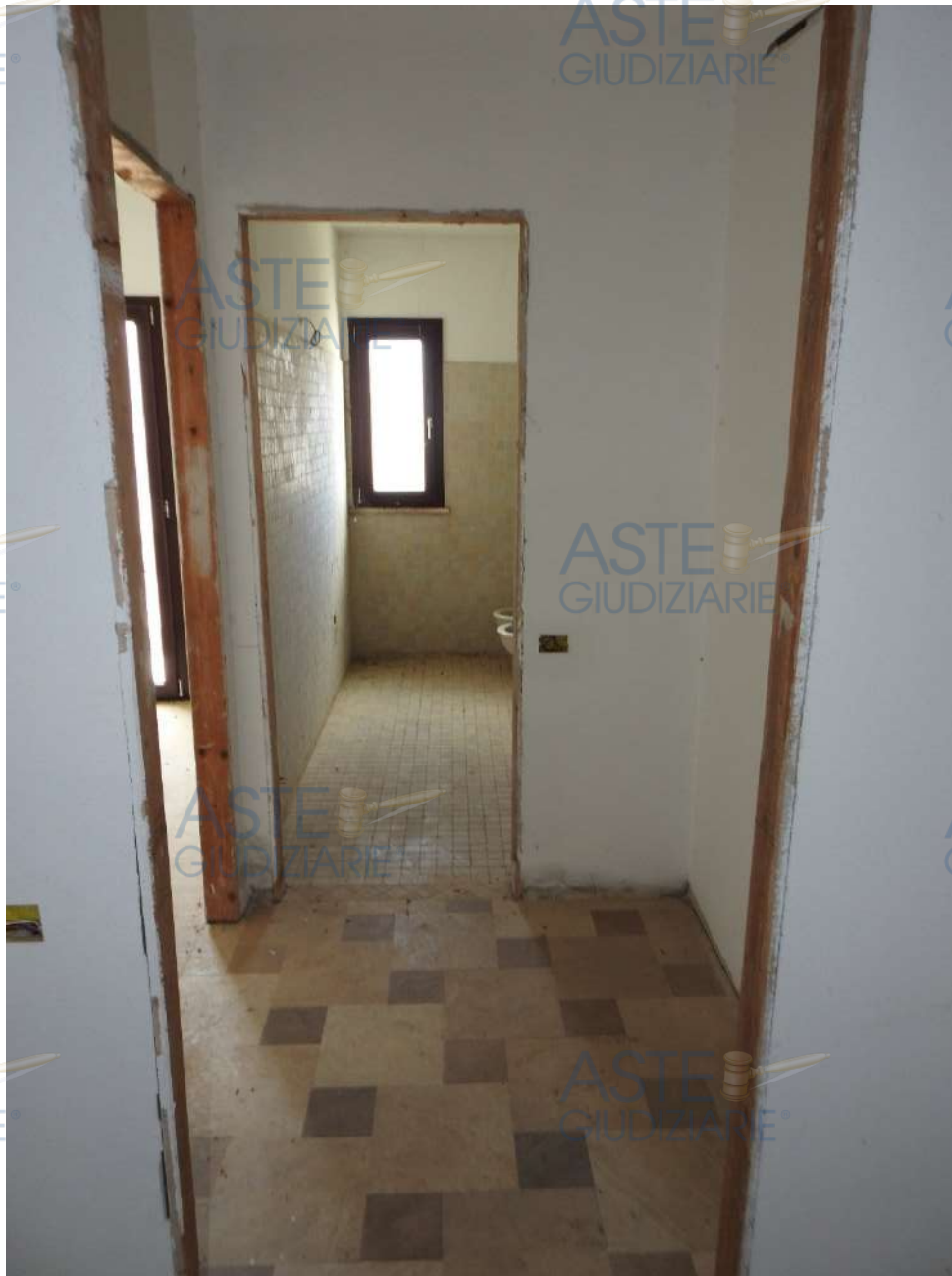
Figura 35 - Piano Terra, disimpegno bagno/cucina
