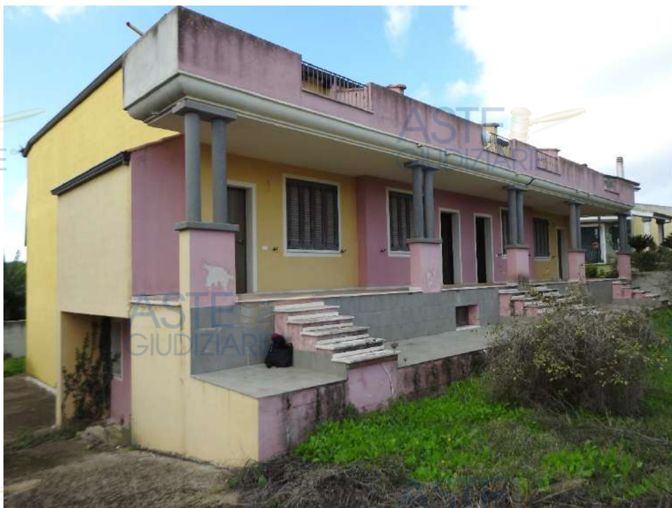
Figura 21 - Visuale complessiva del fabbricato dalle aree di pertinenza. Prospetto principale e laterale sudest
