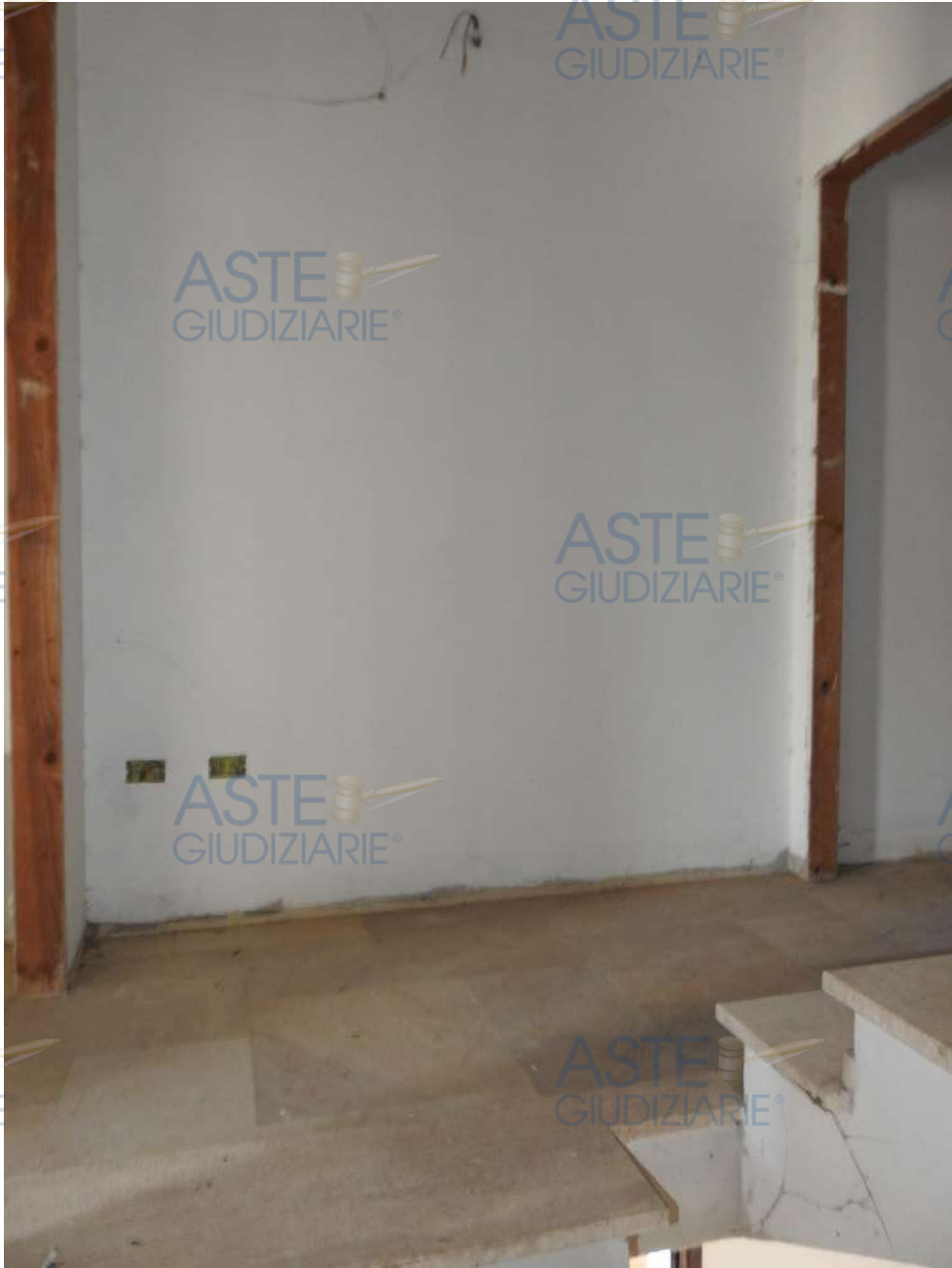
Figura 34 - Piano Terra, disimpegno vano scala
