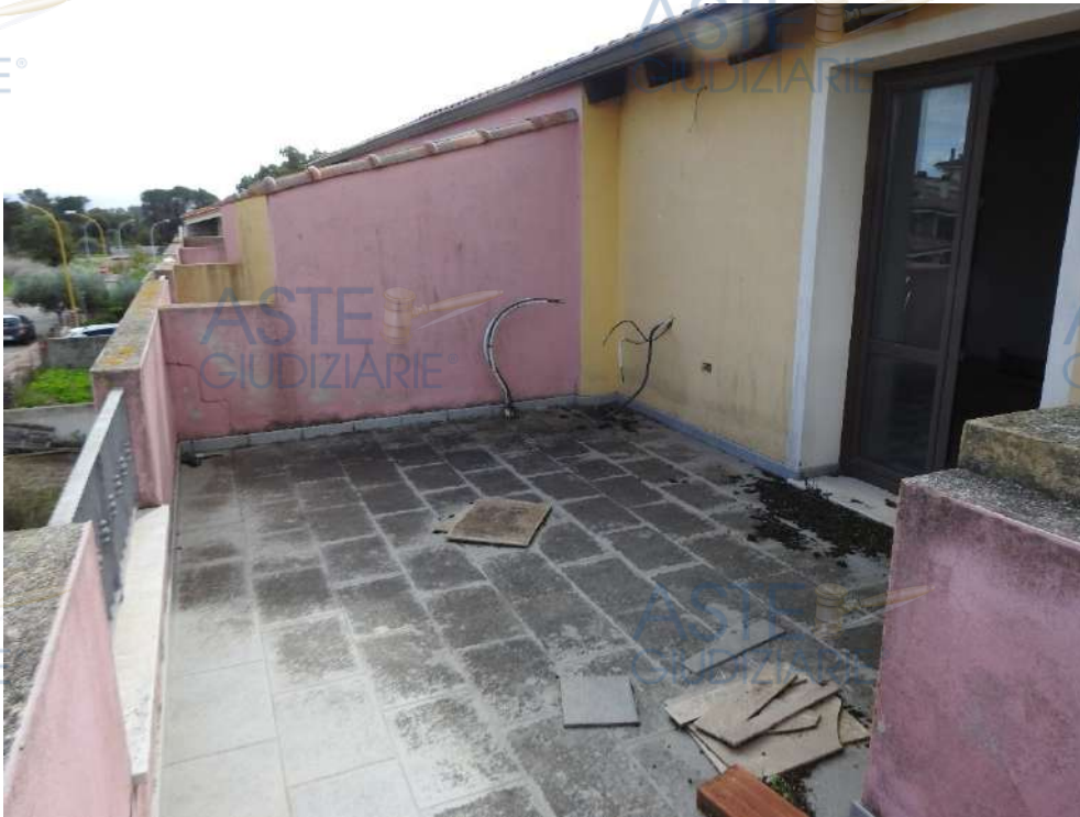
Figura 45 - Piano primo, terrazza camera matrimoniale
