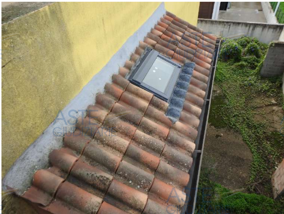
Figura 49 - Visuale del lucernario e della porzione laterale del cortile di proprietà esclusiva del Lotto
