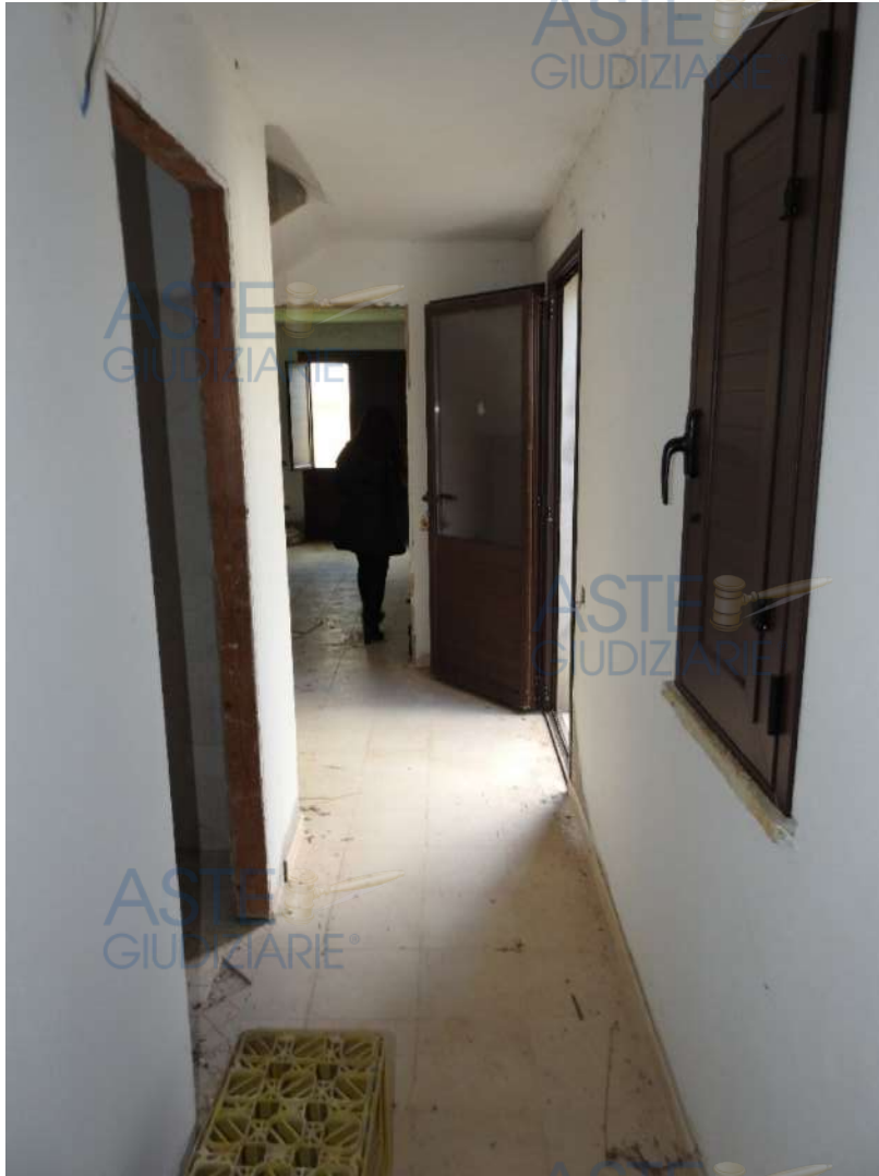
Figura 28 - Piano seminterrato, disimpegno
