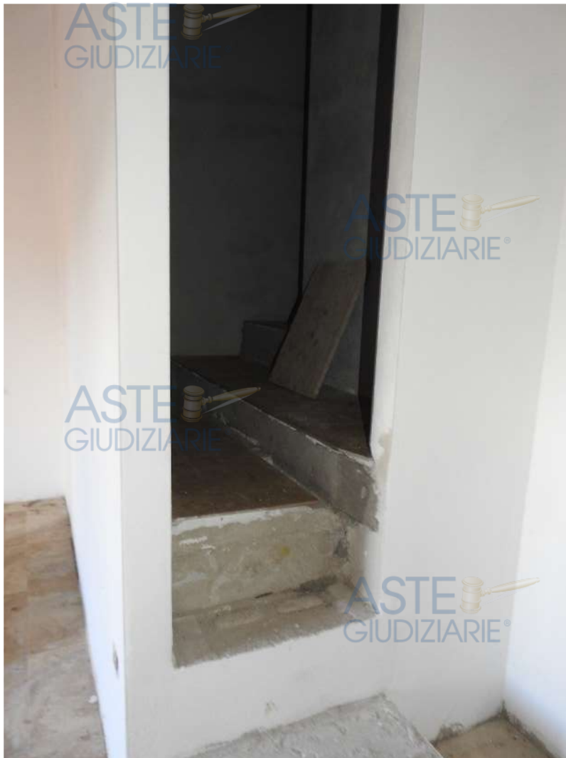
Figura 44 - Piano primo, cabina armadio
