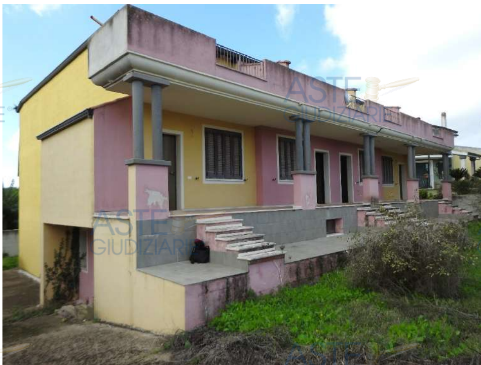
Figura 21 - Visuale complessiva del fabbricato dalle aree di pertinenza. Prospetto principale e laterale sudest
