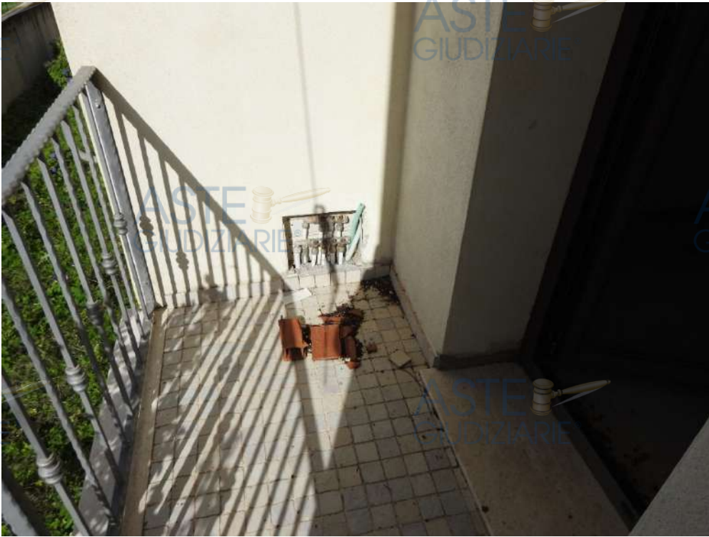
Figura 38 - Piano Terra, balcone cucina
