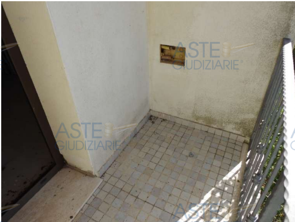
Figura 39 - Piano Terra, balcone cucina
