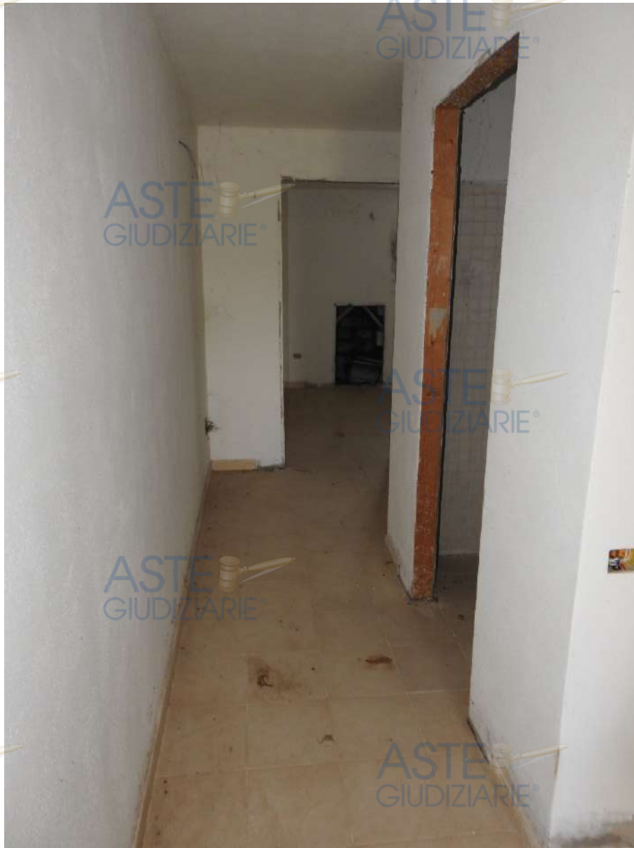
Figura 28 - Piano seminterrato, disimpegno
