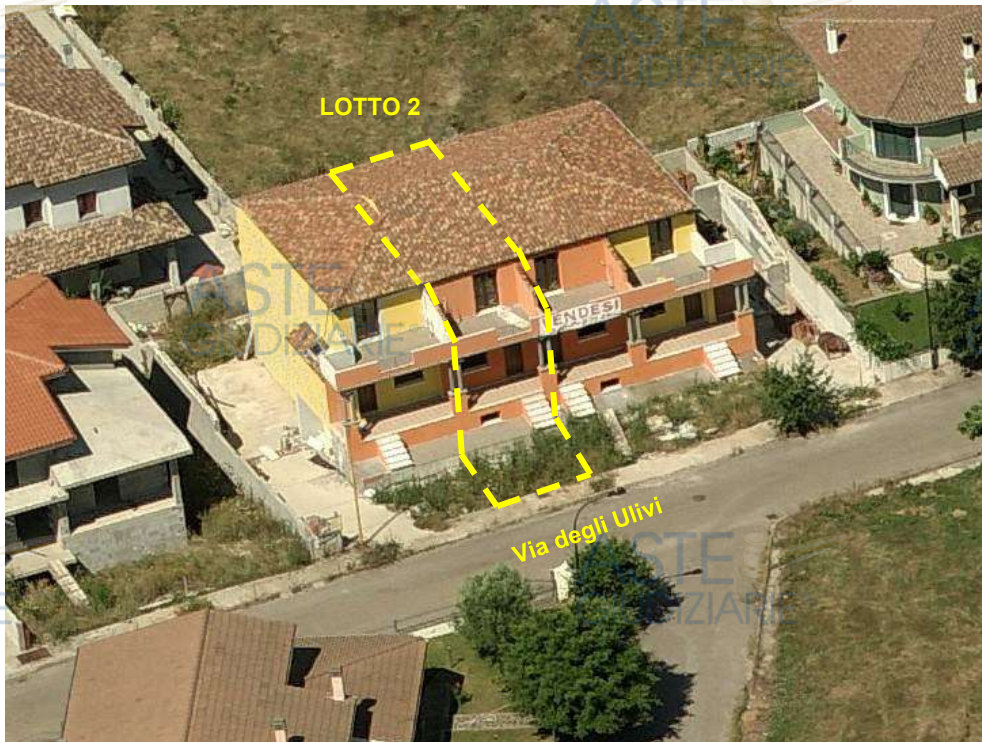
Figura 18 - Visuale complessiva del fabbricato, foto aerea
