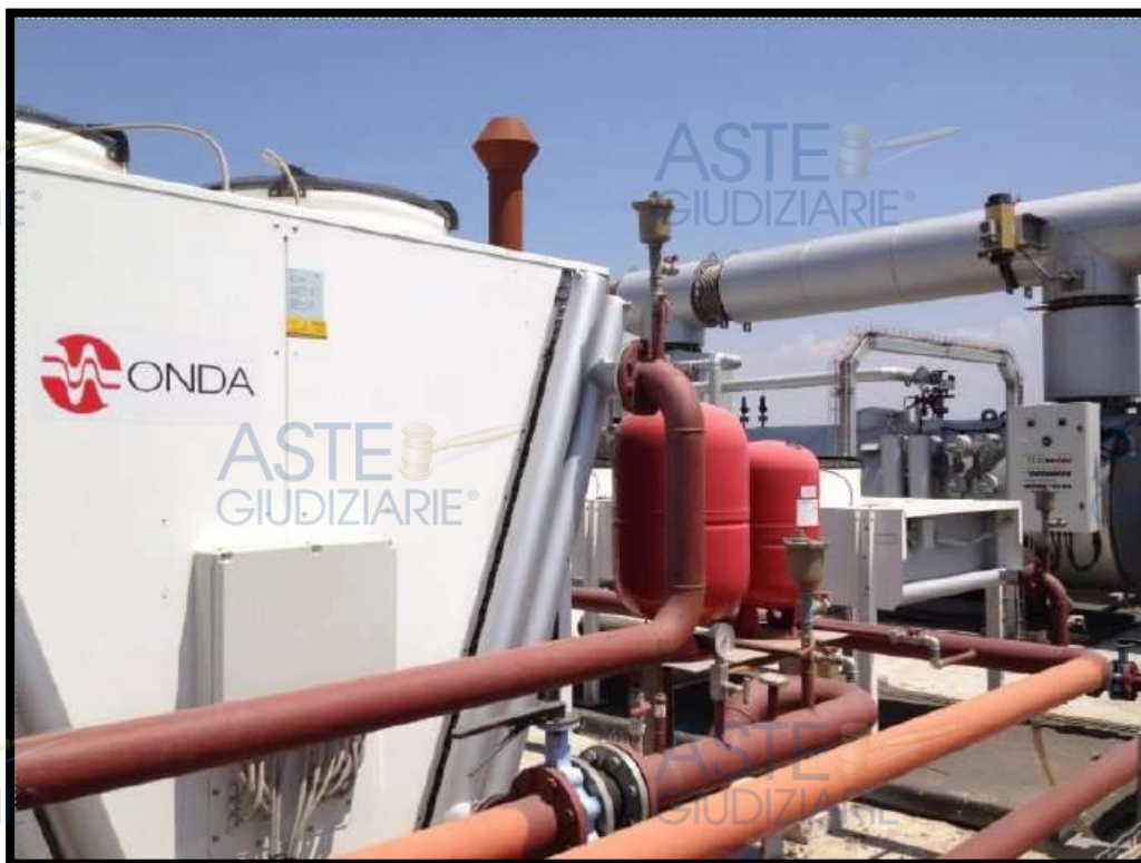
Foto 11 – Elettrodissipatore LT
