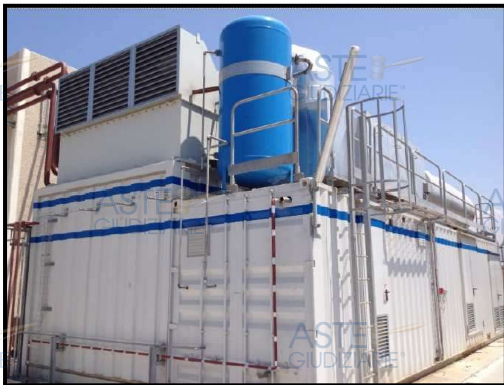
Foto 15 - Scala accesso copertura container cogeneratore
