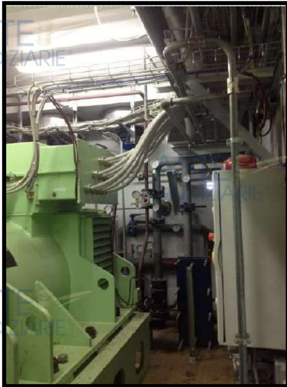
Foto 2 - Particolare motore endotermico
