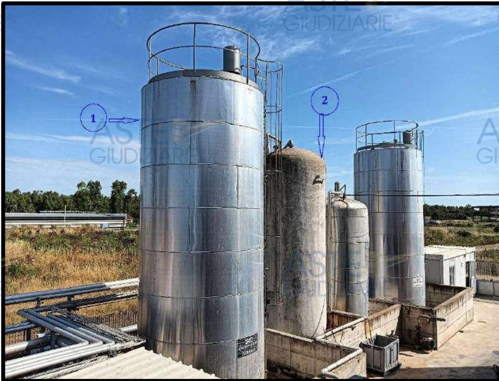
Foto 13 -Silos per biocombustibile ed urea
