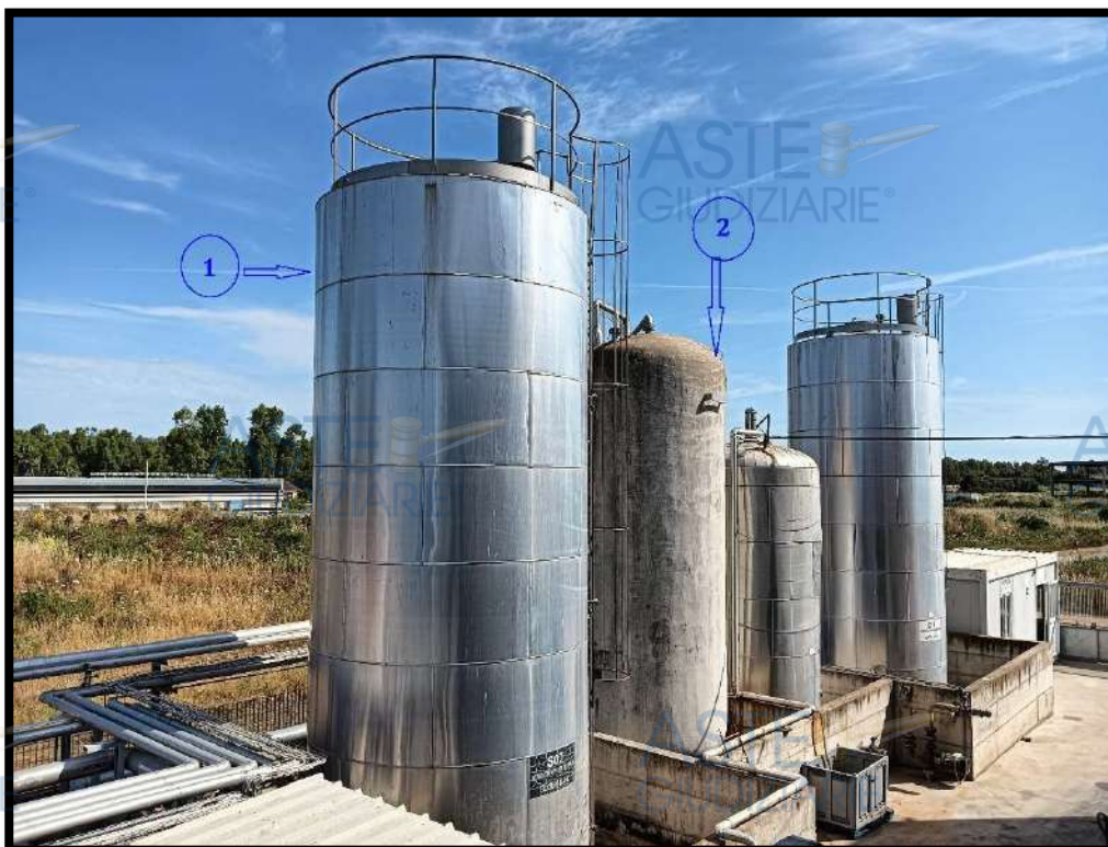
Foto 13 -Silos per biocombustibile ed urea
