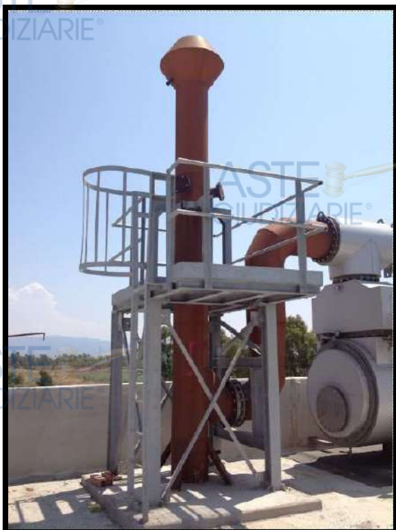
Foto 6 - Recupero termico (espulsione fumi)
