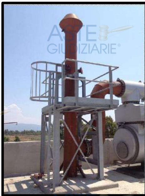
Foto 6 - Recupero termico (espulsione fumi)
