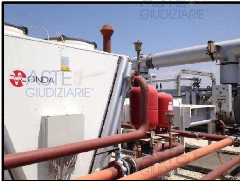
Foto 11 - Elettrodissipatore LT
