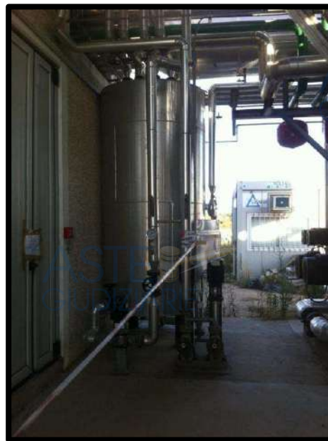
Foto 7 - Recupero termico (sebatoio alimnet. Caldaia)
