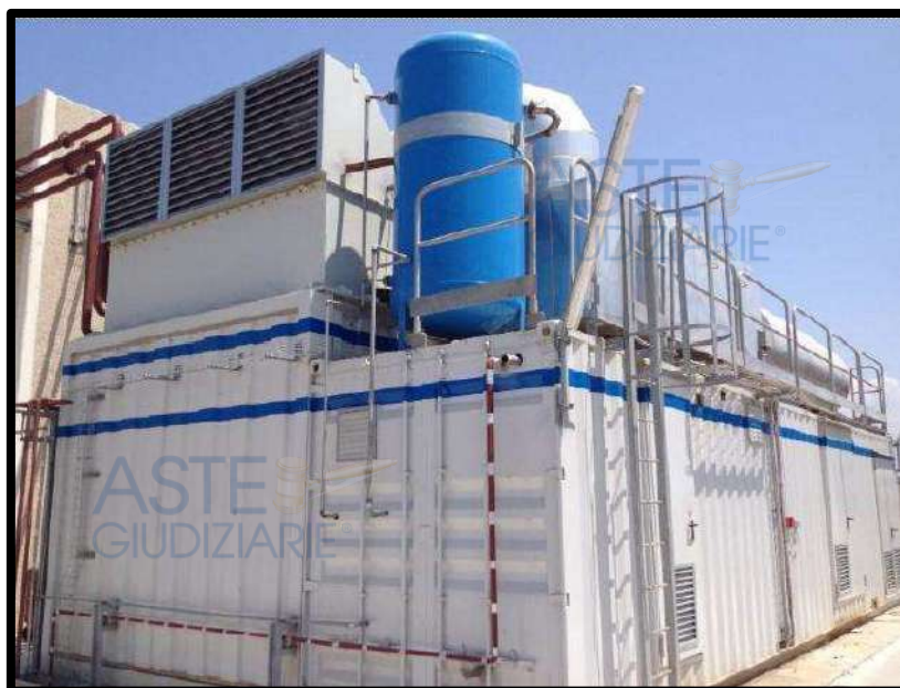
Foto 15 – Scala accesso copertura container cogeneratore
