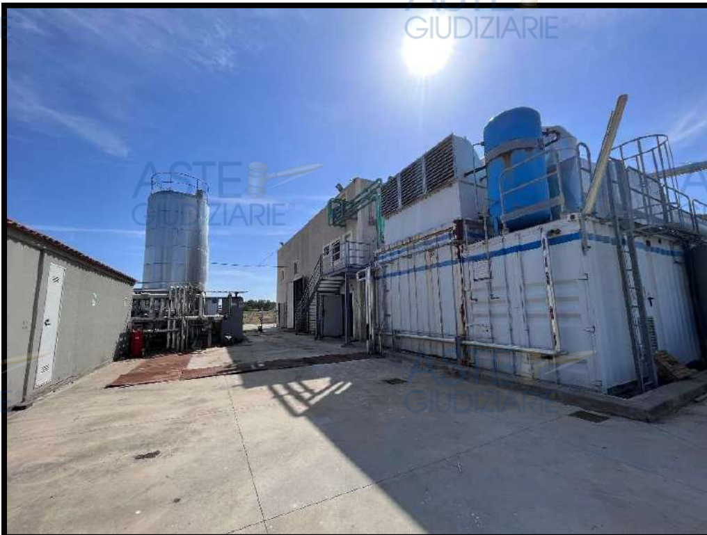
Foto 14 - Container cogeneratore
