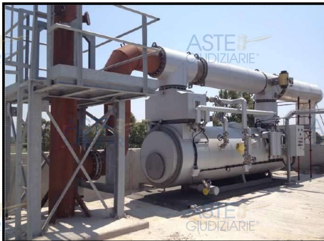
Foto 5 – Caldaia recupero termico
