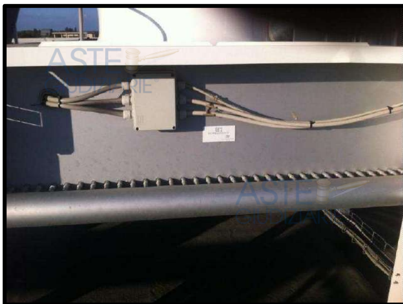
Foto 10 - Elettrodissipatore HT
