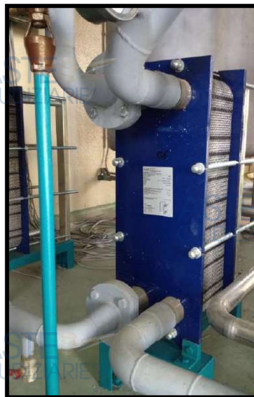
Foto 9 - Scambiatore a piastre recuperato HT
