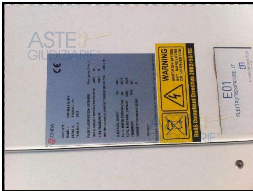
Foto 12 - Targa elettrodissipatore LT
