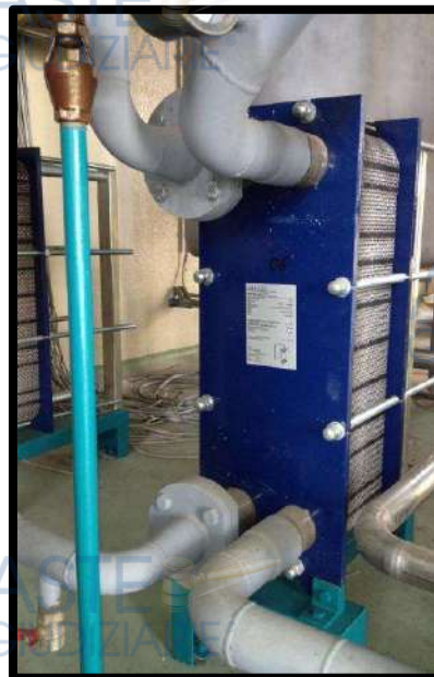
Foto 9 - Scambiatore a piastre recupero HT
