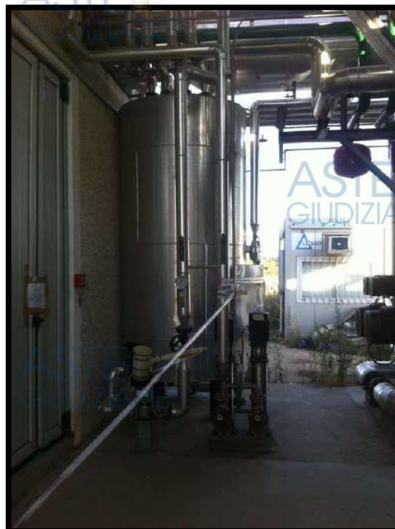
Foto 7 - Recupero termico (sebatoio alimnet. Caldaia)
