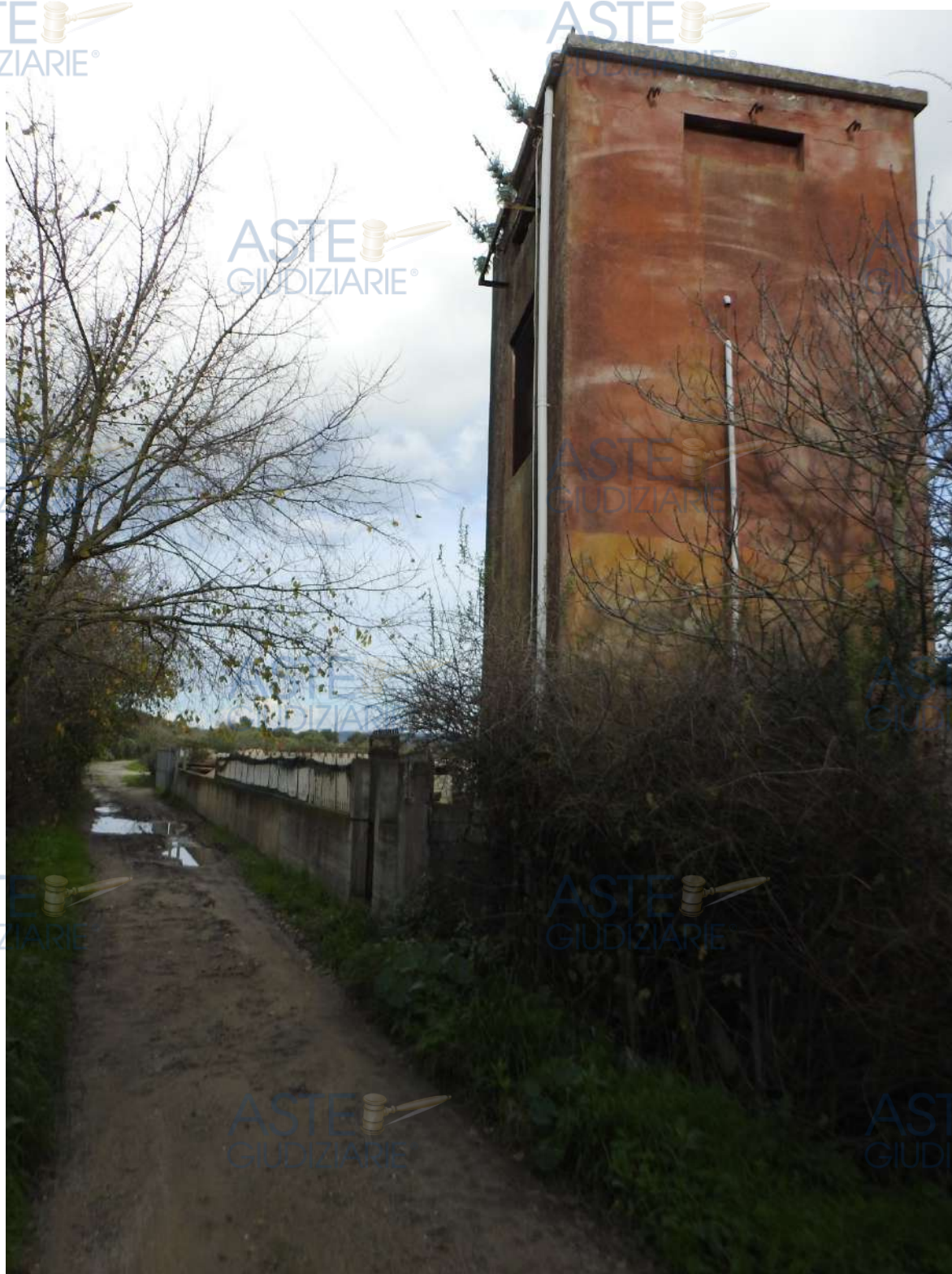
Figura 56 - Immobile 3 (cabina elettrica), visuale dalla strada vecchia. Prospetto sud
