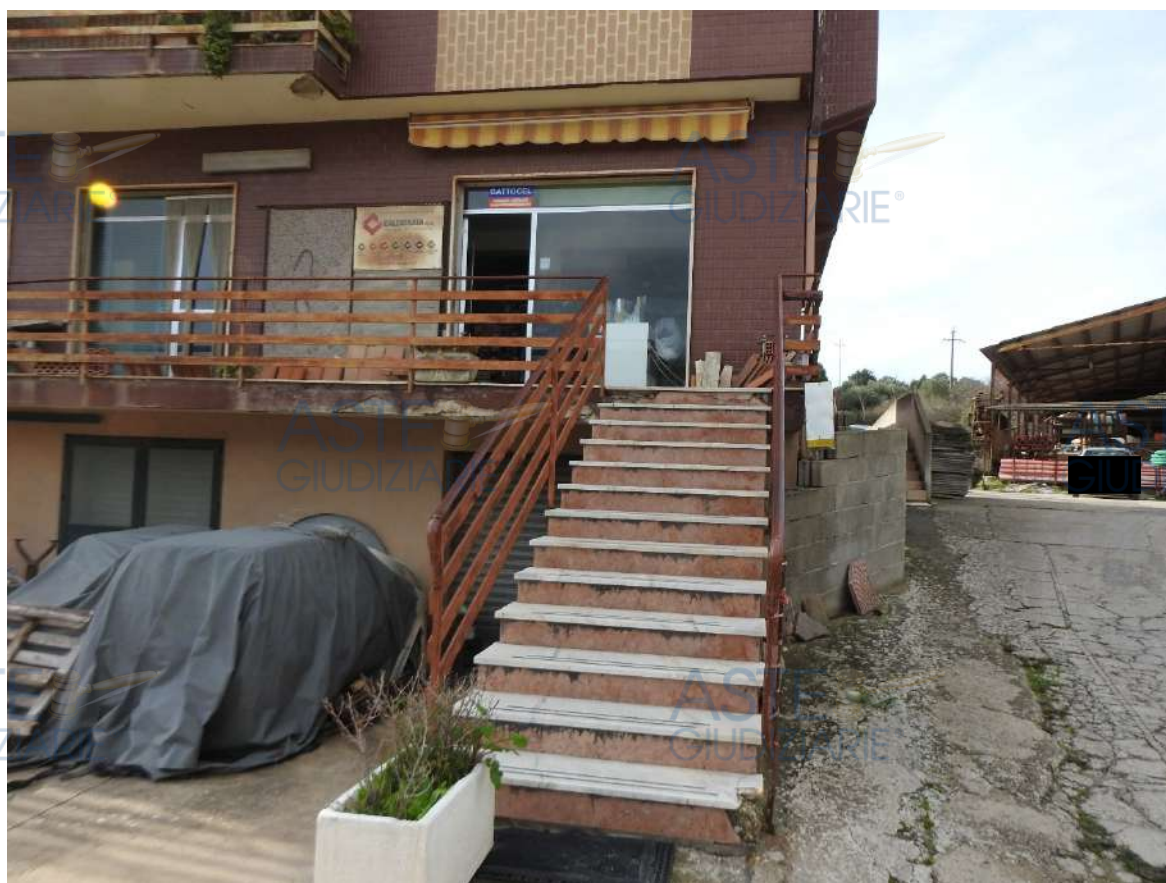
Figura 37 - Immobile 2 (negozio), particolare ingresso
