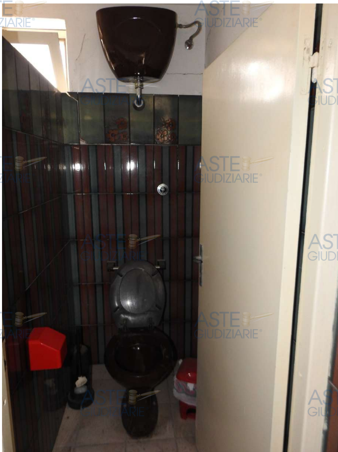
Figura 66 - Immobile 4 (capannone principale), blocco 4A. Servizi igienici - wc.
