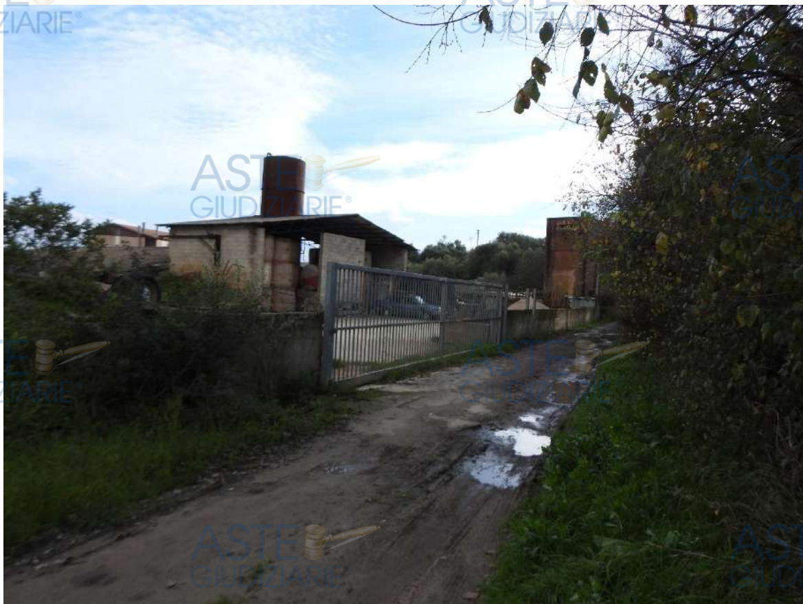
Figura 19 - Visuale dalla strada vecchia da nord verso sud. A sinistra il retro del capannone, in fondo a dx la cab. el.
