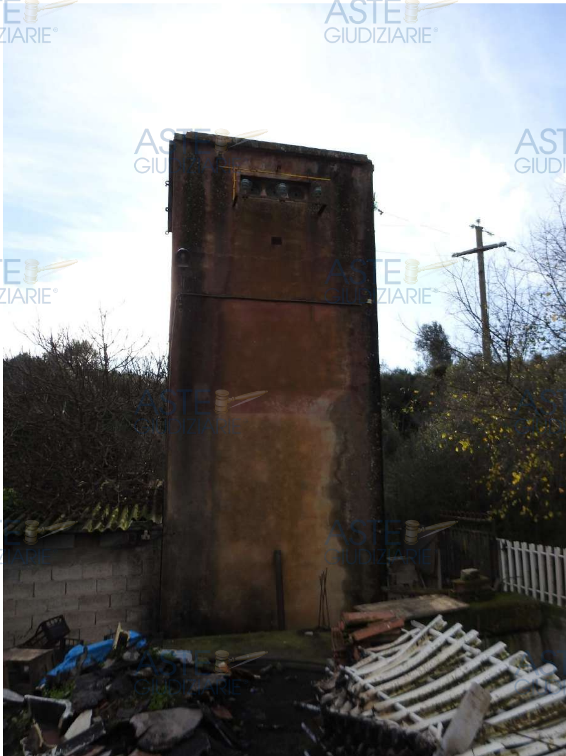
Figura 57 - Immobile 3 (cabina elettrica). Prospetto nord.
