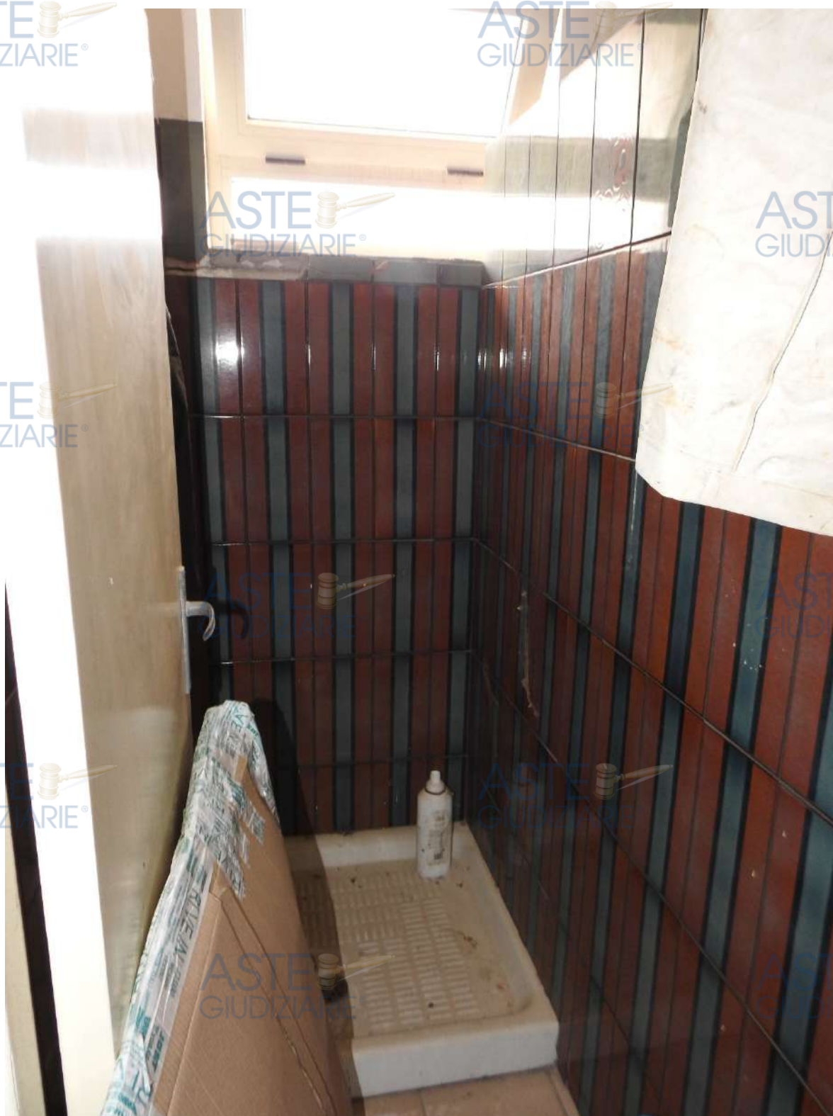
Figura 67 - Immobile 4 (capannone principale), blocco 4A. Servizi igienici – doccia.
