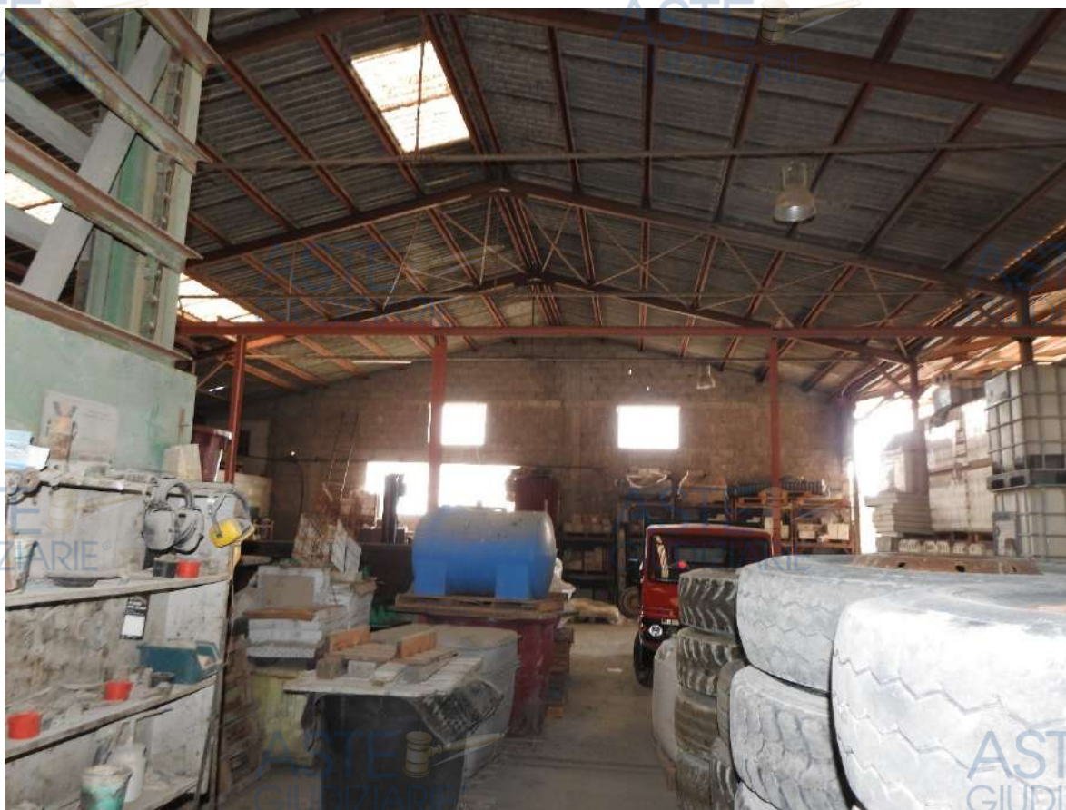
Figura 73 - Immobile 4 (capannone principale), blocco 4A. Visuale dal retro verso l'ingresso.
