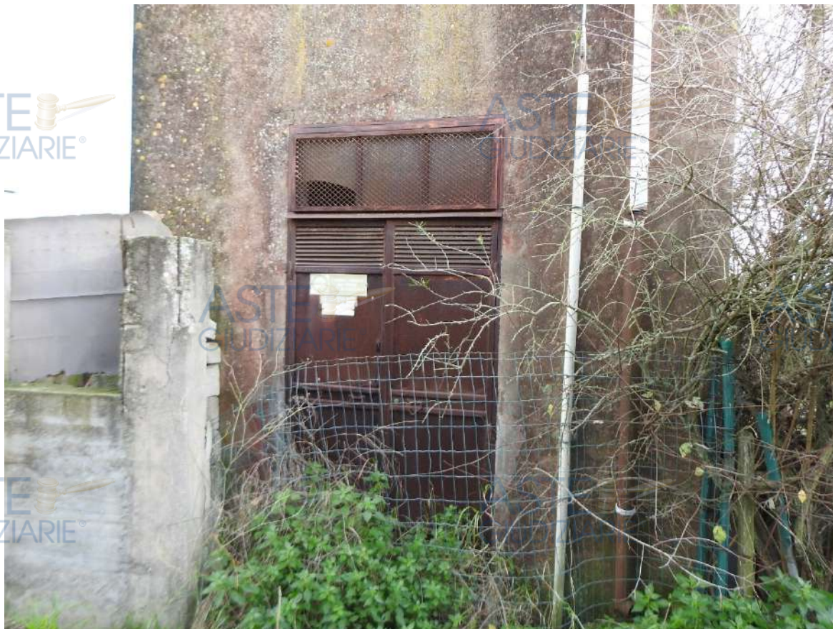
Figura 55 - Immobile 3 (cabina elettrica), ingresso
