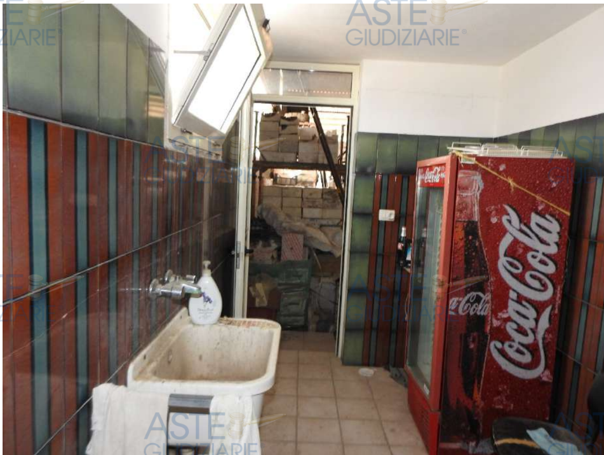
Figura 68 - Immobile 4 (capannone principale), blocco 4A. Servizi igienici, visuale da wc-doccia a ingresso.
