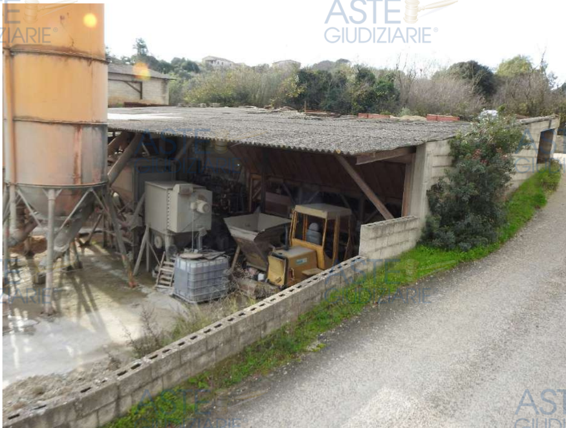
Figura 76 - Immobilità 5 (tettoia operativa). Vista del prospetto principale e della copertura in eternit.
