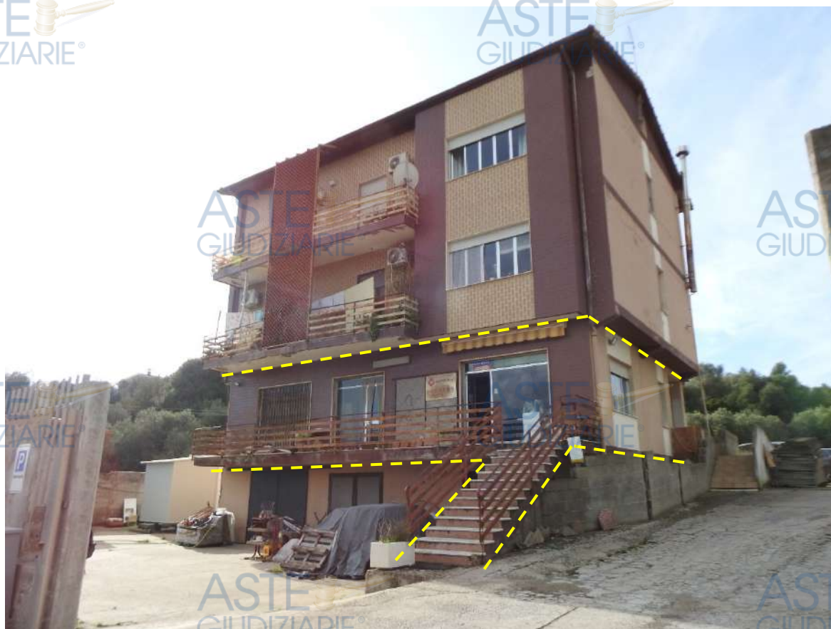
Figura 36 - Immobile 2 (negozio), ingresso principale e affaccio laterale
