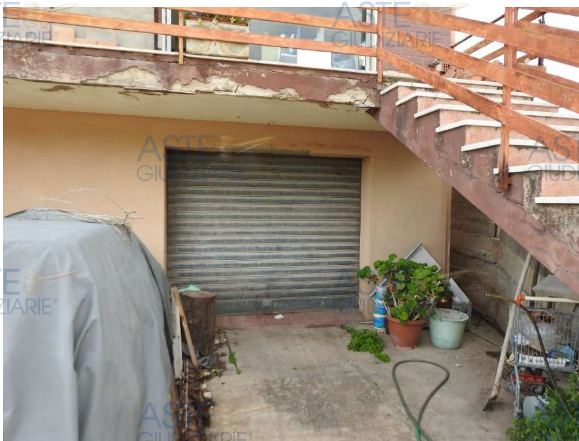
Figura 31 - Immobile 1 (Autorimessa) - Ingresso
