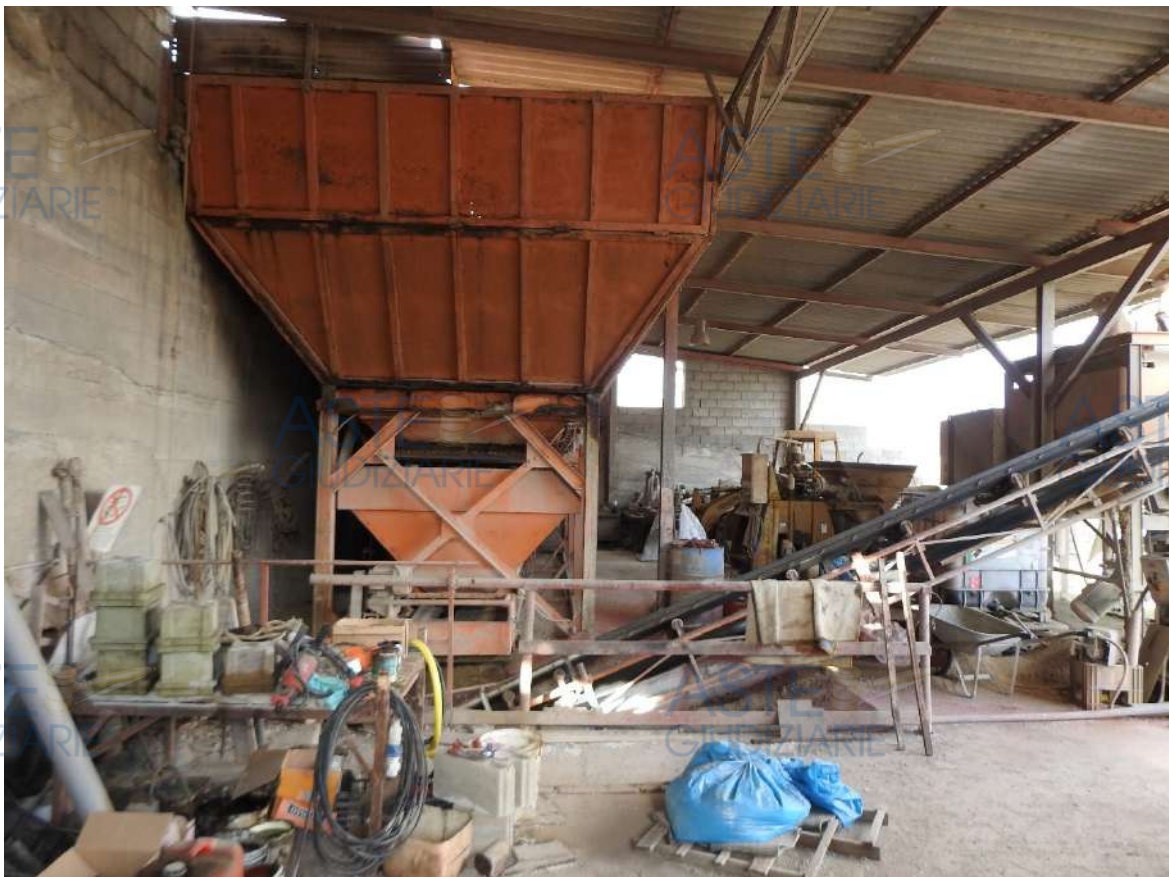
Figura 79 - Immobile 5 (tettoia operativa). Visuale interna.
