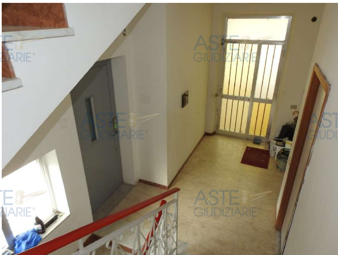
Figura 28 - Androne ingresso palazzina
