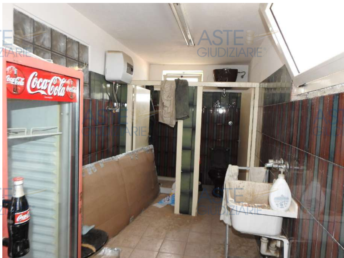
Figura 65 - Immobile 4 (capannone principale), blocco 4A. Servizi igienici, visuale da ingresso a wc-doccia.
