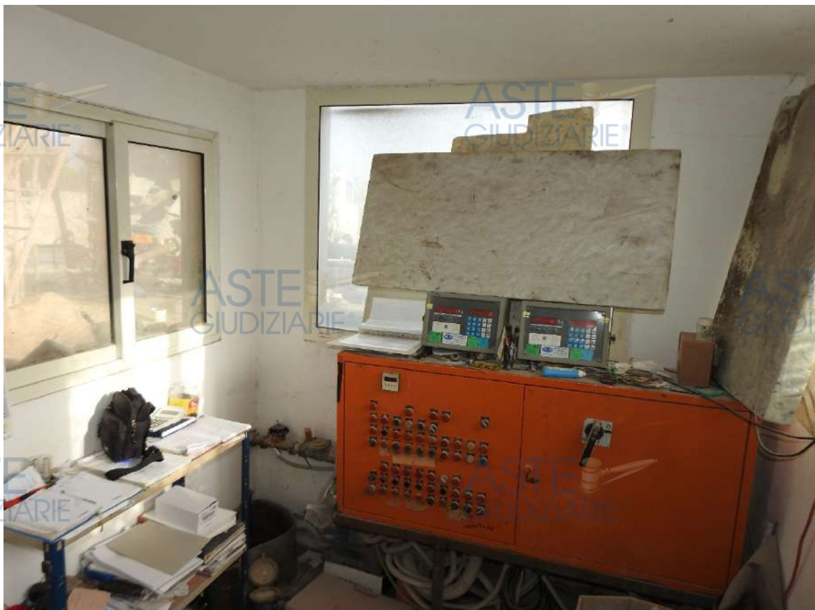
Figura 81 - Immobile 5 (tettoia operativa). Interno ufficio.
