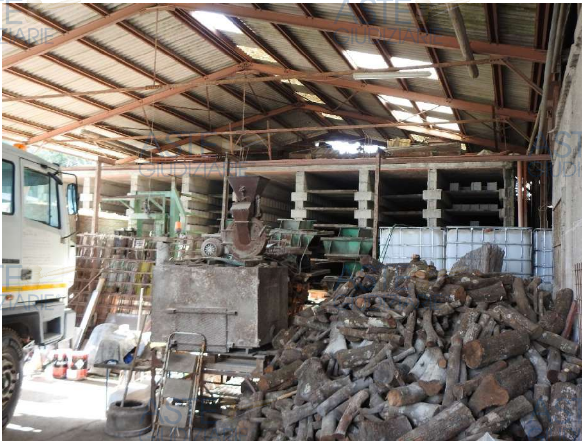
Figura 60 - Immobile 4 (capannone principale), blocco 4B. Impianto di essicazione.
