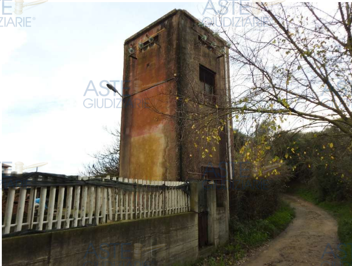
Figura 54 - Immobile 3 (cabina elettrica), visuale dalla strada vecchia, visuale dalla strada vecchia. Prospetti nord e sud
