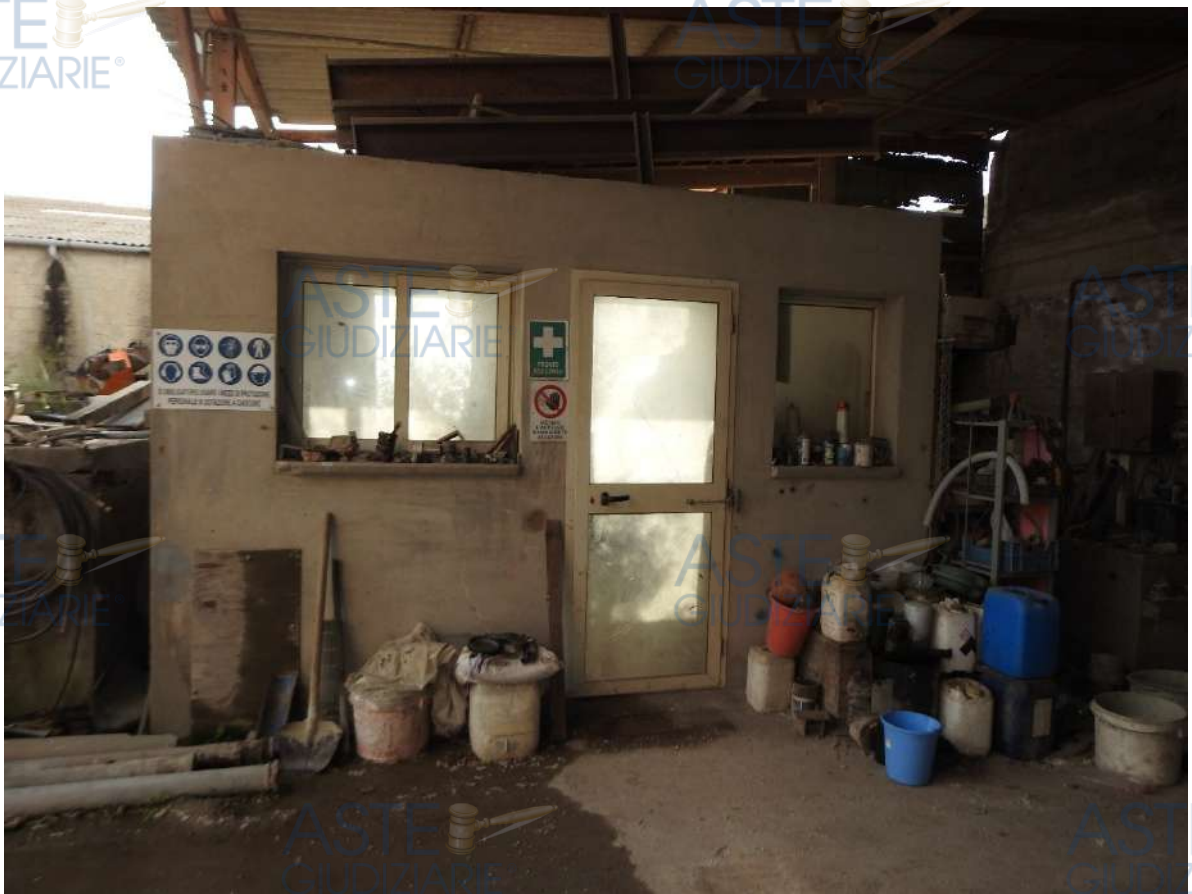
Figura 80 - Immobile 5 (tettoia operativa). Ufficio.
