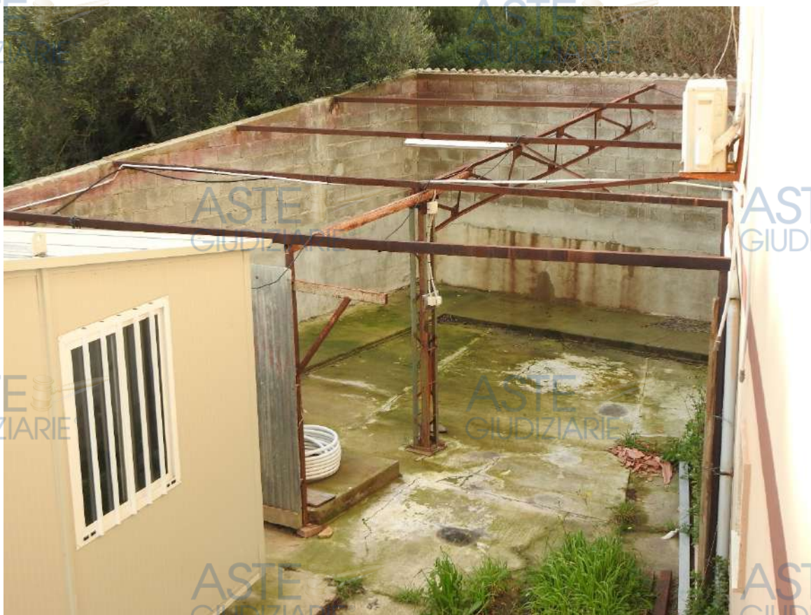
Figura 89 - Mappale 412 e relative installazioni. Particolare della struttura metallica del deposito.
