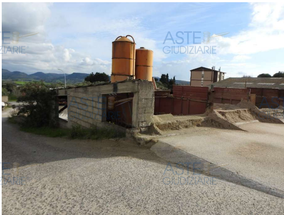
Figura 77 - Immobilità 5 (tettoia operativa). Vista laterale/retro.
