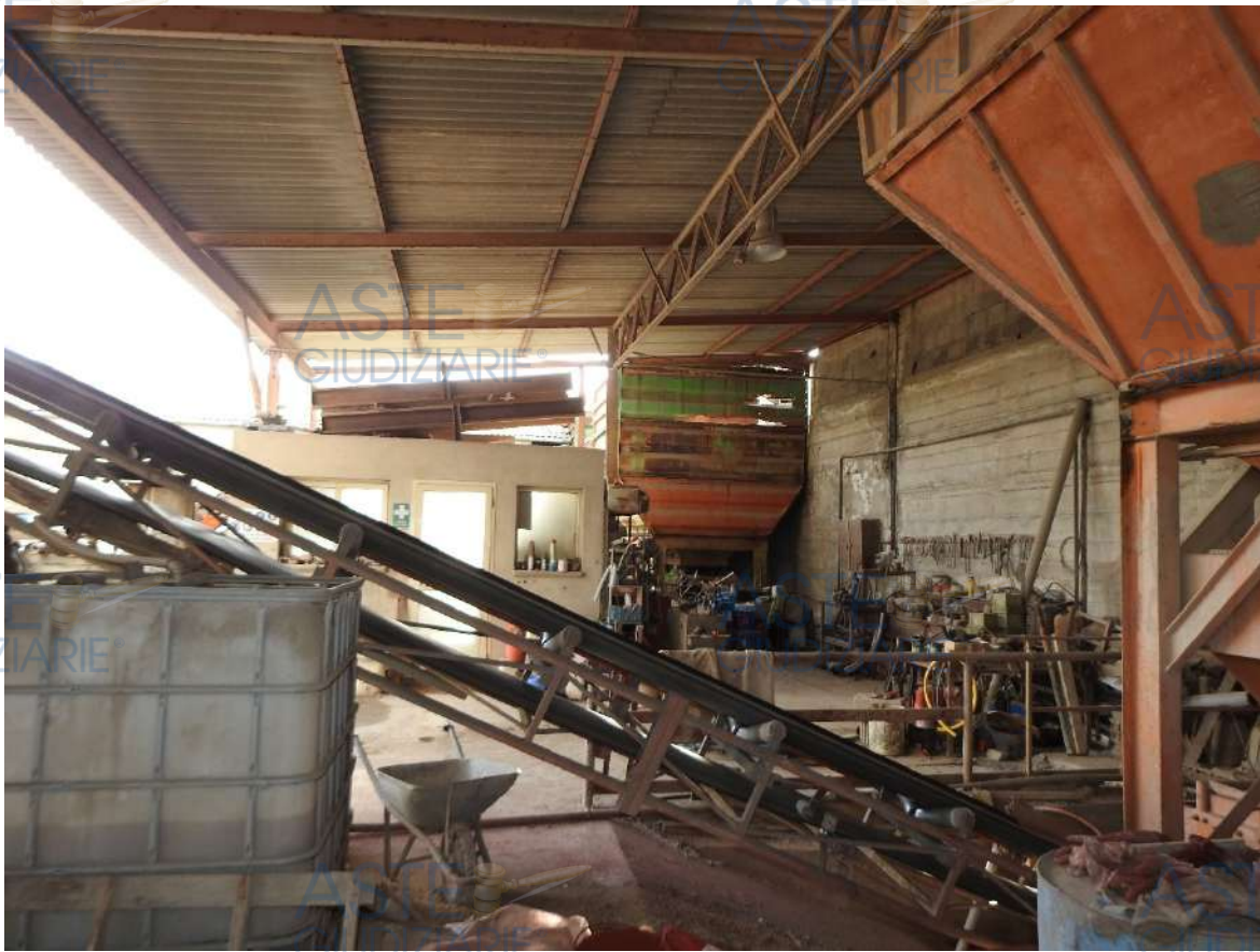
Figura 78 - Immobile 5 (tettoia operativa). Visuale interna.
