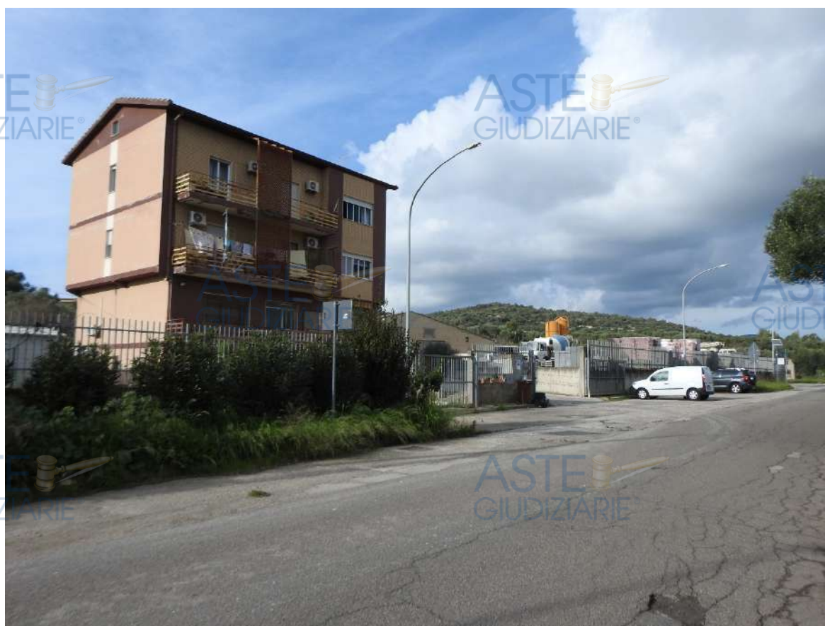
Figura 16 - Visuale da SP44 verso il civico 349, da sud verso nord. A sinistra la palazzina.
