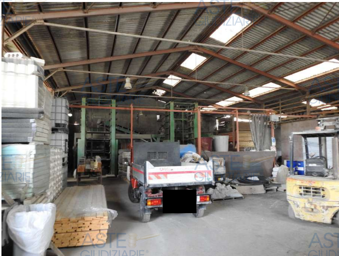
Figura 62 - Immobile 4 (capannone principale), blocco 4A. Visuale dall'ingresso principale.
