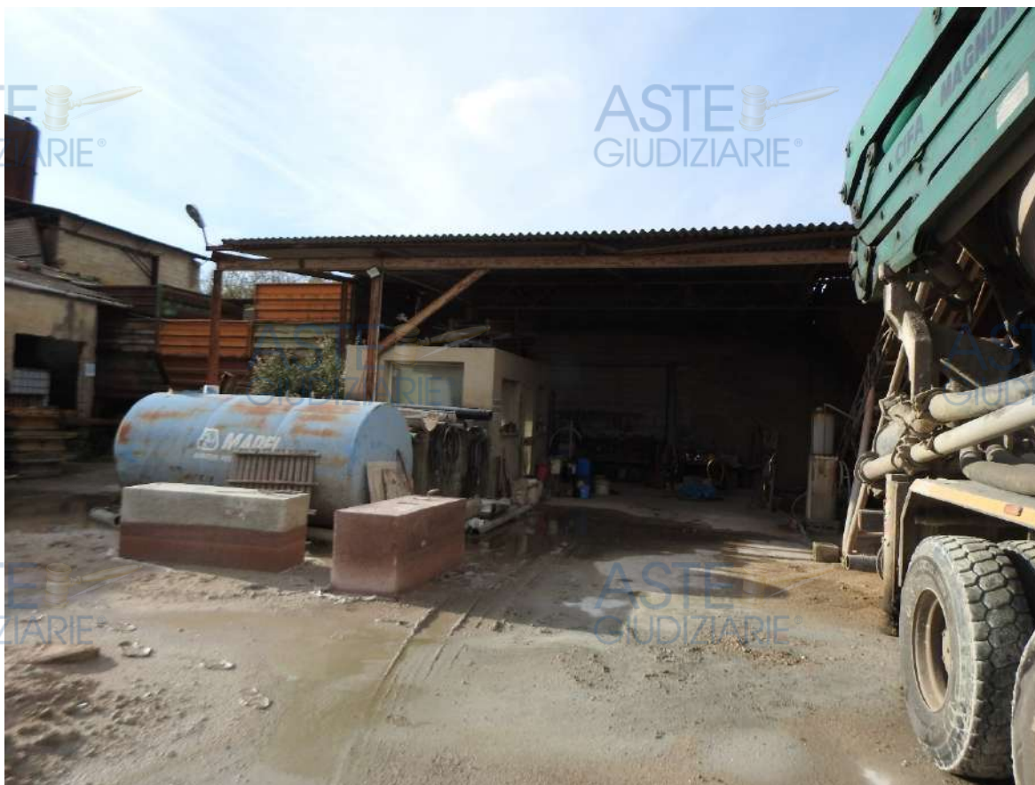
Figura 75 - Immobile 5 (tettoia operativa). Vista del prospetto principale.
