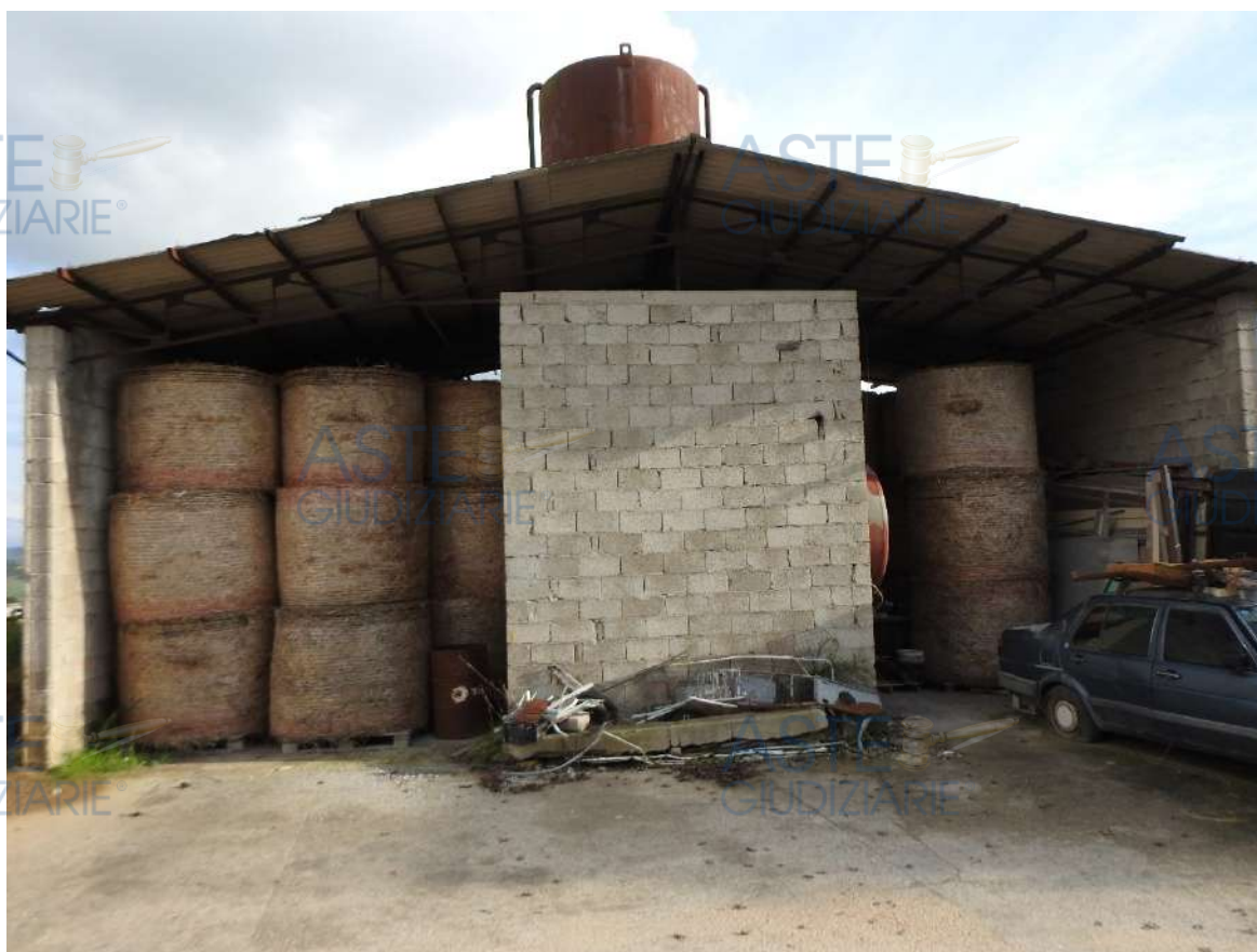
Figura 74 - Immobile 4 (capannone principale), blocco 4C.
