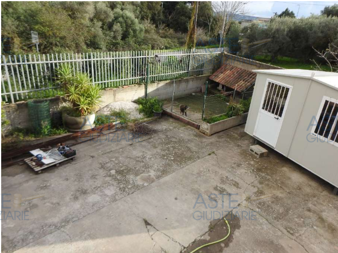
Figura 86 - Mappale 412 e relative installazioni. Visuale dalla palazzina verso SP44
