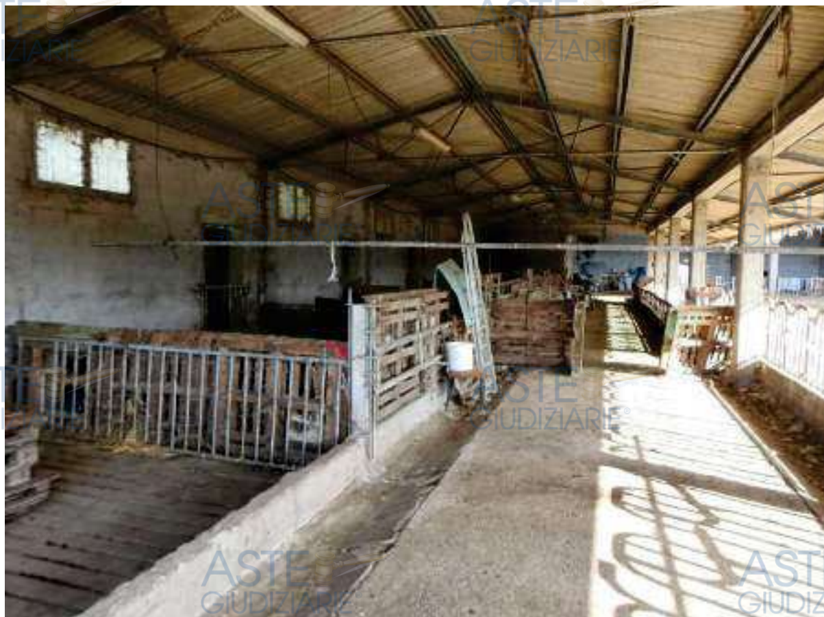
Figura 47 - Blocco D, visuale interna (da sudest verso nordovest)
