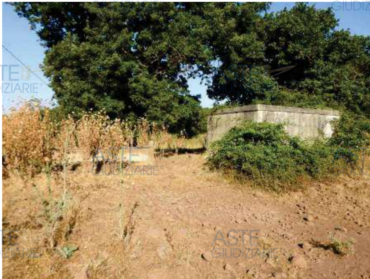
Figura 49 - Serbatoio idrico in c.a. con vicino abbeveratoio
