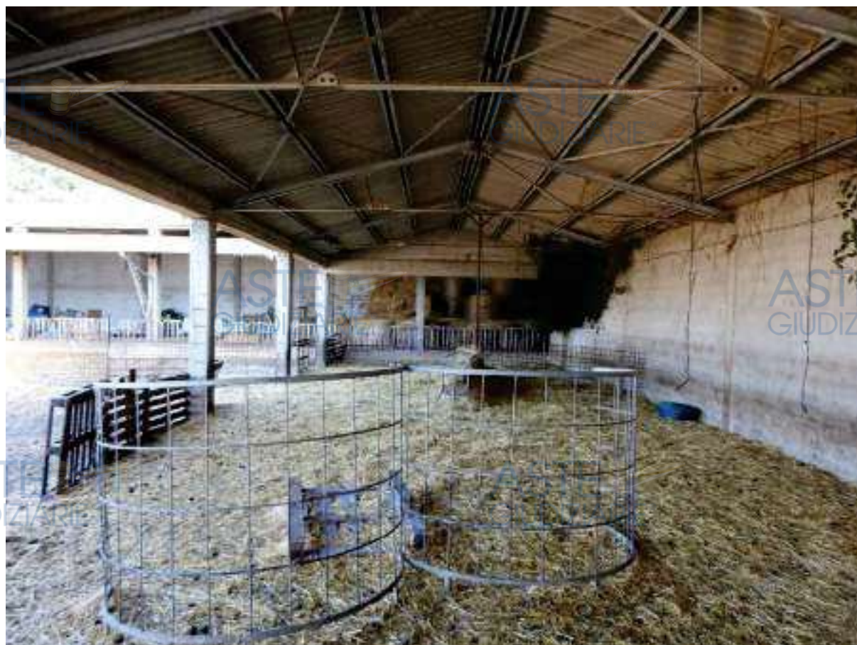
Figura 39 - Blocco B, visuale interna verso il Blocco C
