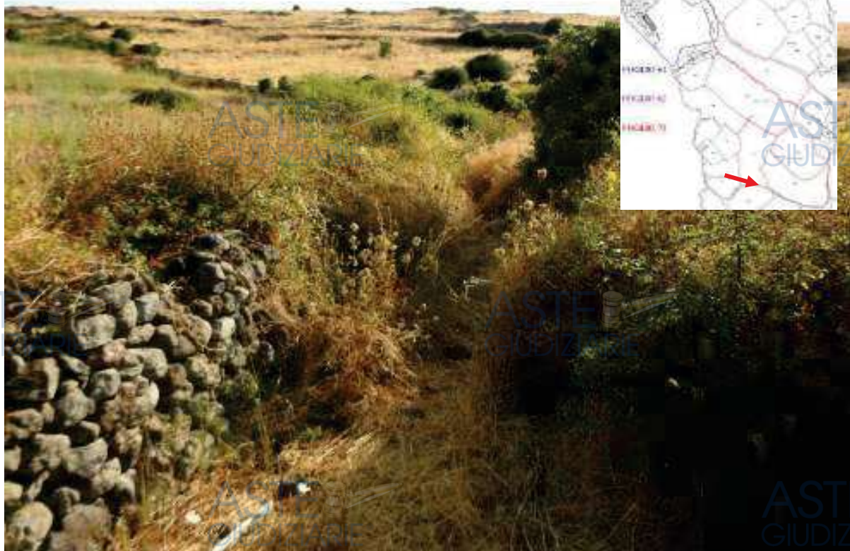
Figura 104 - Lotto 3, Porzione A. Str. Vic. Ziu Mialeddu, confine a sud e est in corrispondenza dei mappali 5, 6, 8
