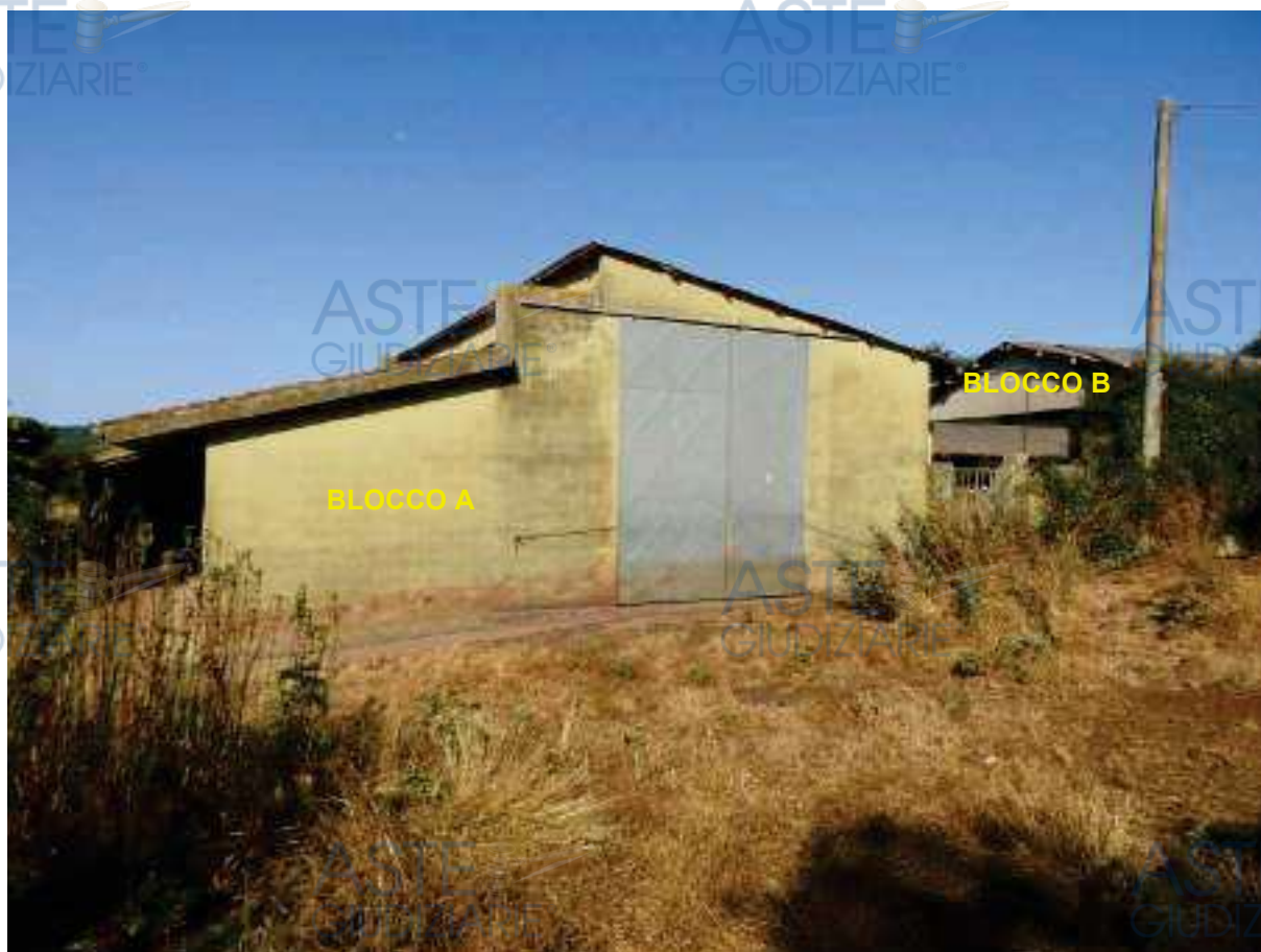
Figura 26 - Visuale del compendio di fabbricati agricoli dallo stradello sterrato di accesso (da est verso ovest)
