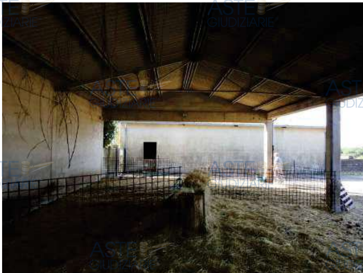
Figura 40 - Blocco B, visuale interna verso il Blocco A
