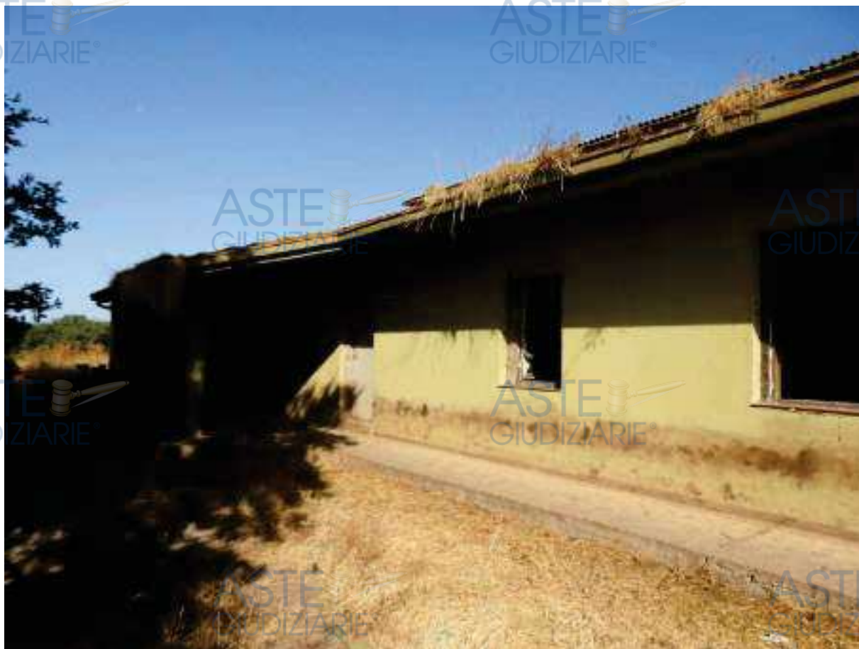
Figura 33 - Blocco A, facciata principale
