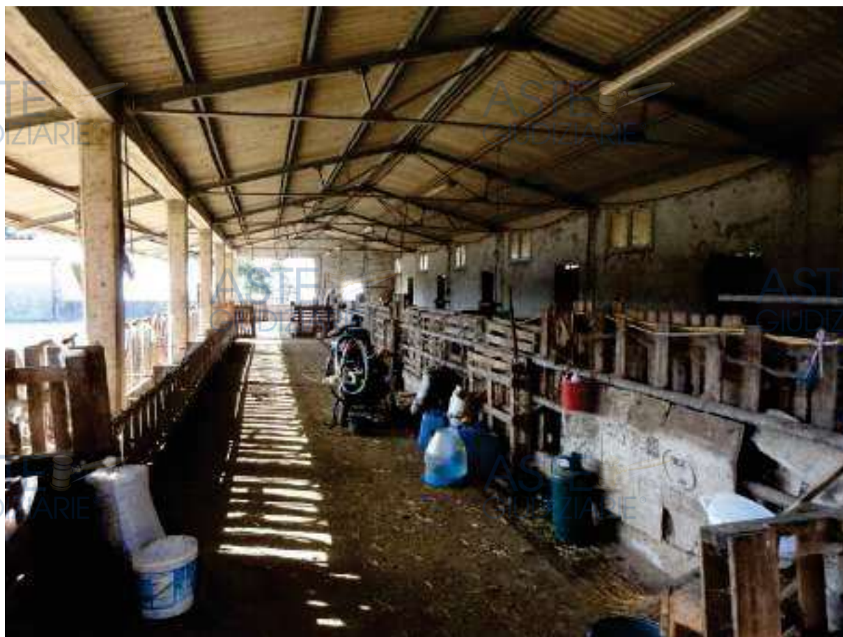
Figura 46 - Blocco D, visuale interna (da nordovest verso sudest)
