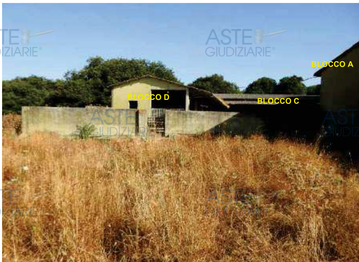
Figura 27 - Visuale del compendio di fabbricati agricoli dallo stradello sterrato di accesso (da sud verso nord)
