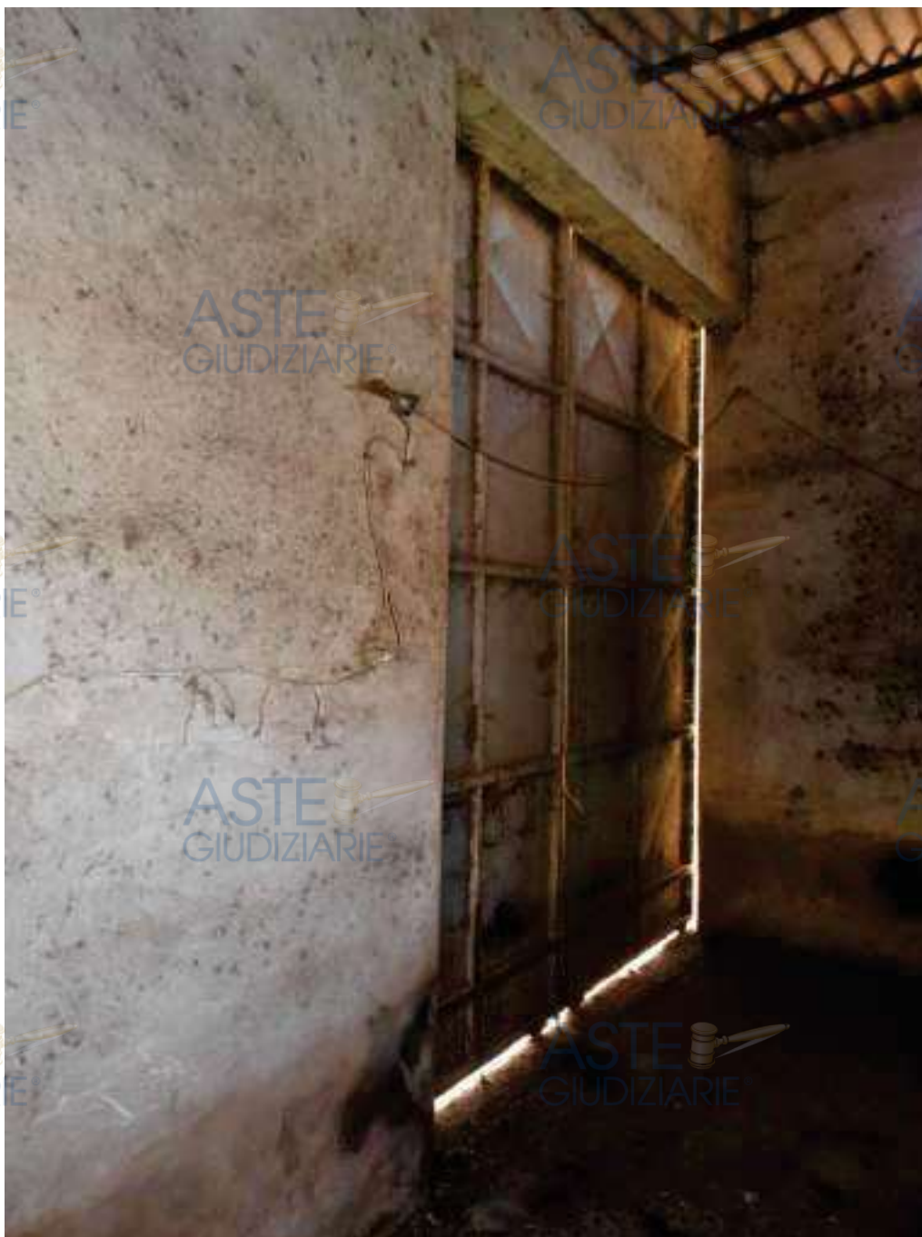
Figura 35 - Blocco A, visuale interna della zona deposito scorte
