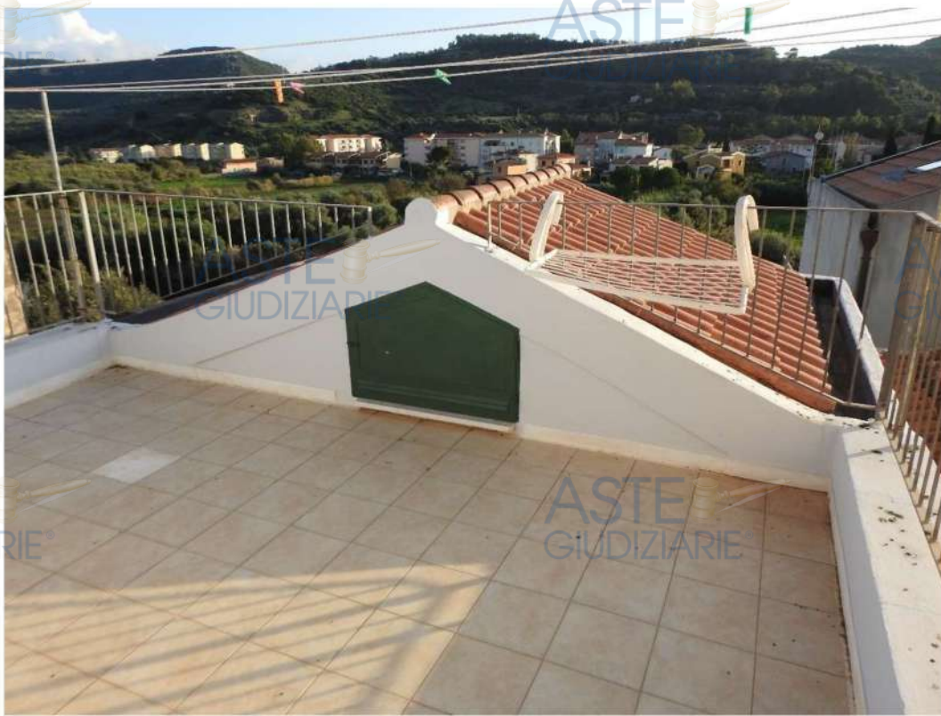
Figura 20 - Terrazza condominiale (abusiva). Visuale dalla porta finestra
