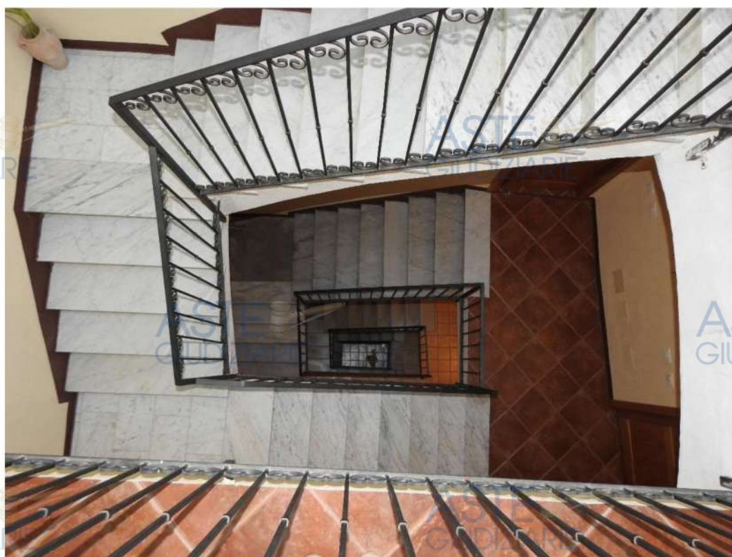
Figura 19 - Vano scala comune (BCNC sub. 11). Visuale dall'alto
