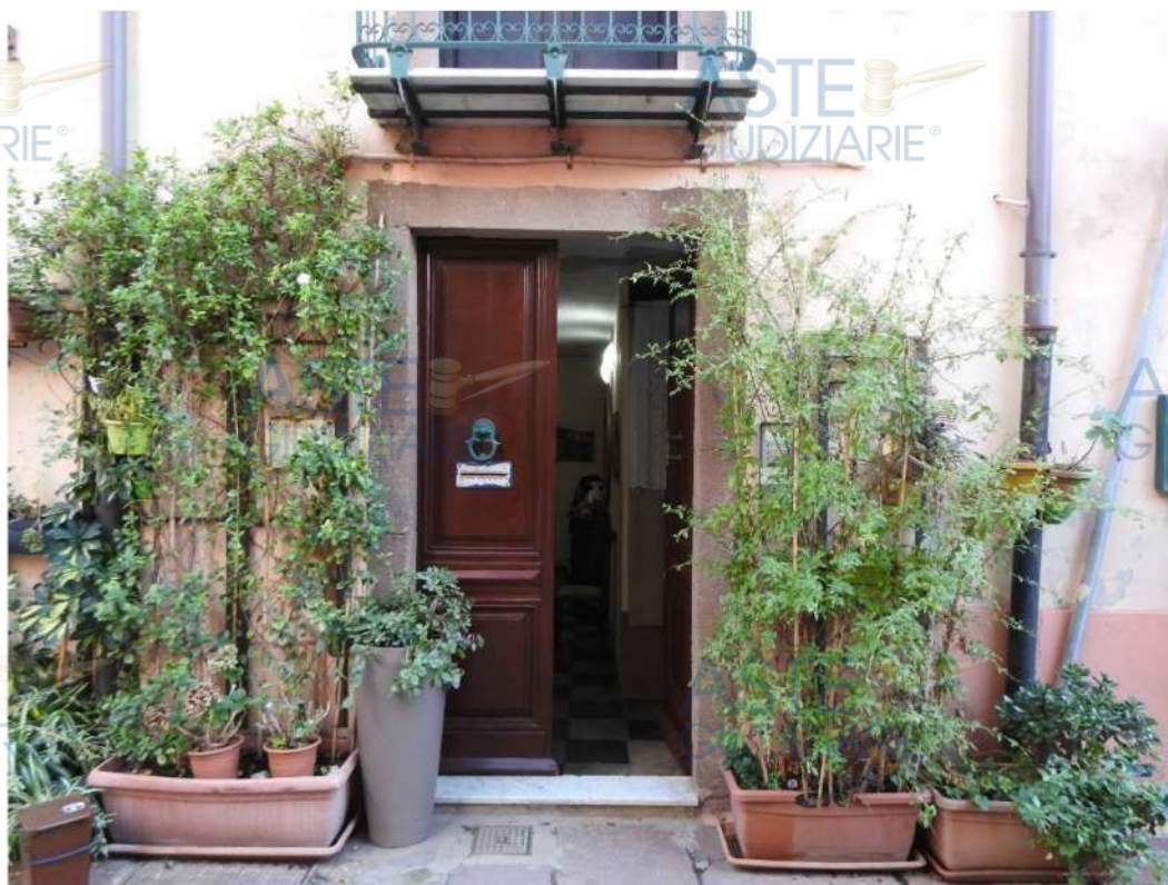
Figura 7 - Ingresso principale, corso Vittorio Emanuele II n.6
