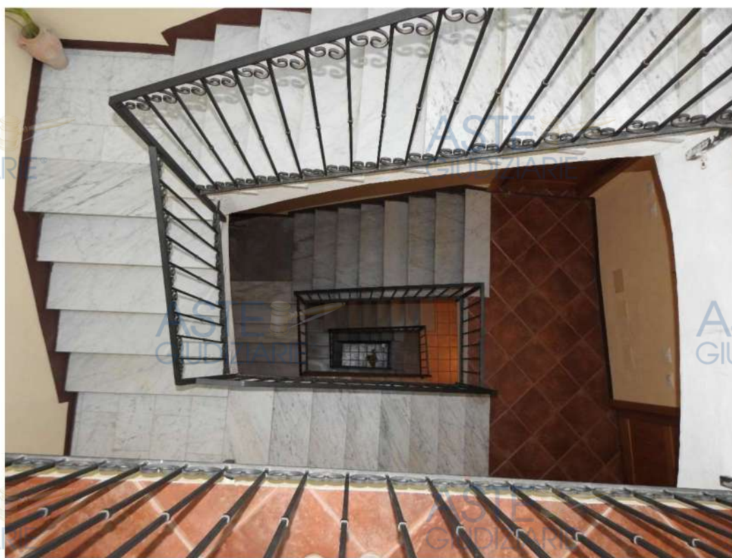
Figura 19 - Vano scala comune (BCNC sub. 11). Visuale dall'alto
