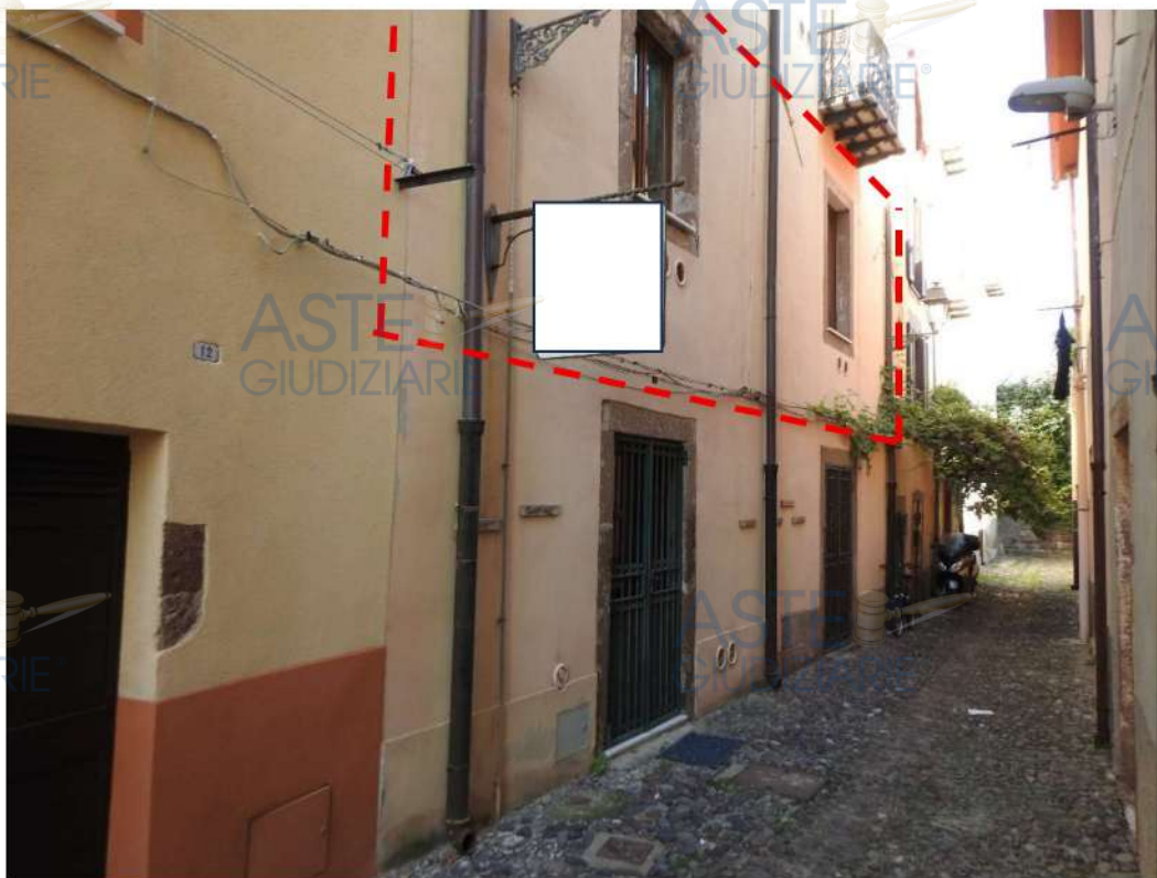
Figura 38 - Lotto 2, visuale esterna dalla via Santa Giusta
