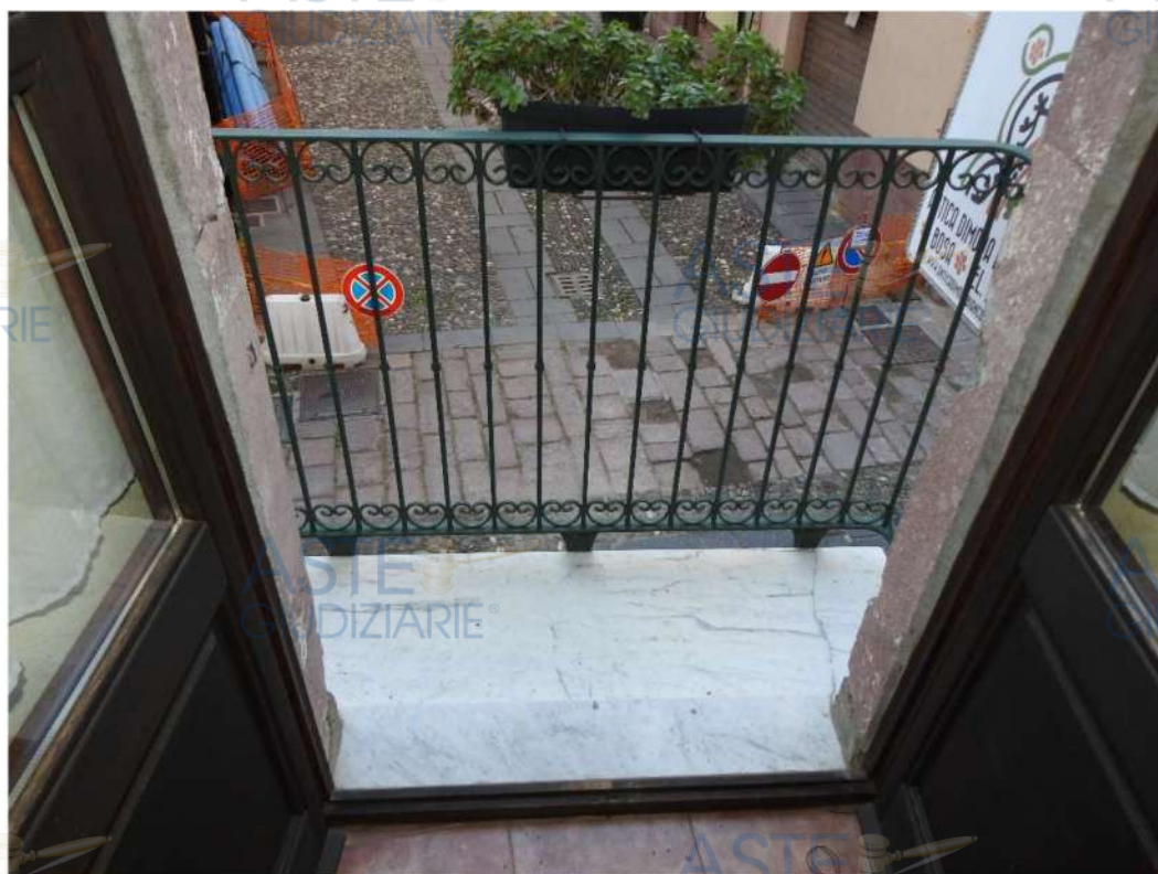
Figura 60 - Poggiolo camera 1 interno 3
