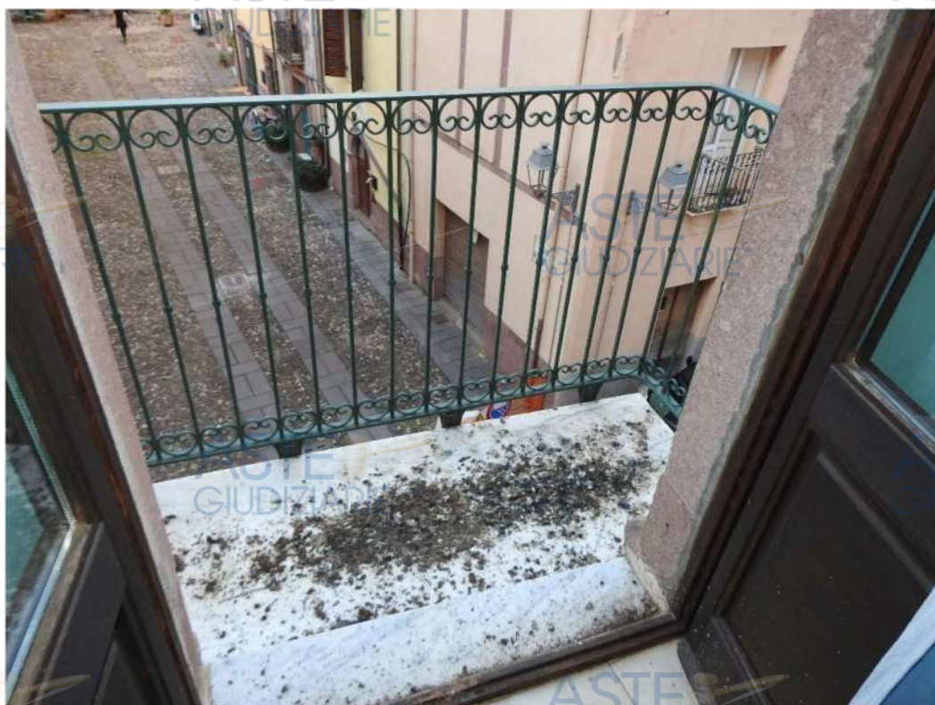
Figura 69 - Poggiolo camera interno 6
