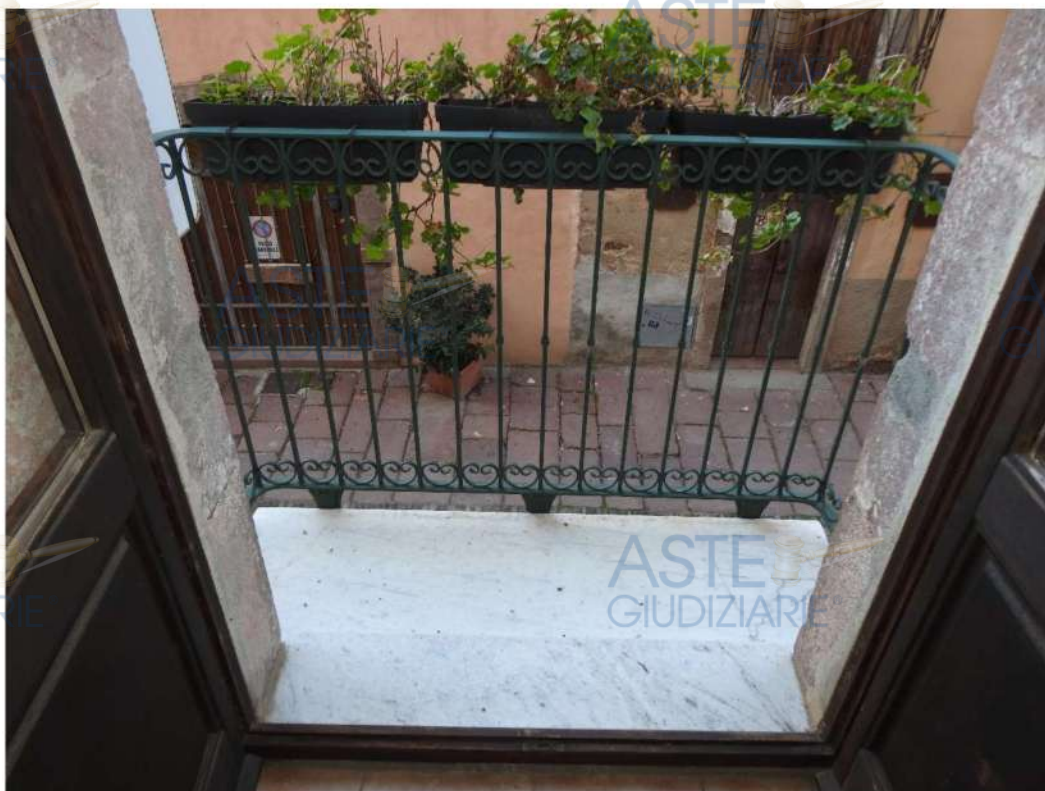
Figura 53 - Poggiolo camera interno 2
