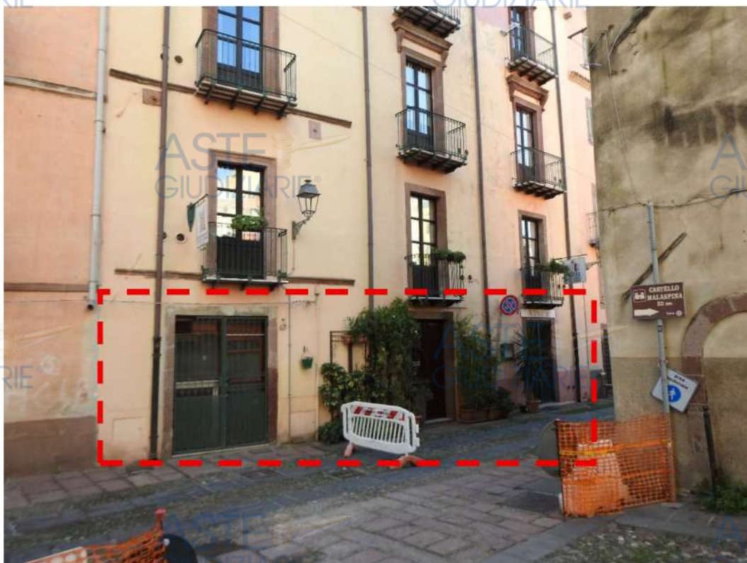
Figura 35 - Lotto 1, visuale esterna dal Corso Vittorio Emanuele II
