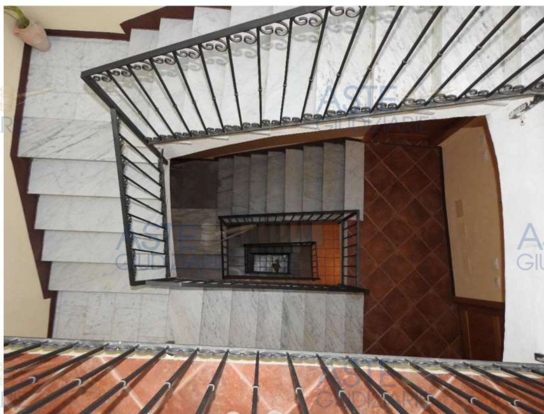
Figura 19 - Vano scala comune (BCNC sub. 11). Visuale dall'alto
