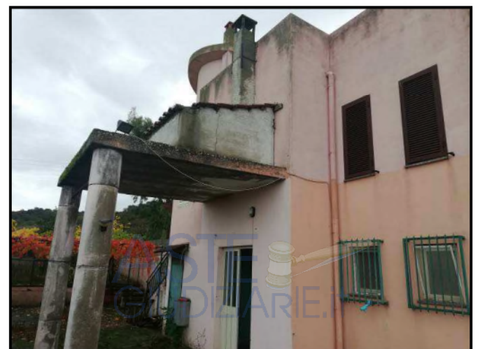
Foto 19 - Ingresso lato nord piano terra - seminterrato
