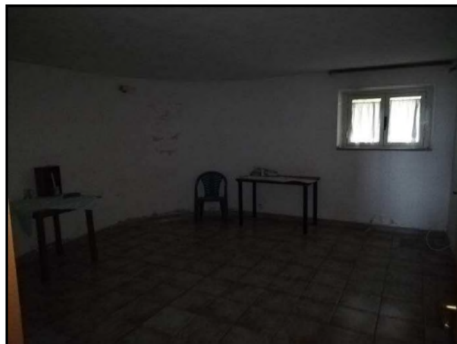
Foto 11 – Magazzino 1 piano terra - seminterrato
