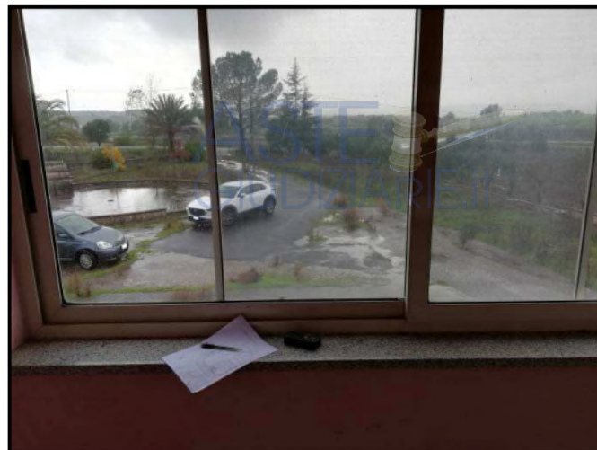
Foto 4 - Interno veranda 1 ingresso principale
