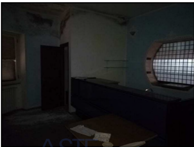
Foto 24 - Zona bar e ingresso servizi igienici bar
