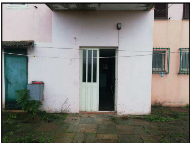
Foto 18 - Ingresso lato nord piano terra - seminterrato
