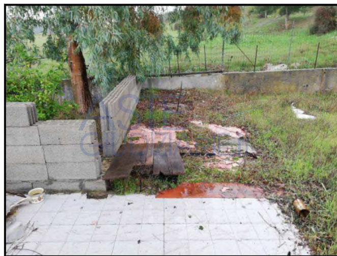
Foto 9 - Area servizi igienici demoliti
