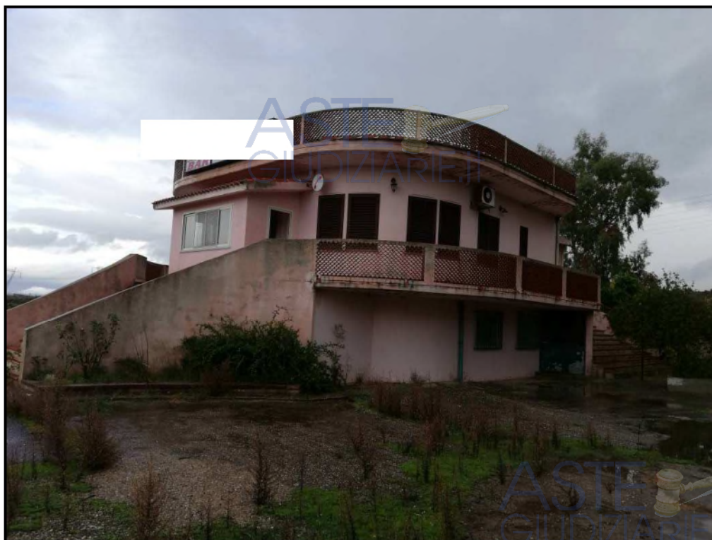
Foto 2 - Prospetto laterale sud
