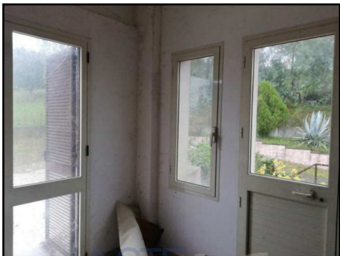
Foto 6 - Passaggio coperto ingresso lato sud
