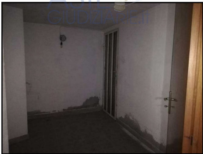
Foto 16 - Disimpegno piano terra - seminterrato
