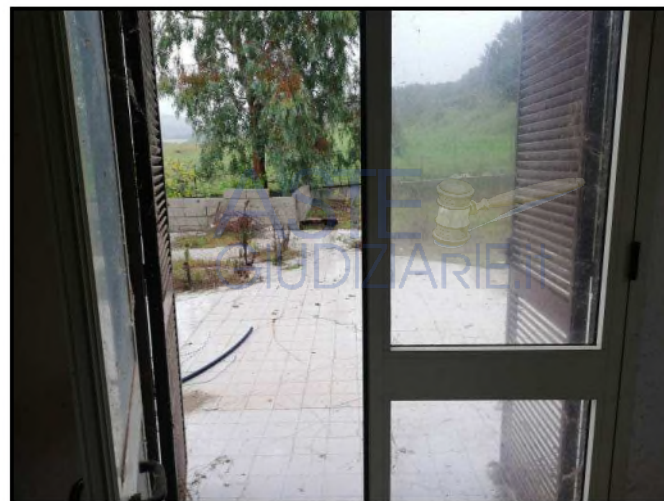
Foto 7 - Uscita verso vecchia area in ampliamento demolita
