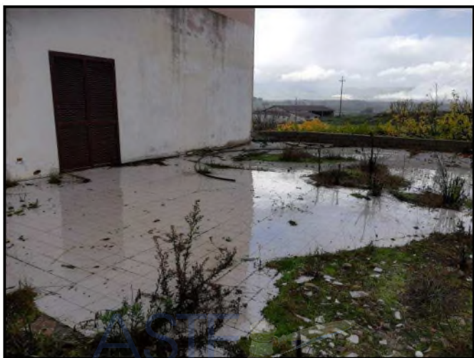
Foto 8 - Pavimentazione sala in ampliamento demolita
