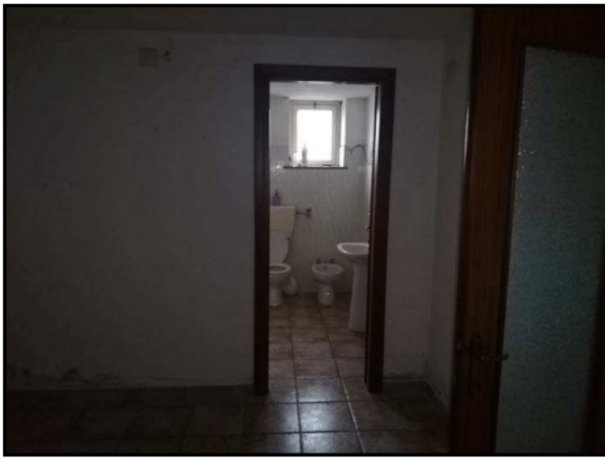
Foto 14 - Bagni per il personale piano terra - seminterrato
