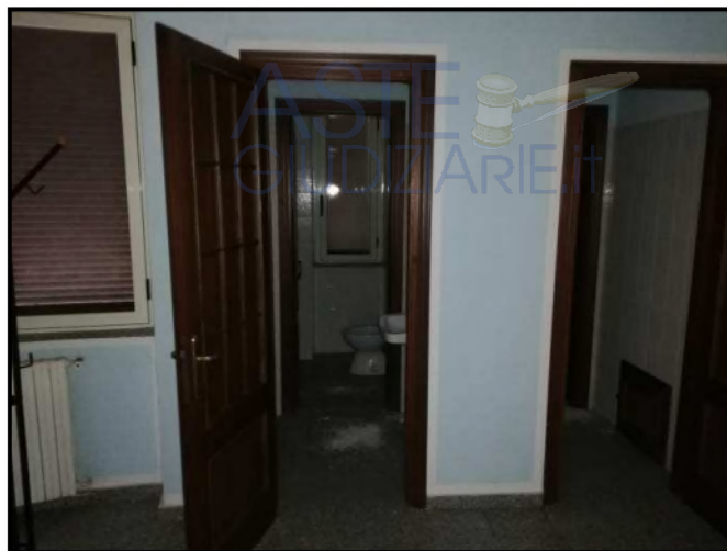
Foto 21 - Bagni sala ristorante
