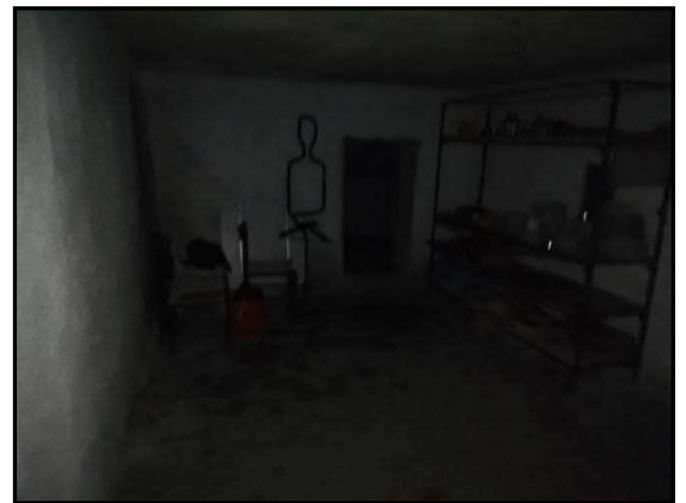
Foto 17 - Cantina piano terra - seminterrato
