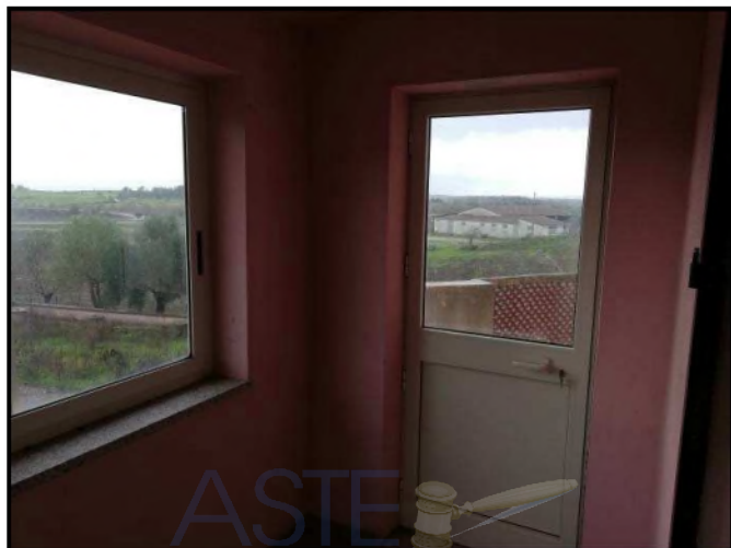
Foto 3 - Interno veranda 1 ingresso principale
