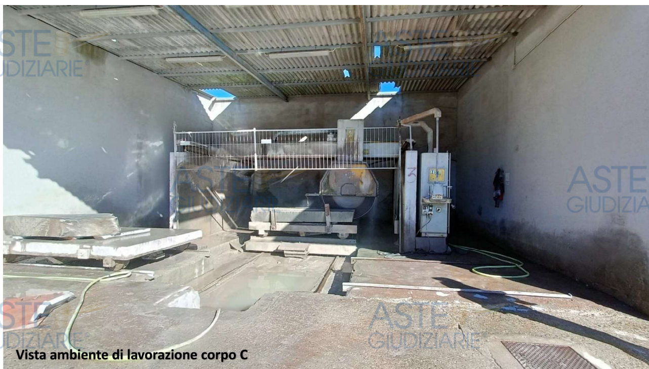
Vista generale tettoia corpo C
