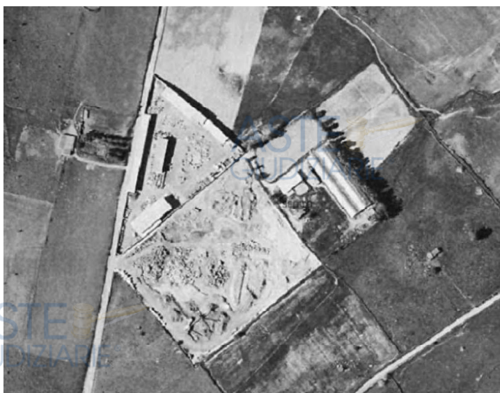
ortofoto satellitare 2003 presenza della prima edificazione
