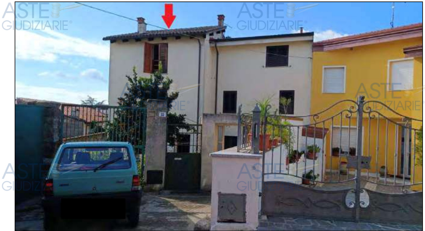
Foto N. 1 Vista dalla Via Savoia
