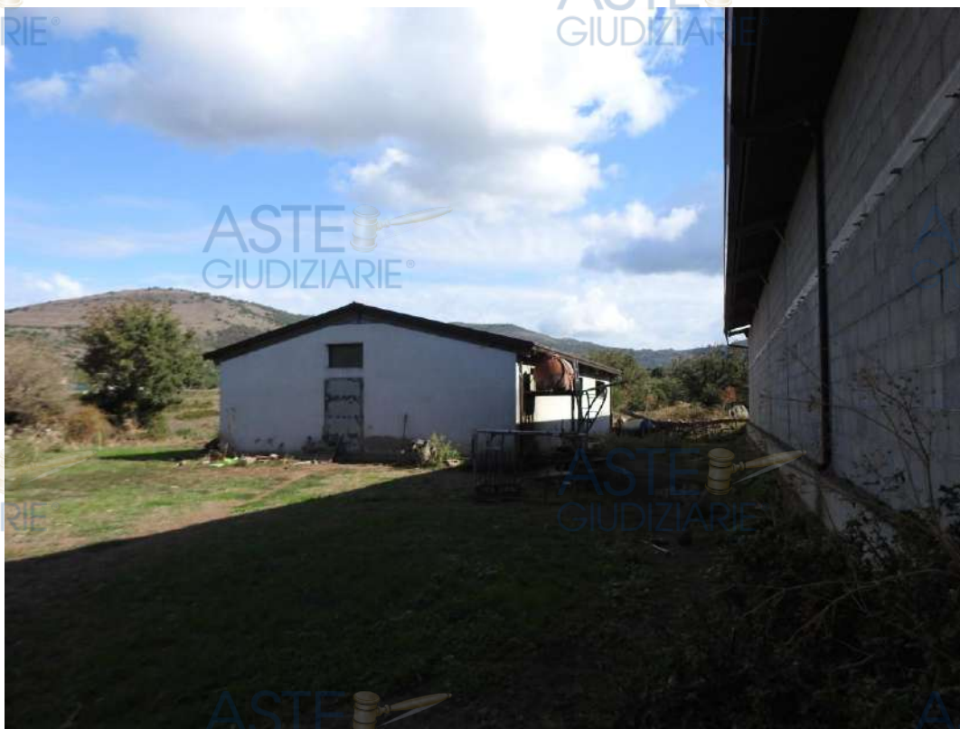
Figura 62 - Fabbricato F. Porcilaia
