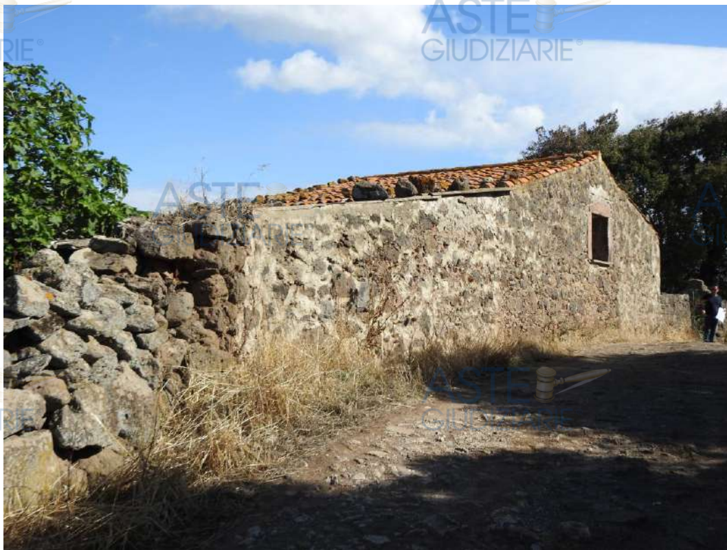
Figura 51 – Casa rurale, visuale dalla limitrofa strada vicinale
