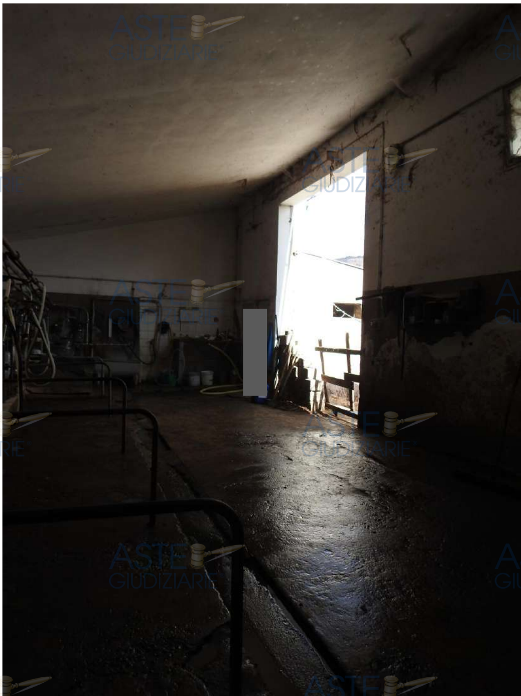
Figura 30 - Fabbricato A, minicaseificio. Foto interna sala mungitura
