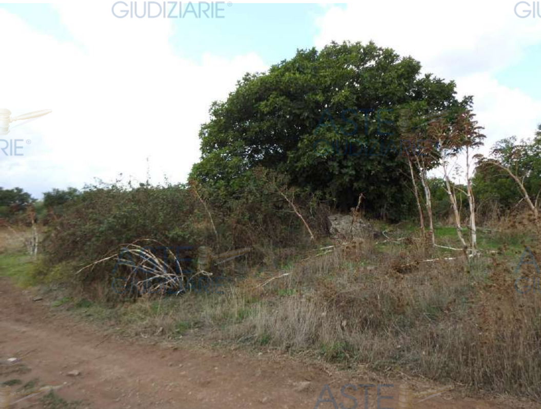
Figura 20 - Fabbricato E. Casa rurale distrutta
