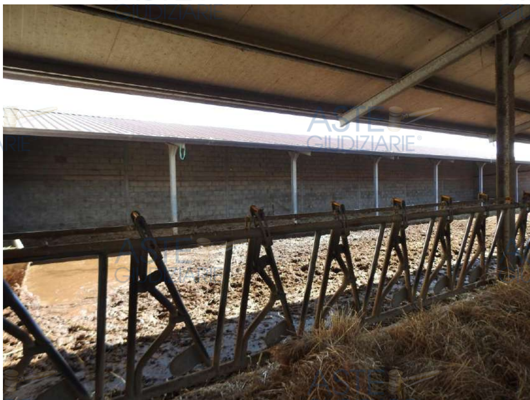
Figura 59 – Fabbricato D, fienile/stalla. Visuale interna
