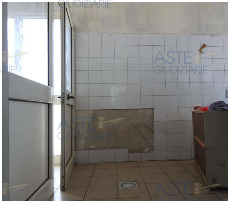
Figura 35 - Fabbricato A, minicaseificio. Foto interna zona ingresso, particolare rivestimento deteriorato
