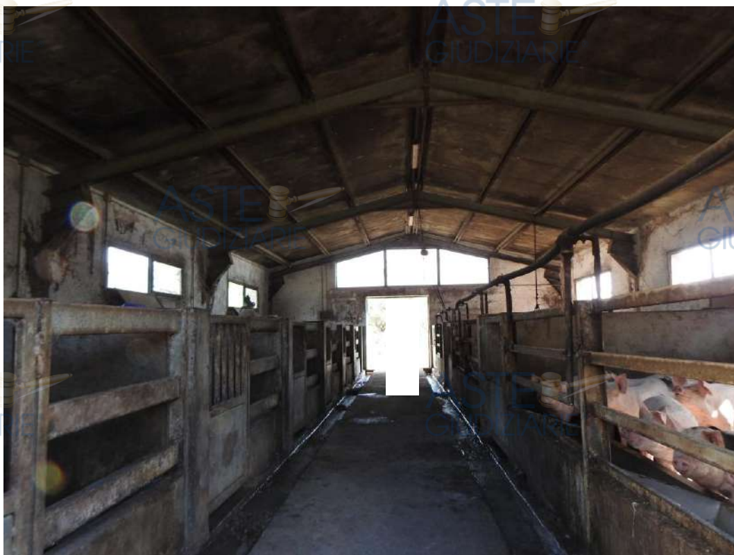
Figura 64- Fabbricato F. Porcilaia
