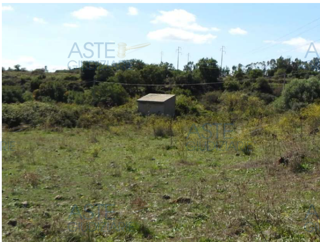
Figura 18 - Fabbricato I, ricovero isolato
