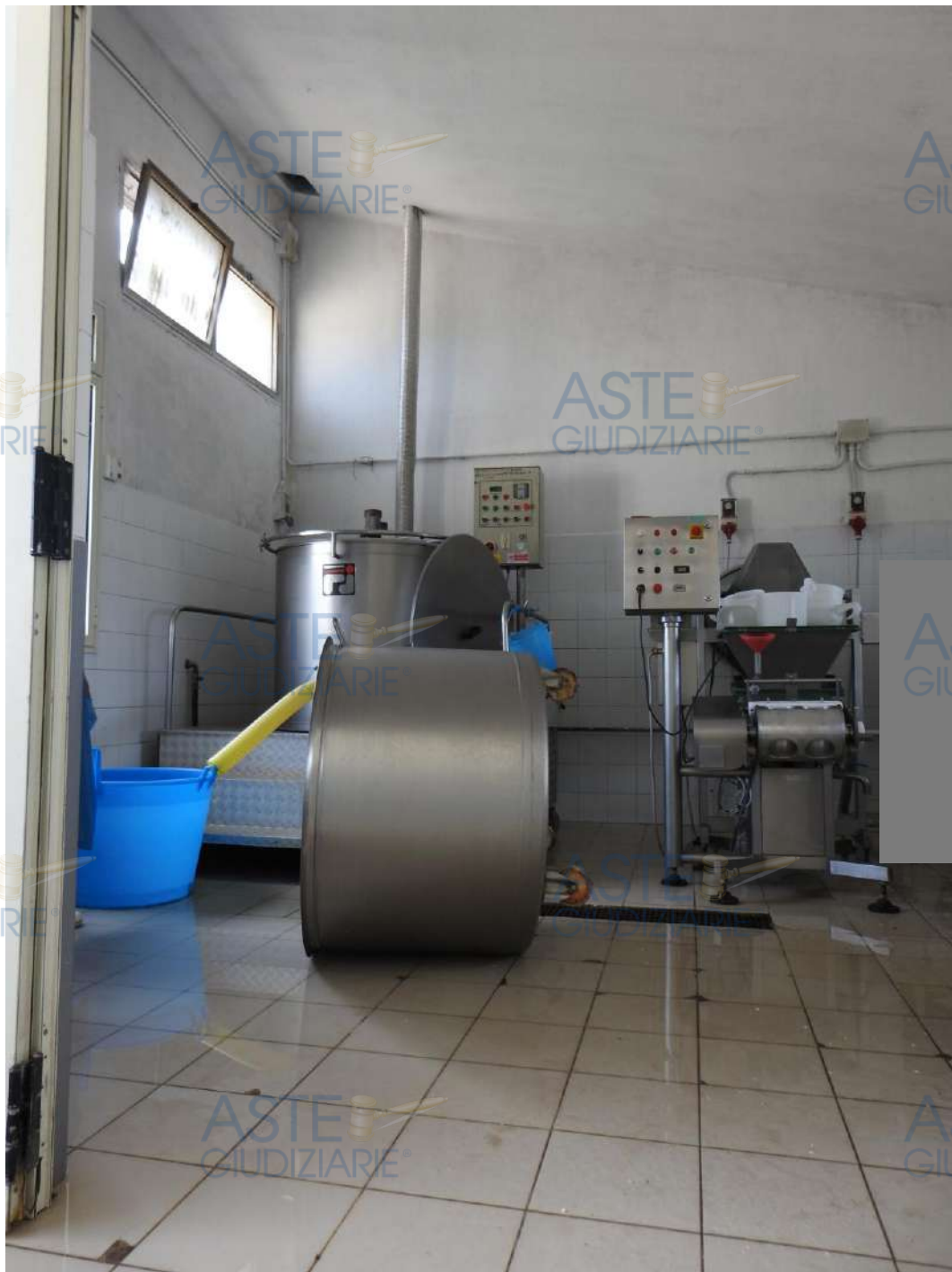
Figura 28 - Fabbricato A, minicaseificio. Foto interna sala lavorazione
