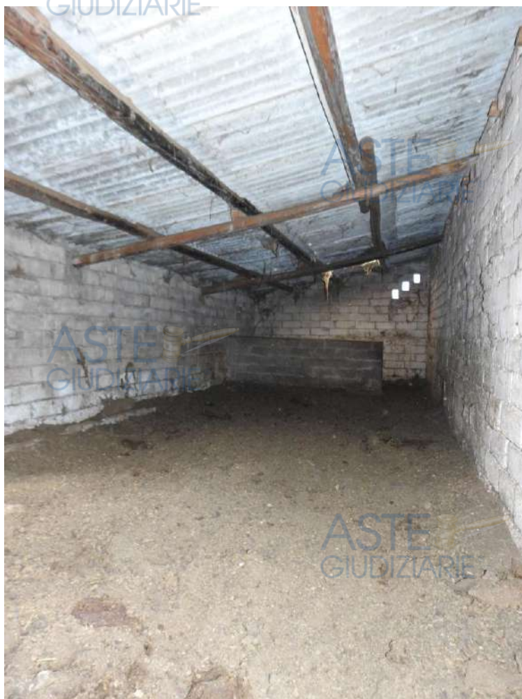
Figura 69 – Fabbricato G. Stalla/fienile vecchia. Fienile
