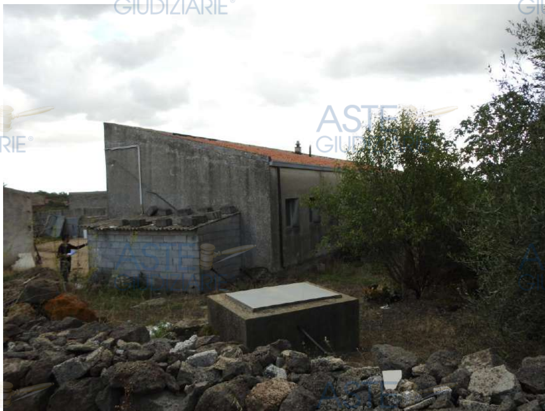
Figura 25 - Fabbricato A, minicaseificio. Vista del prospetto secondario
