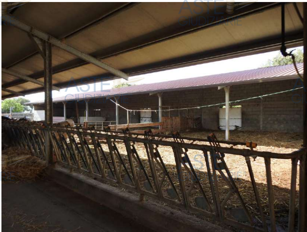
Figura 58 – Fabbricato D, fienile/stalla. Visuale interna
