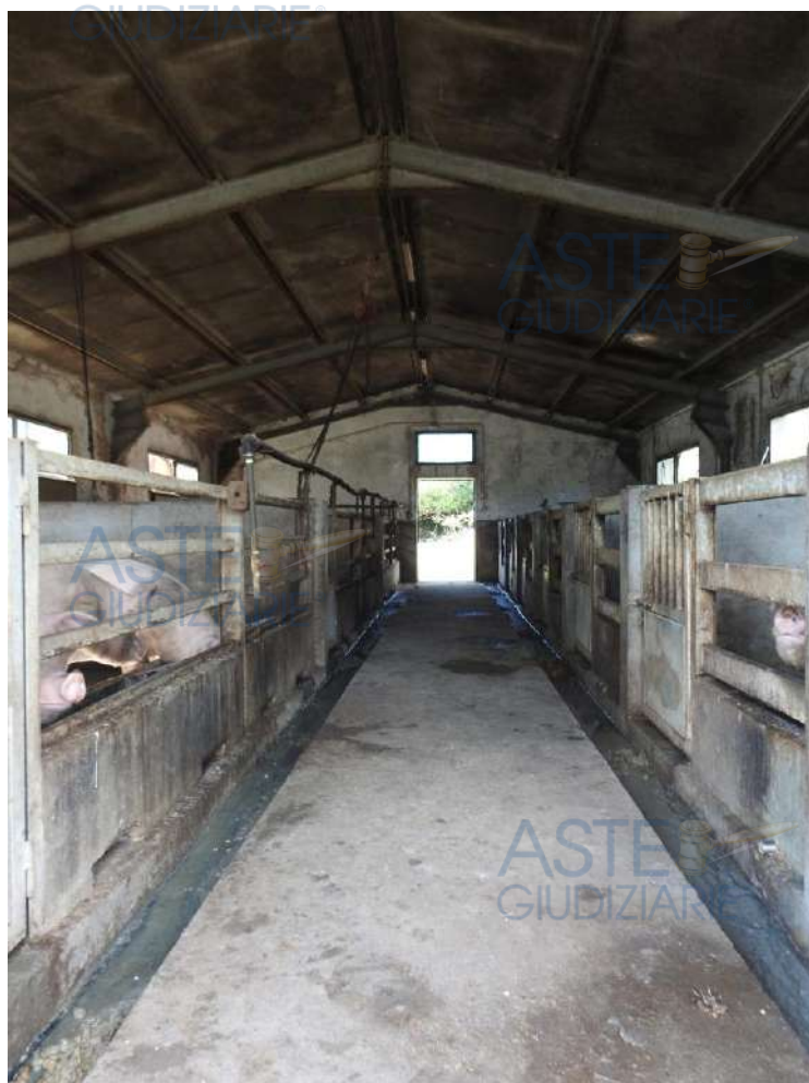
Figura 65 – Fabbricato F. Porcilaia
