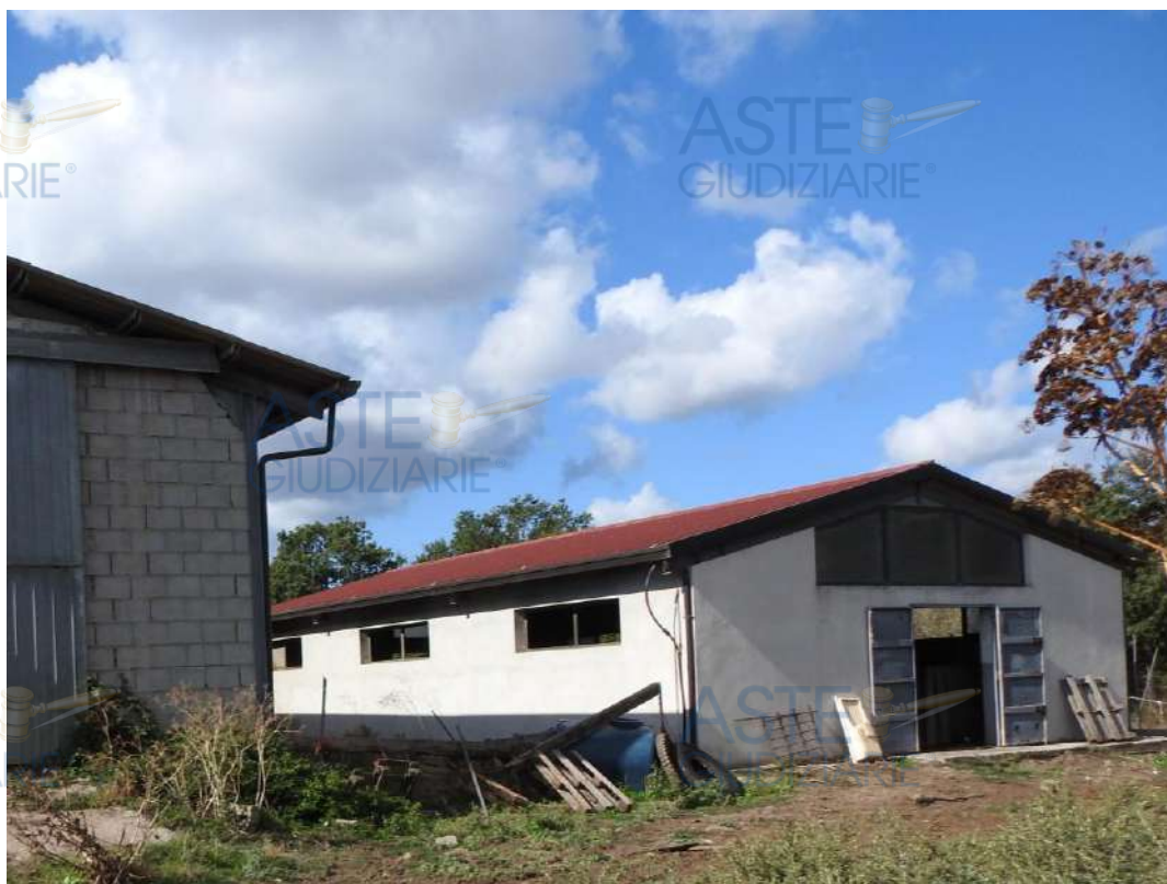
Figura 63- Fabbricato F. Porcilaia
