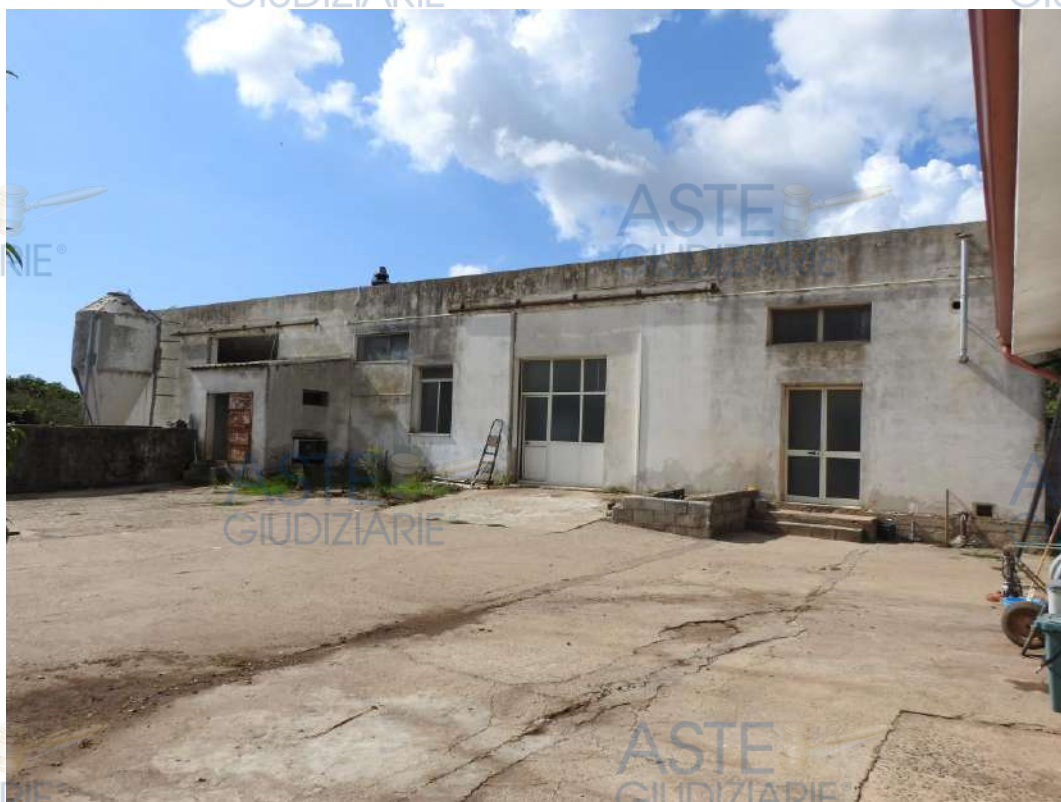
Figura 23 - Fabbricato A, minicaseificio. Vista frontale
