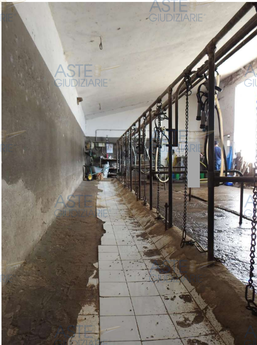
Figura 31 - Fabbricato A, minicaseificio. Foto interna sala mungitura
