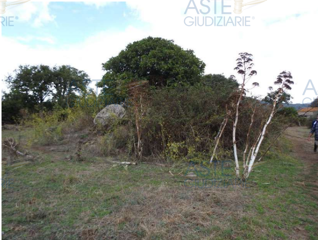
Figura 19 - Fabbricato E. Casa rurale distrutta
