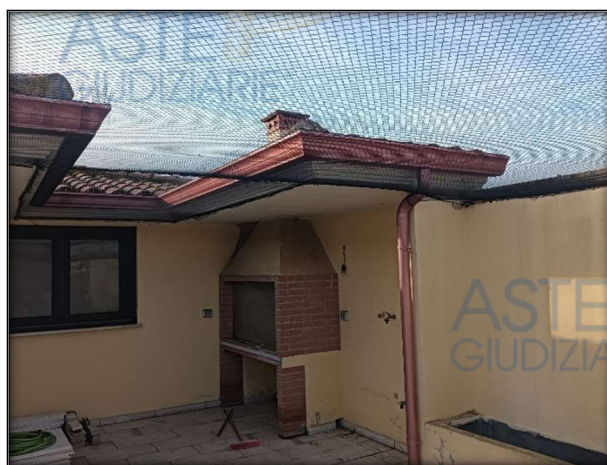
Foto 14 – Barbecue e porzione copertura a protezione
