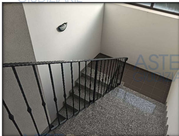
Foto 6 – Rampe di collegamento tra i piani
