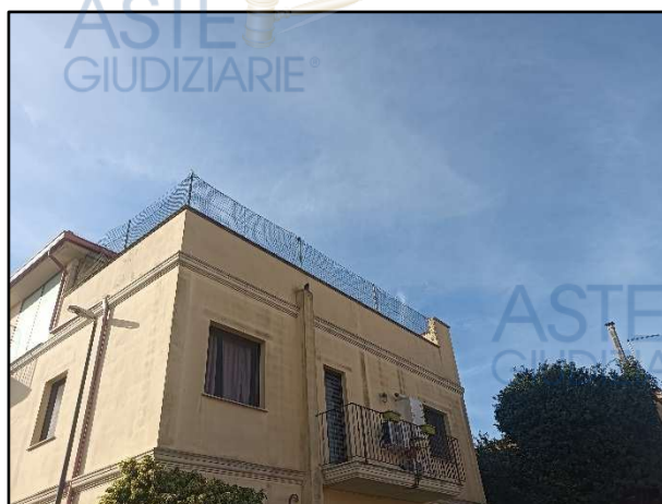
Foto 4 – Prospetto est verso cortile interno al fabbricato
