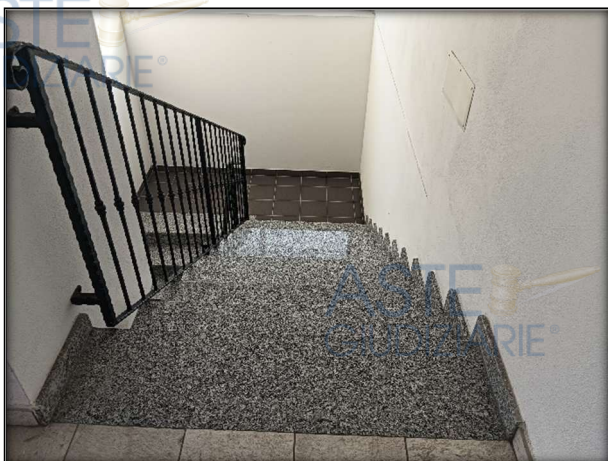
Foto 7 – Rampe di collegamento tra i piani
