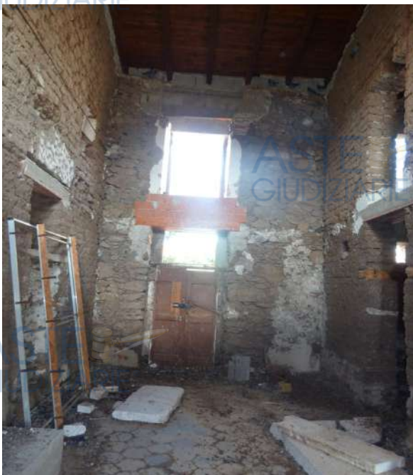
Foto ingresso al vano principale
