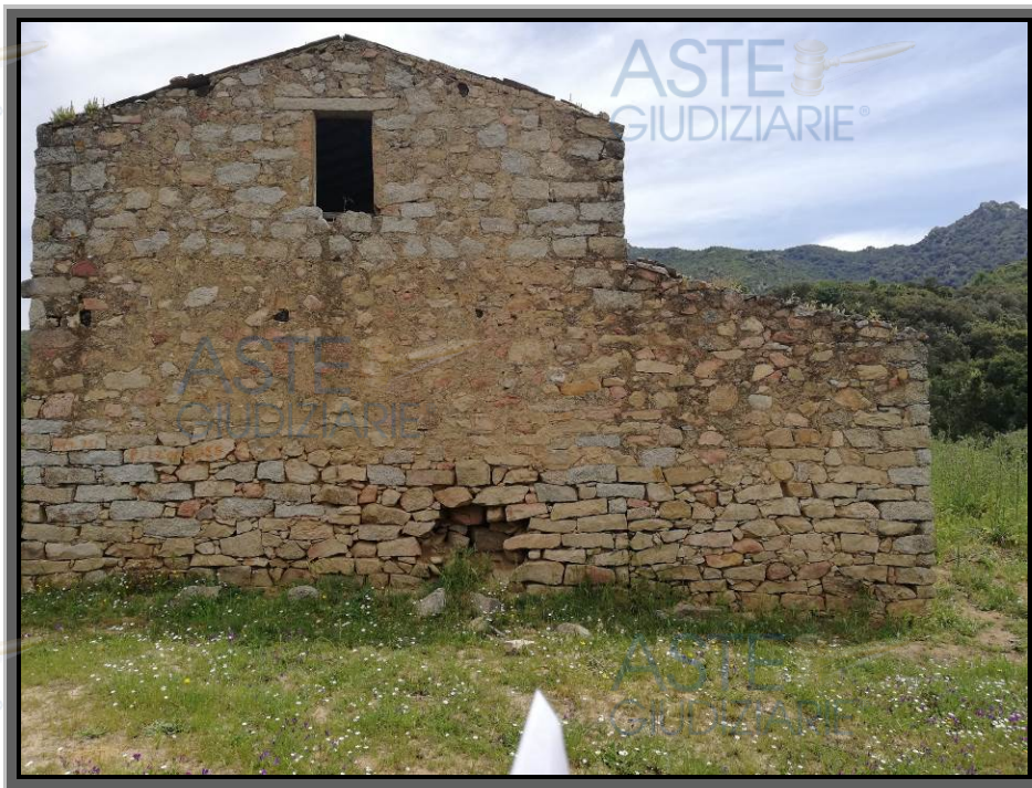
Foto 7 – Particolare fabbricato “Casa Carta” – Mappale 65 – Vista 2
