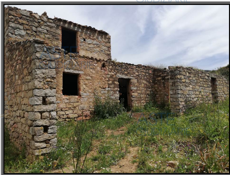
Foto 6 – Particolare fabbricato "Casa Carta" – Mappale 65 – Vista 1
