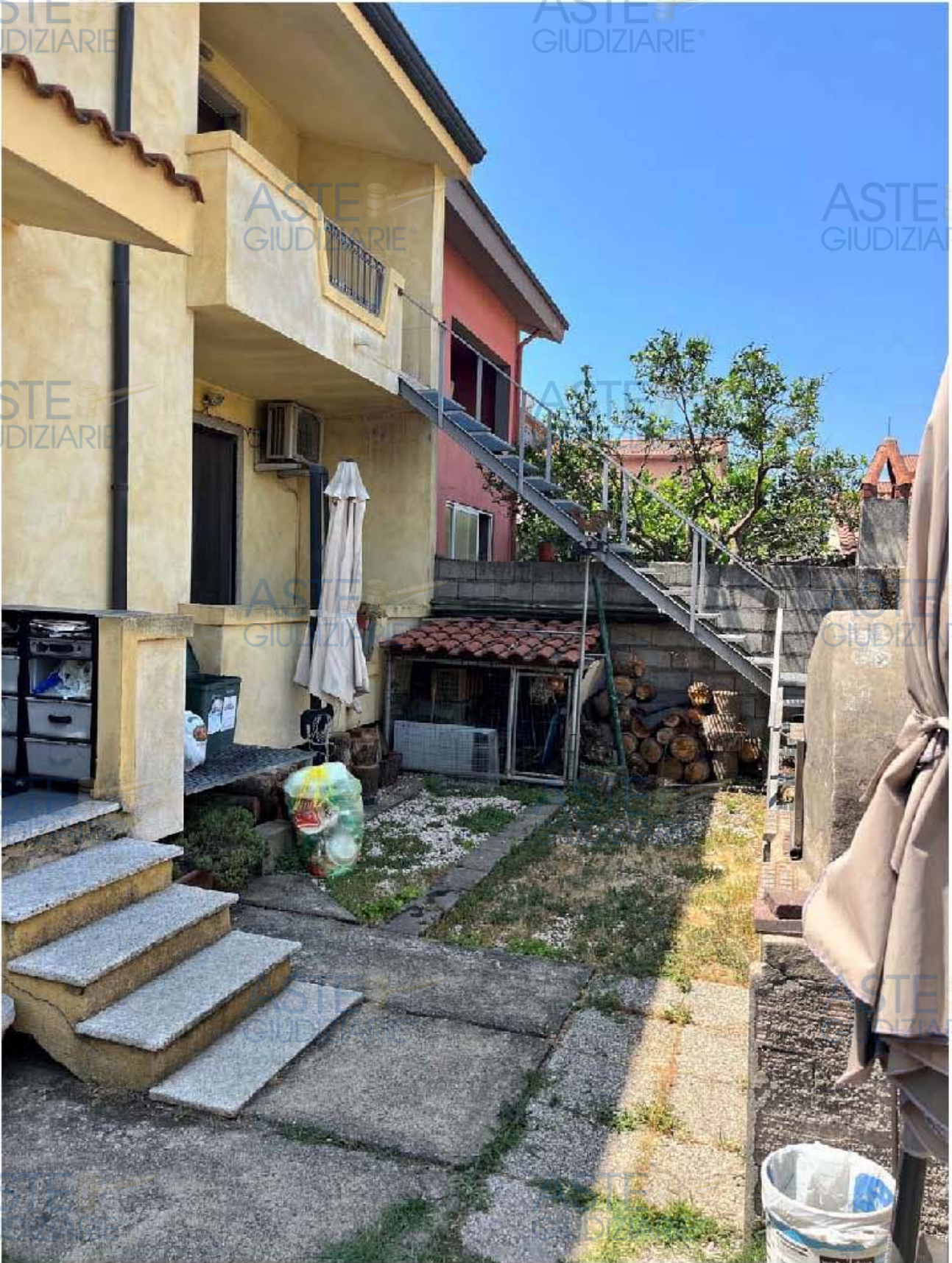
Prospetto posteriore ovest
