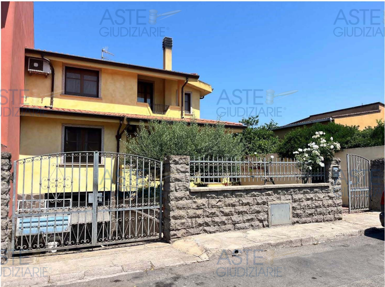
Prospetto principale sulla via Terranova
