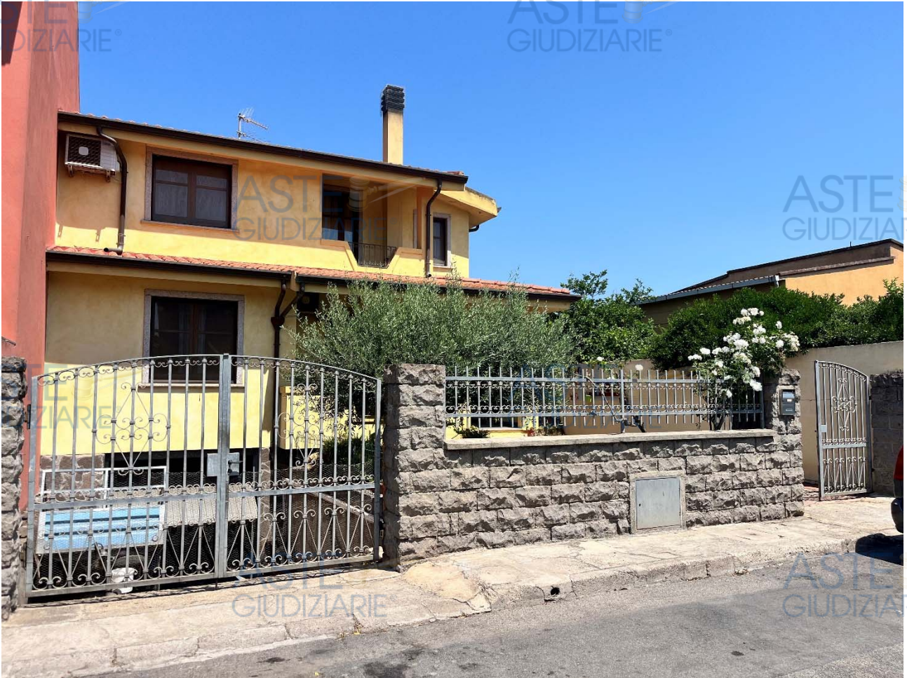
Prospetto principale sulla via Terranova
