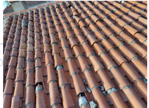
COPERTURA ABITAZIONE (con tetto a falde e manto in coppi)
