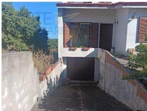
Foto 2 – Prospetto Via Mannu – Ingresso piano seminterrato
