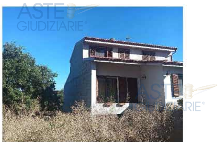
Foto 6 – Lato passeggiata Sos Molinos – Interno cortile
