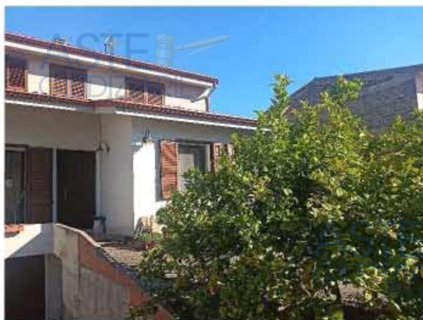
Foto 4 – Prospetto Via Mannu – Vista interno cortile
