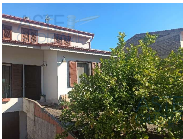
Foto 4 – Prospetto Via Mannu – Vista interno cortile
