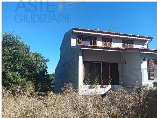
Foto 6 – Lato passeggiata Sos Molinos – Interno cortile
