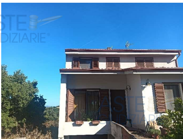
Foto 3 – Prospetto Via Mannu – Vista interno cortile
