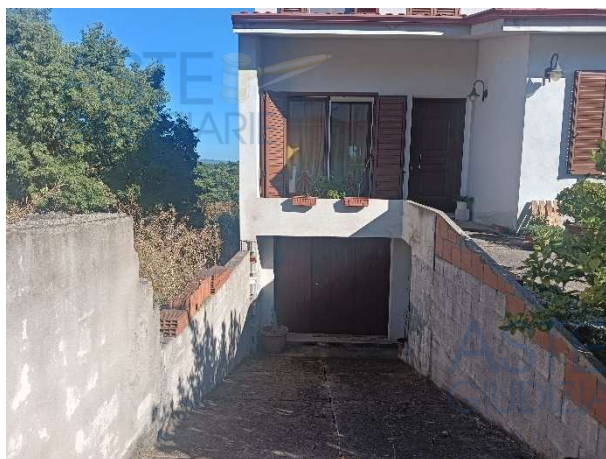
Foto 2 – Prospetto Via Mannu – Ingresso piano seminterrato
