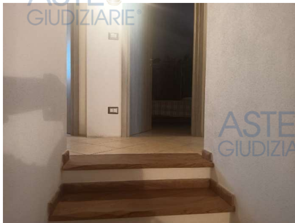
Foto 18 – Scale collegamento piano terra e primo piano
