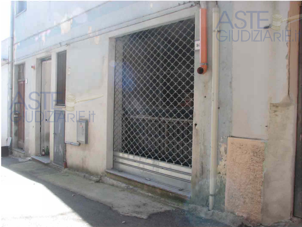
Viste ingresso dalla Via Tempio
