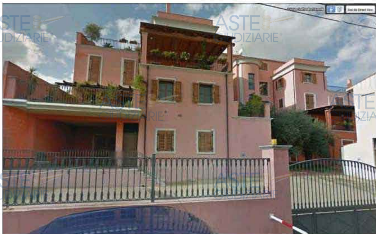
foto vista esterna frontale dell'edificio dalla via G. Mameli
