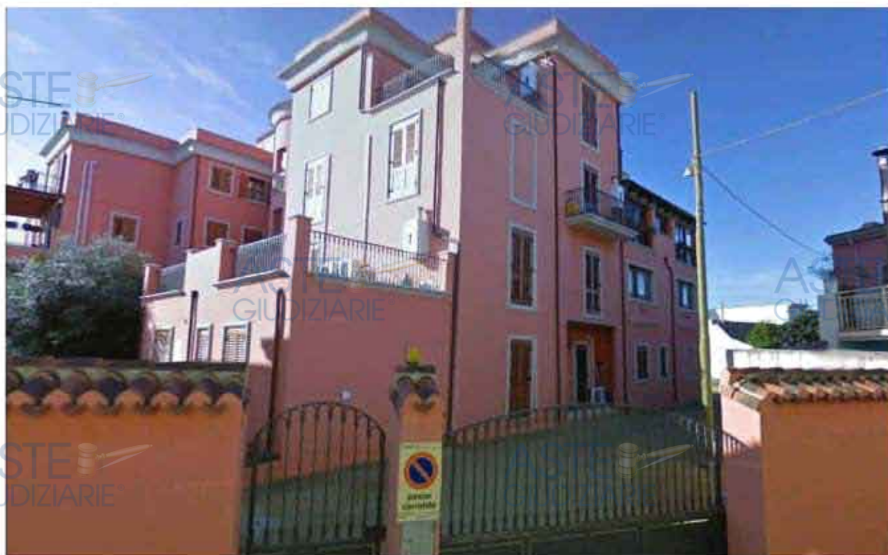
foto vista esterna altri lati dell'edificio dalla via G. Mameli
