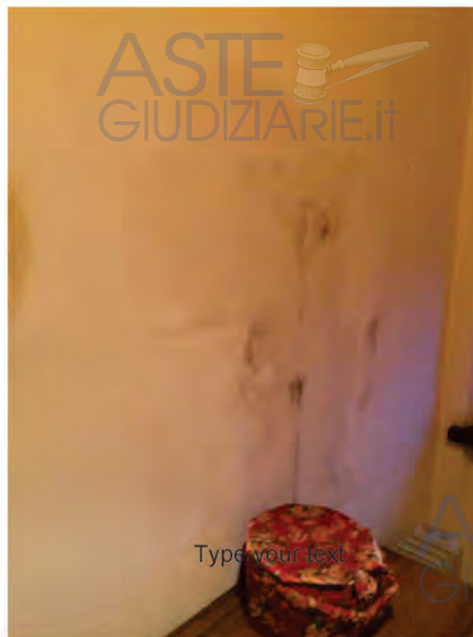
Immagine 16: Infiltrazione
