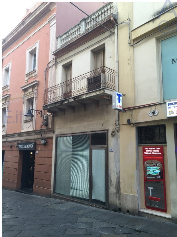
Foto 1: Esterno, C.so Garibaldi
